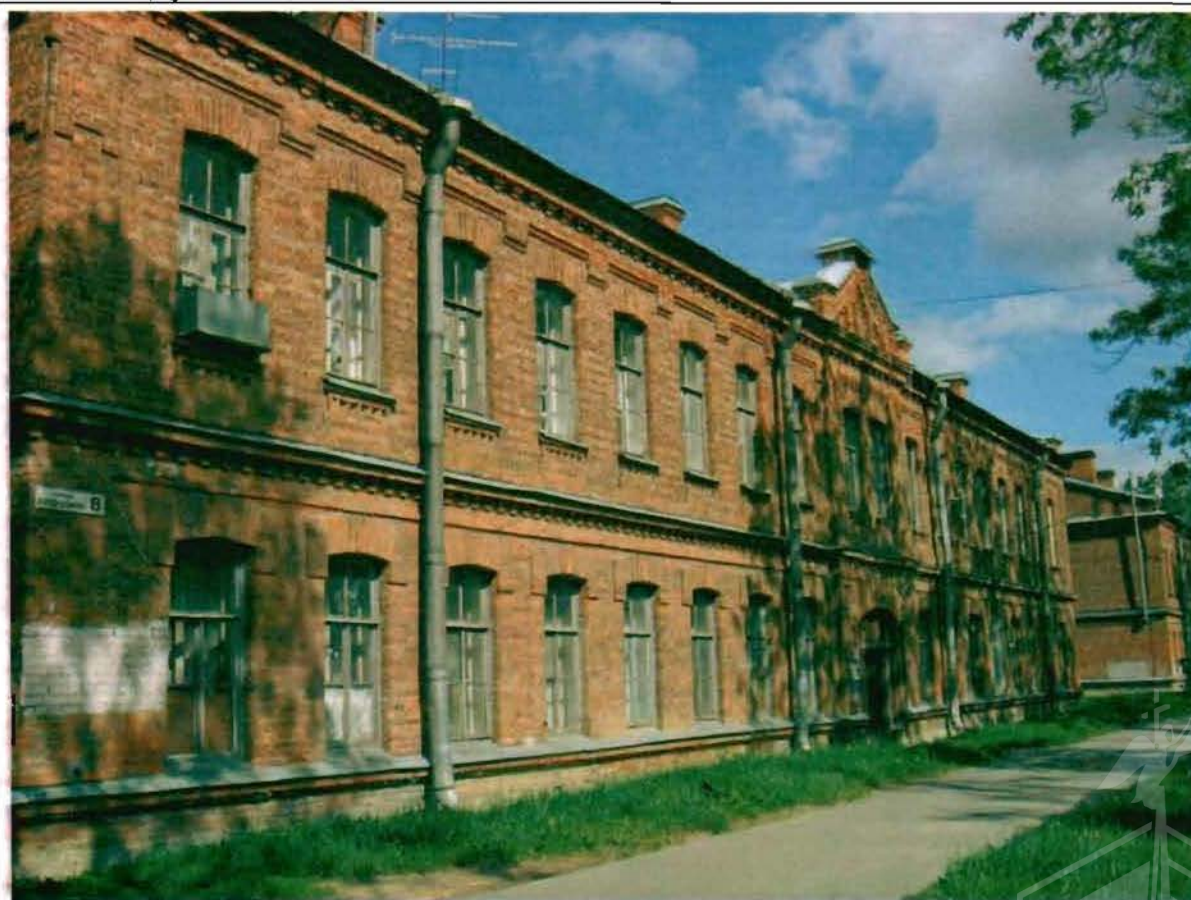
Фото 176. Восточный фасад. Общий вид.
