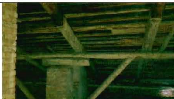
Фото 38. Конструкции крыши. Фрагмент.
