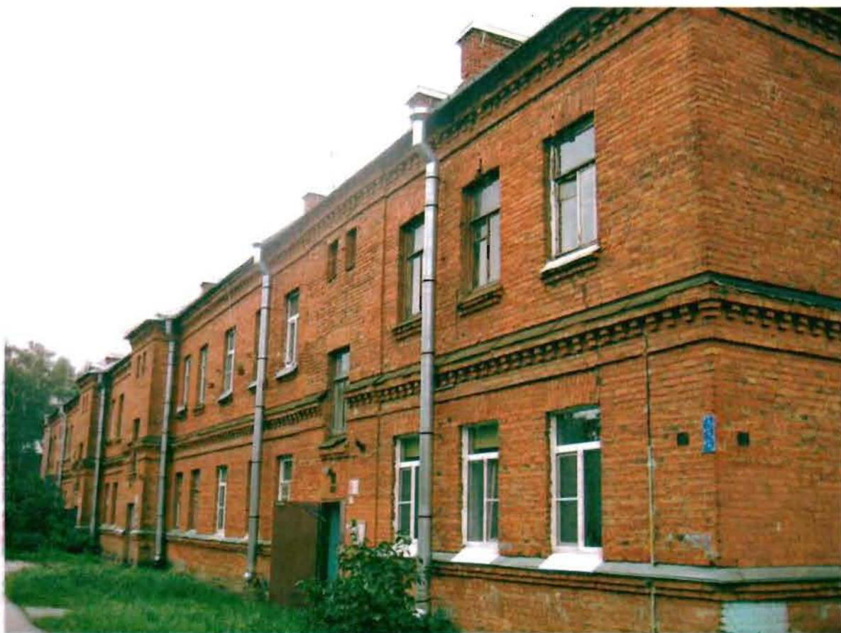
Фото 83. Северный фасад. Общий вид.
