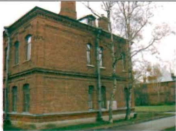
Фото 160. Северный фасад. Общий вид.
