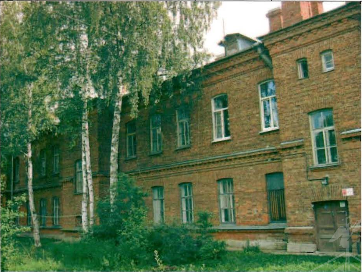
Фото 179. Западный фасад. Общий вид.
