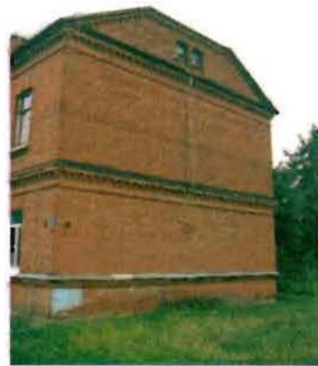
Фото 86. Западный фасад. Общий вид.
