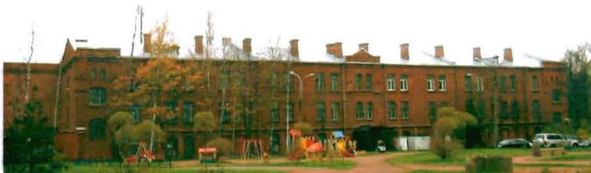
Фото 28. Восточный фасад. Общий вид.
