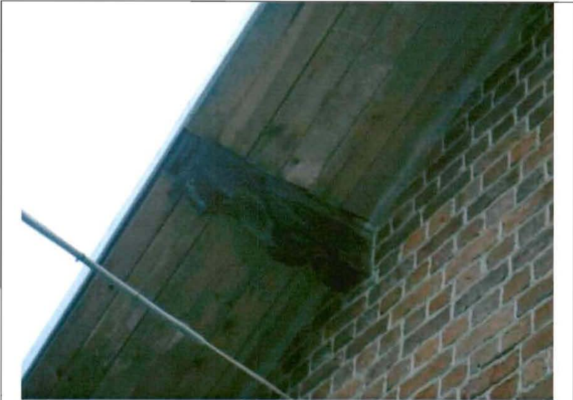
Деревянные кобылки. Съёмка 20.11.2012, Воронина Н.В.
