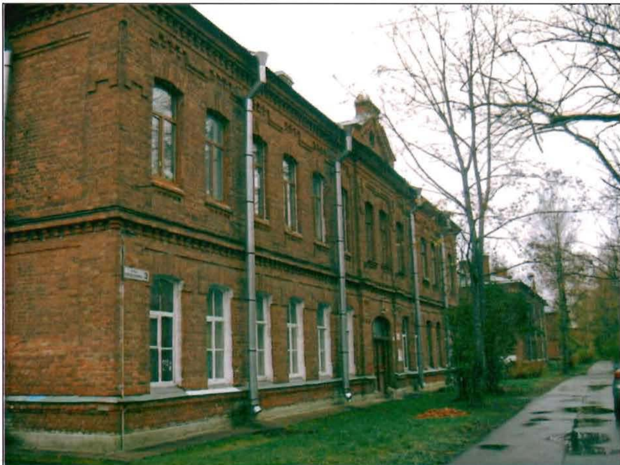
Фото 146. Западный фасад. Общий вид.
