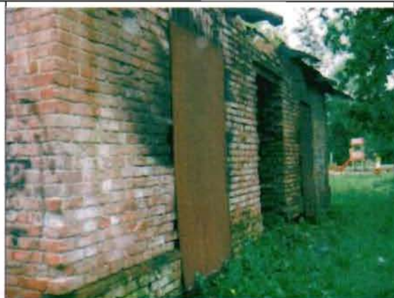
Фото 95. Северный фасад. Общий вид.
