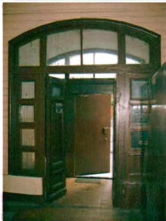
Фото 107. Дверной проем тамбура. Общий вид.
