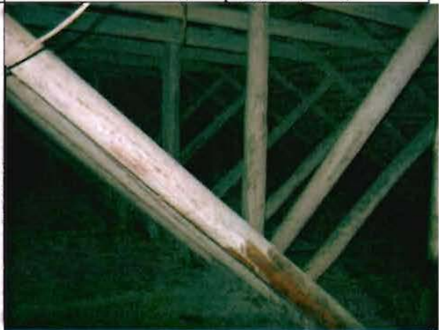
Фото 88. Конструкции крыши. Общий вид.
