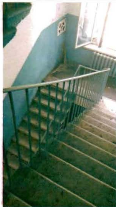
Фото 144. Лестница № 2 в южной части здания. Общий вид.
