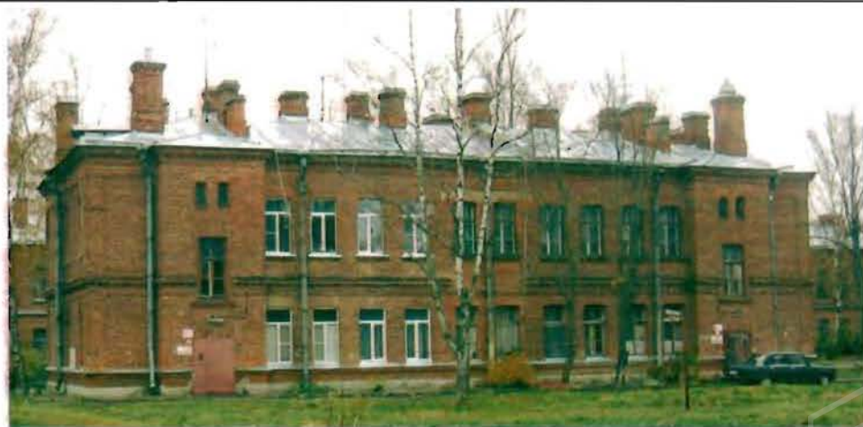
Фото 158. Восточный фасад. Общий вид.
