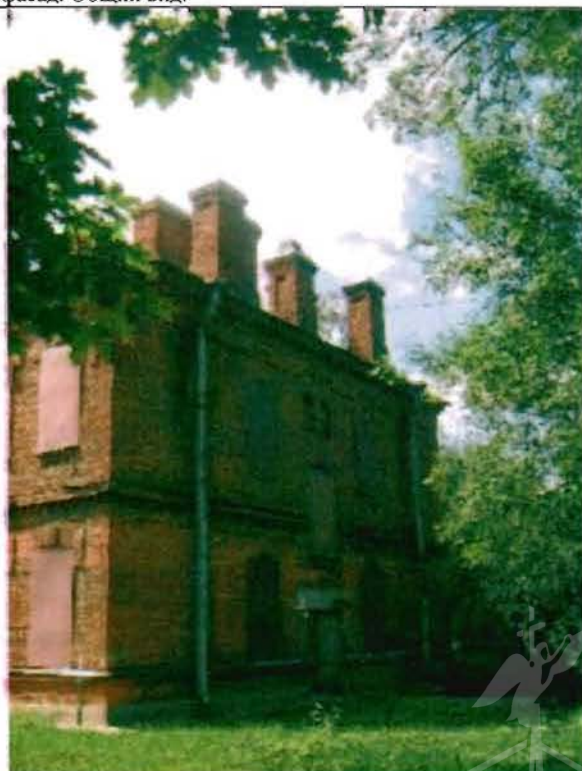
Фото 118. Северный фасад. Общий вид.
