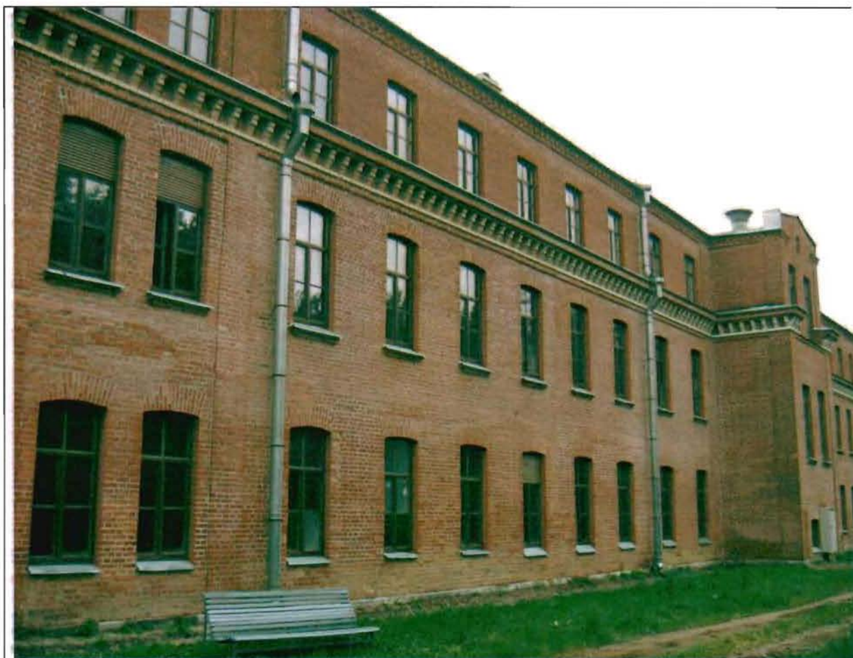
Фото 66. Южный фасад. Общий вид. 05.07.2016.
