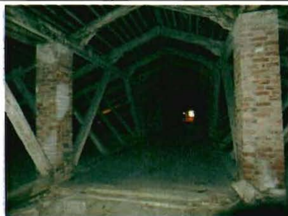
Фото 12. Конструкции крыши. Общий вид. 29.12.2015.
