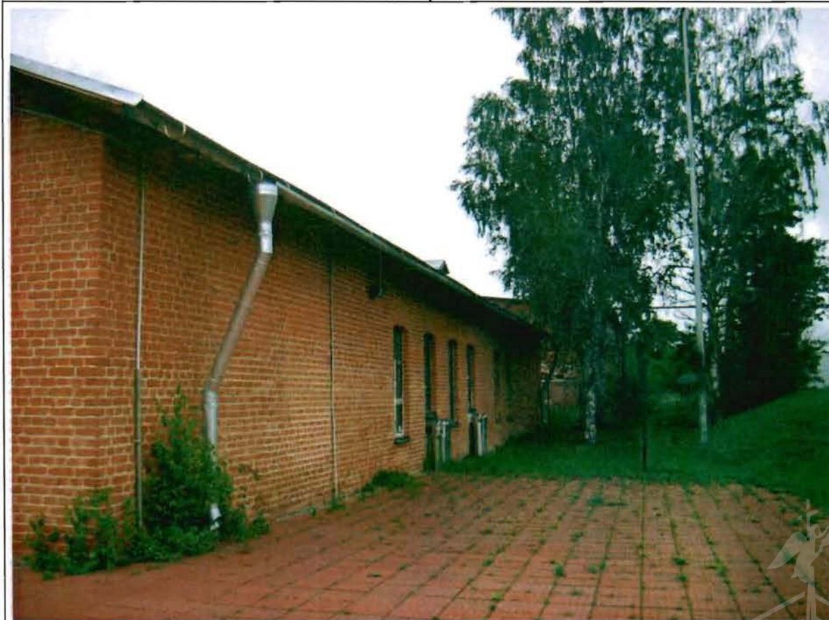
Фото 19. Восточный фасад. Общий вид.
