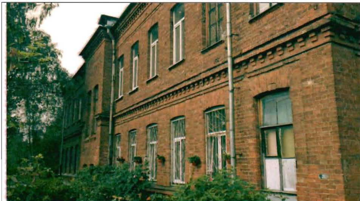
Фото 171. Восточный фасад. Общий вид.
