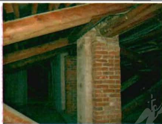
Фото 142. Конструкции крыши. Фрагмент.
