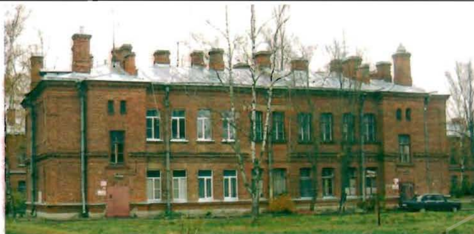
Фото 158. Восточный фасад. Общий вид.
