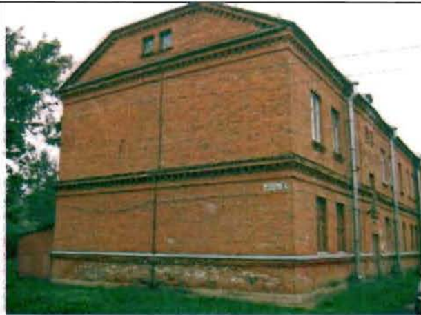
Фото 85. Восточный фасад. Общий вид.
