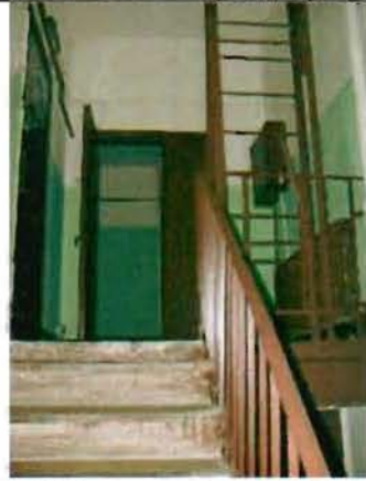
Фото 46. Интерьер. Лестница. Фрагмент.
