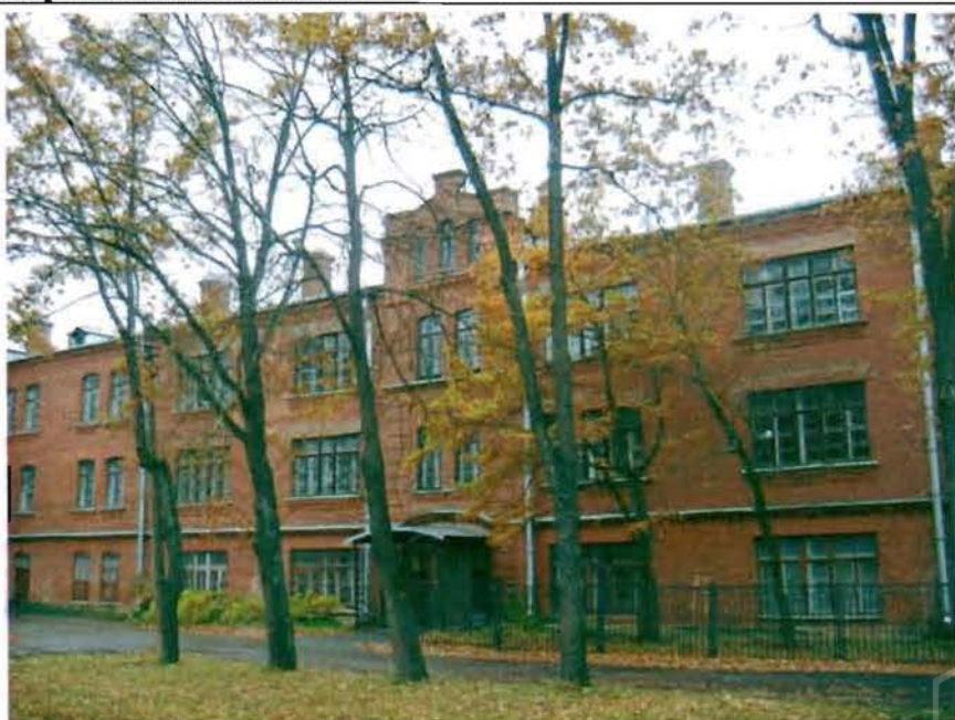
Фото 47. Восточный фасад. Общий вид.
