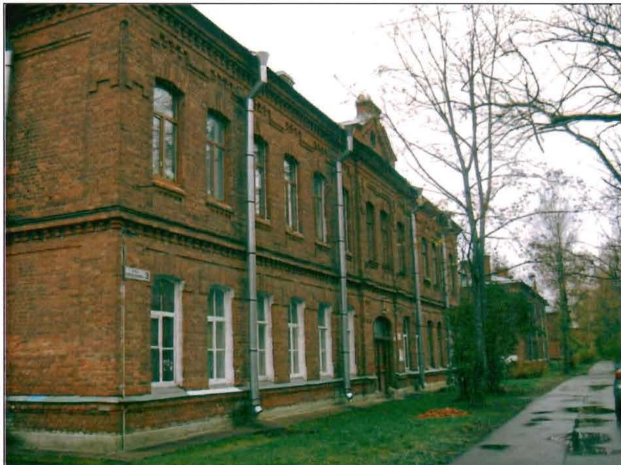
Фото 146. Западный фасад. Общий вид.
