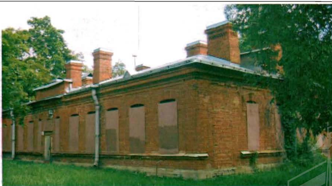
Фото 98. Западный фасад. Общий вид.
