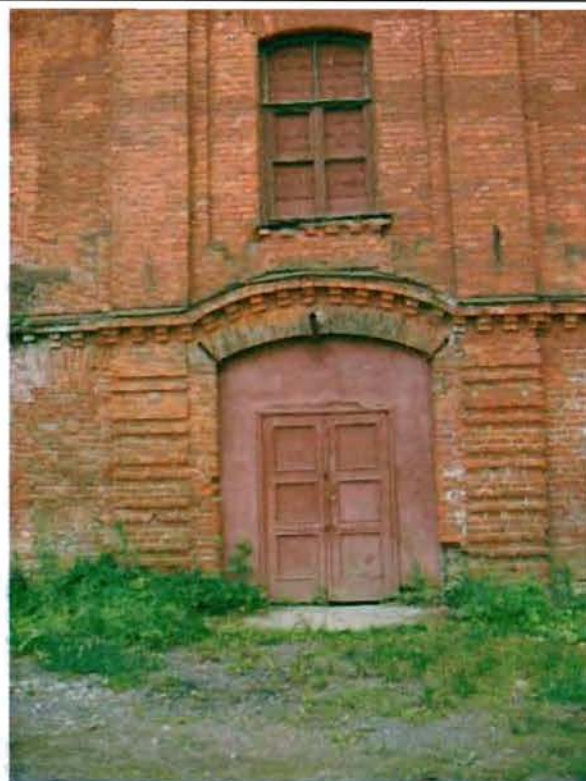
Фото 4. Западный фасад. Фрагмент центральной части фасада.
