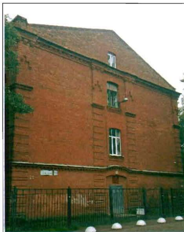
Фото 49. Северный фасад. Общий вид.
