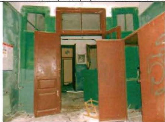
Фото 101. Дверной проем тамбура. Общий вид.
