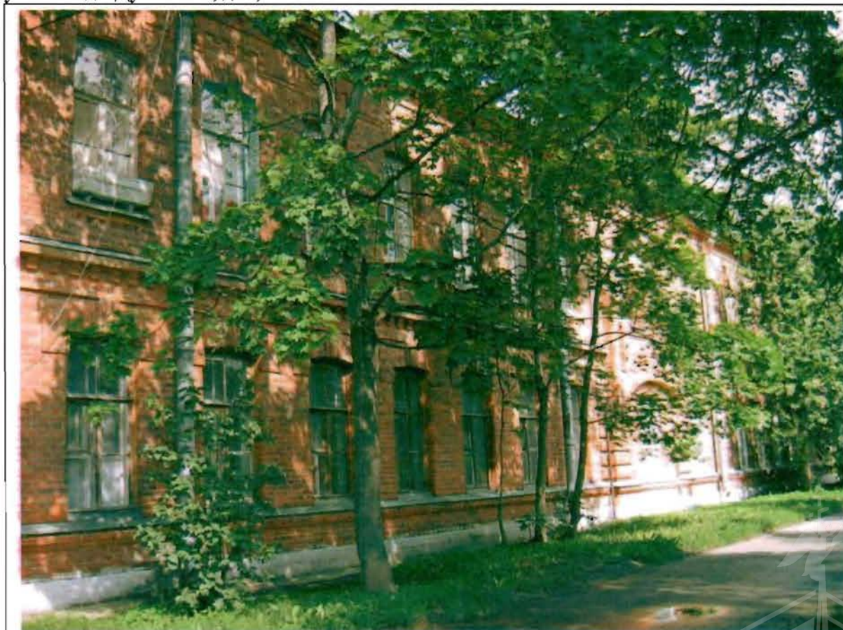
Фото 136. Восточный фасад. Общий вид.
