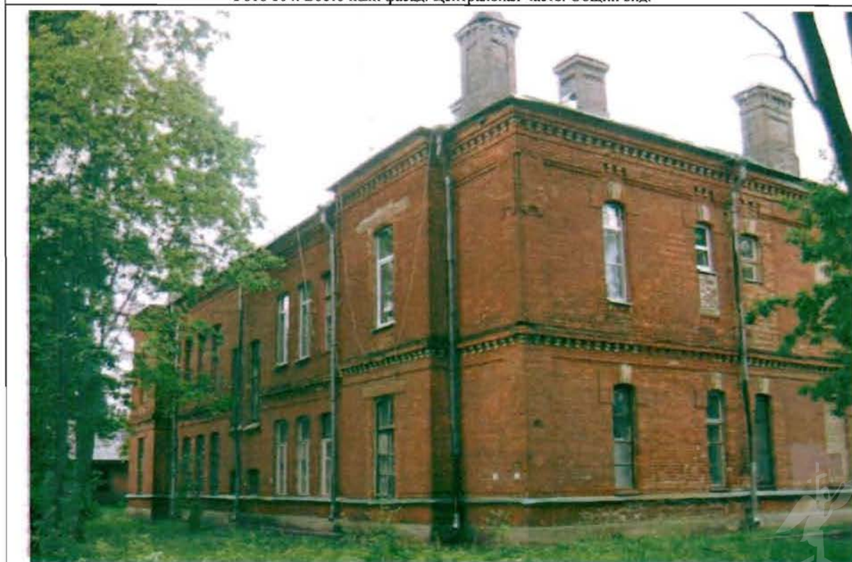
Фото 105. Западный, южный фасады. Общий вид.
