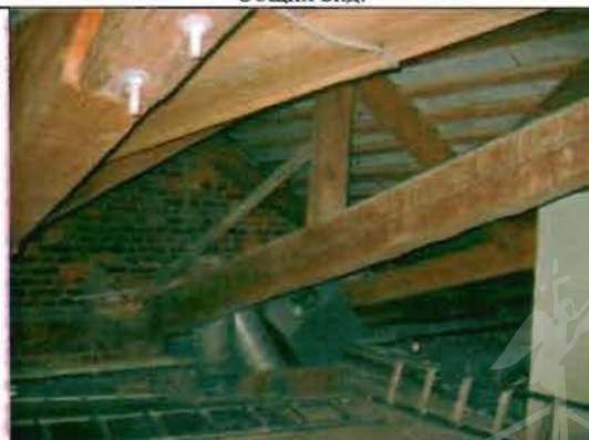
Фото 77. Конструкции крыши. Общий вид.
