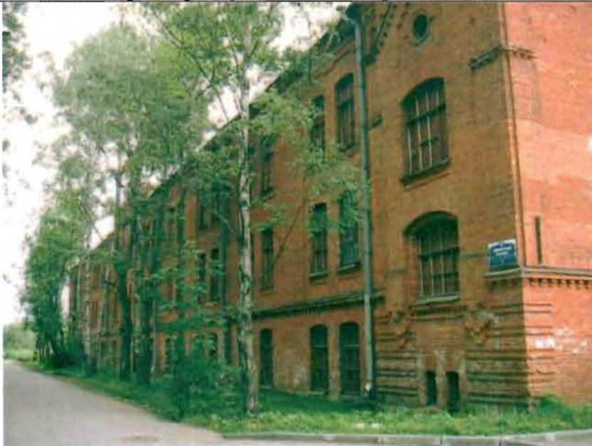
Фото 1. Западный фасад. Общий вид.
