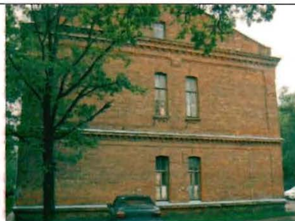
Фото 167. Северный фасад. Общий вид.
