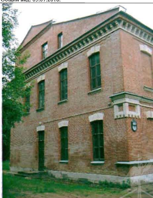
Фото 68. Восточный фасад. Общий вид.
