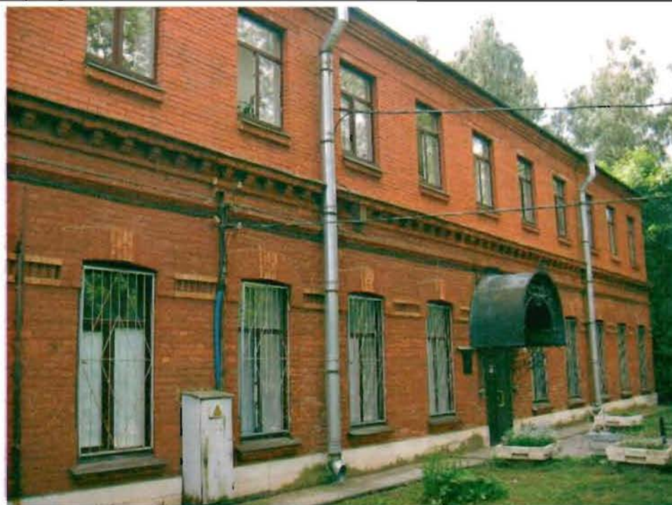
Фото 78. Западный фасад. Общий вид.
