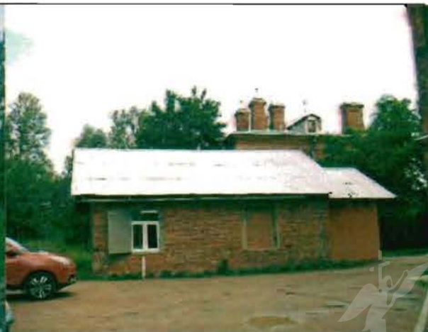
Фото 154. Южный фасад. Общий вид.
