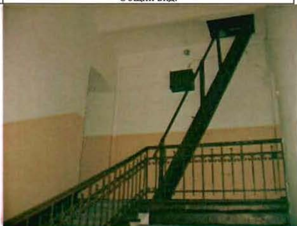
Фото 109. Парадная лестница в центральной части здания. Общий вид.
