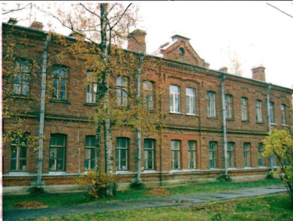
Фото 157. Западный фасад. Общий вид.
