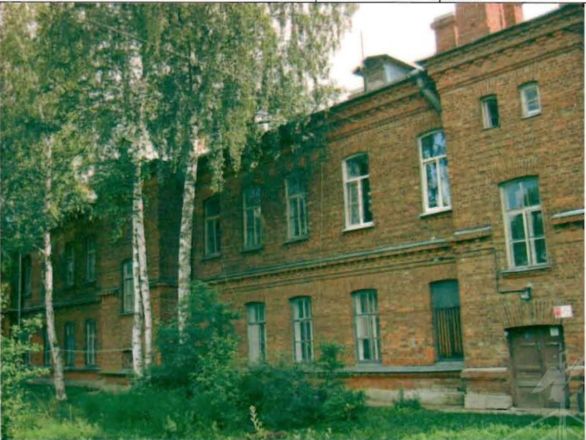
Фото 179. Западный фасад. Общий вид.
