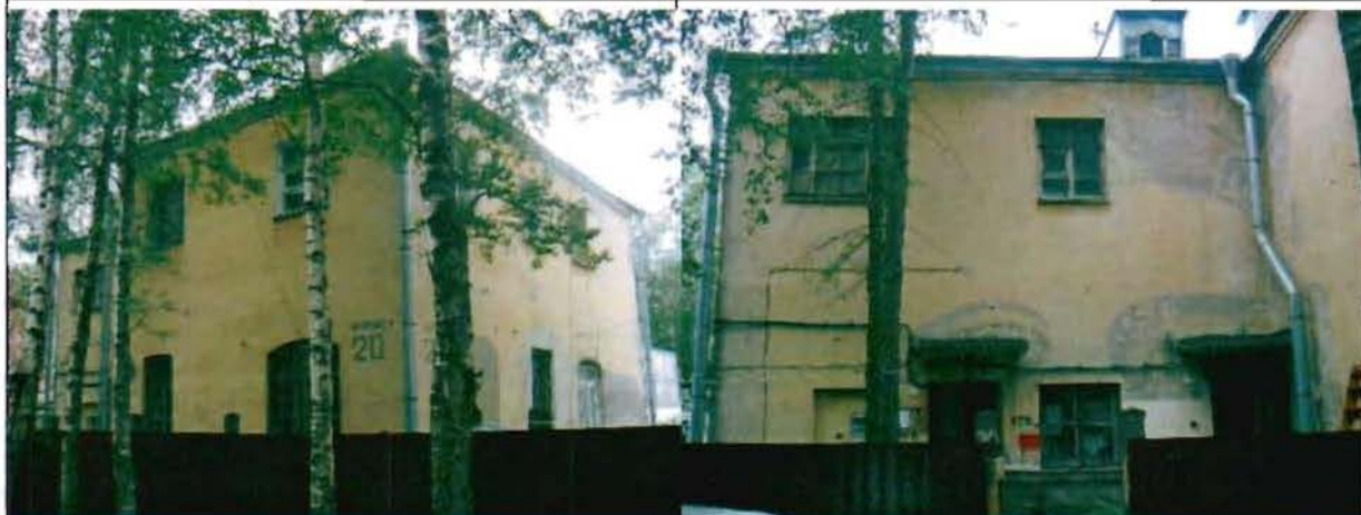
Фото 43. Северный, восточный фасады. Общий вид.
