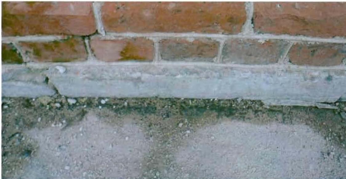
Цоколь, облицованный известняковой скобой. Съемка 20.11.2012, Воронина Н.В.
