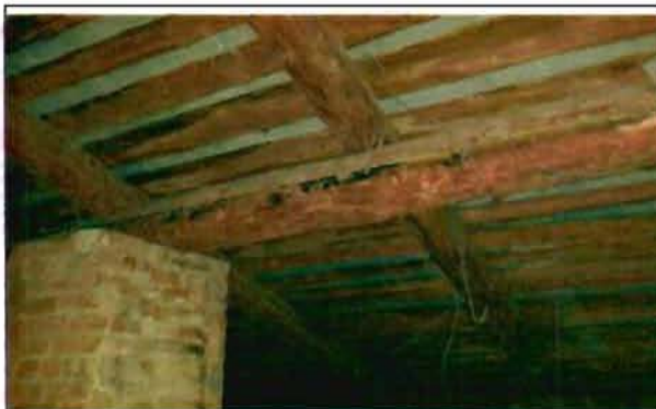
Фото 62. Конструкции крыши. Общий вид.
