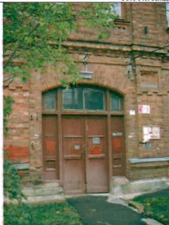
Фото 147. Дверной проем западного фасада. Общий вид.
