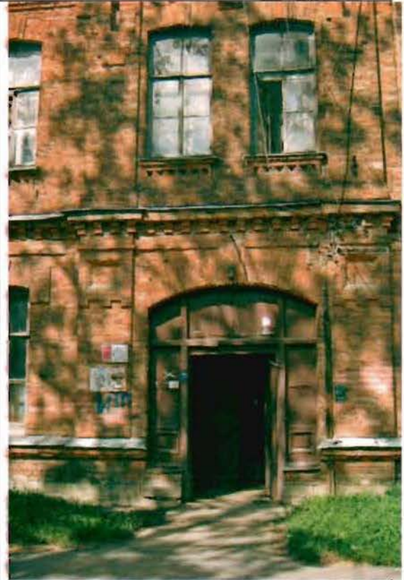
Фото 178. Восточный фасад. Центральная часть. Фрагмент.
