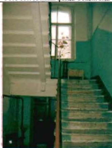
Фото 168. Лестница в южной части здания. Общий вид.
