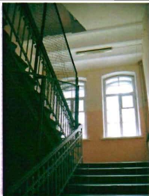
Фото 56. Лестница в центральной части здания. Фрагмент.
