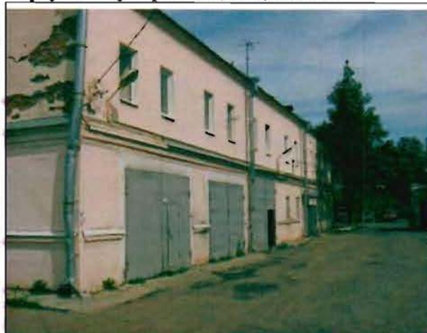
Фото 110. Восточный фасад. Общий вид.
