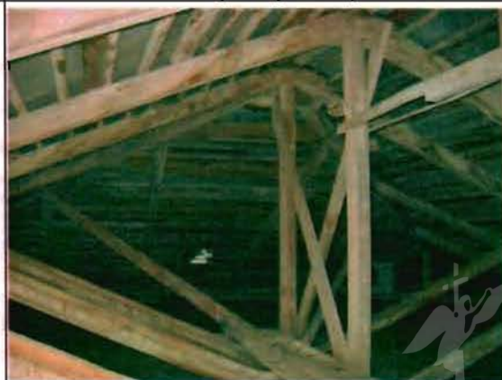
Фото 82. Конструкции крыши. Общий вид.
