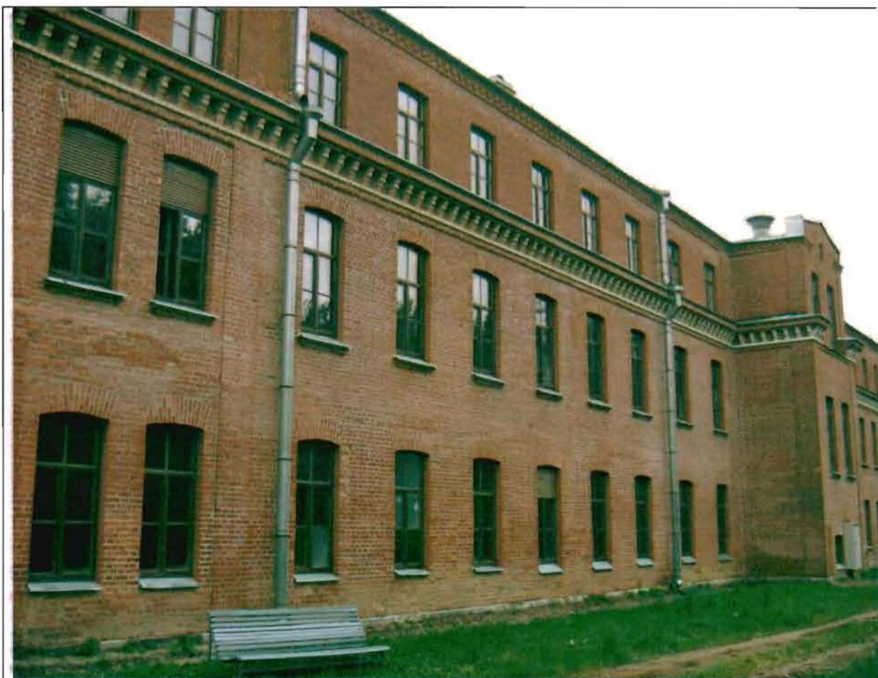
Фото 66. Южный фасад. Общий вид. 05.07.2016.
