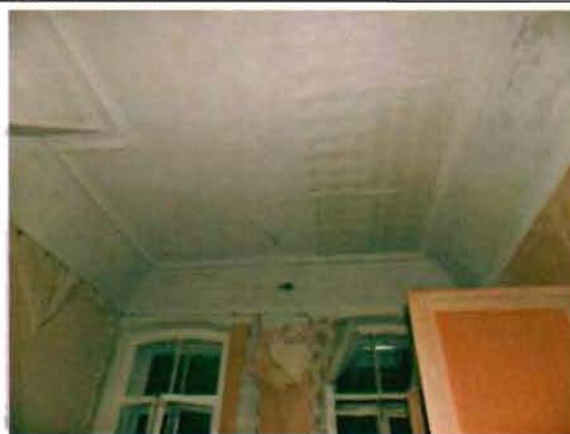
Фото 121. Помещение 1-го этажа.
