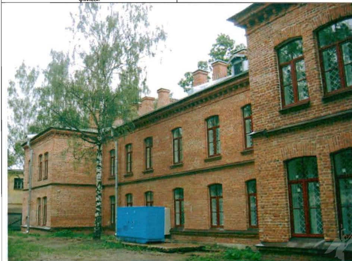
Фото 42. Западный фасад. Общий вид.
