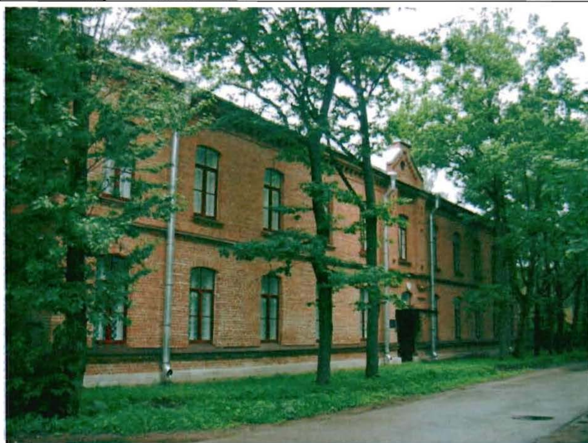
Фото 39. Восточный фасад. Общий вид.
