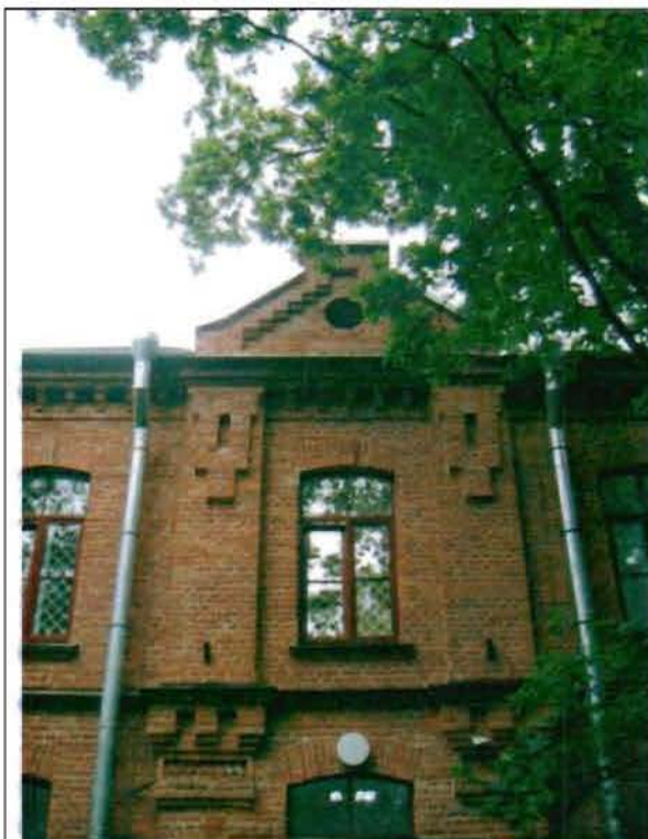
Фото 40. Восточный фасад. Фрагмент центральной части фасада.
