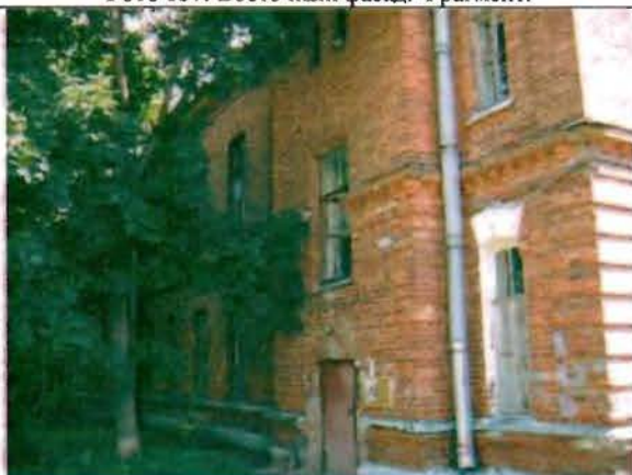
Фото 139. Западный фасад. Фрагмент.
