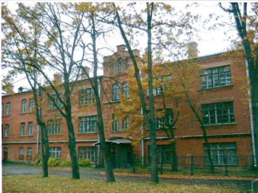
Фото 47. Восточный фасад. Общий вид.
