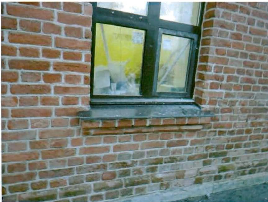
Ступенчатые подоконные доски. Съемка 20.11.2012, Воронина Н.В.
