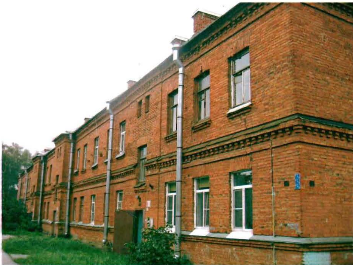
Фото 83. Северный фасад. Общий вид.
