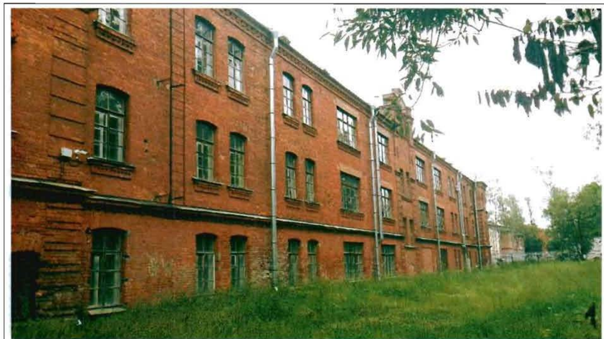
Фото 48. Западный фасад. Общий вид.
