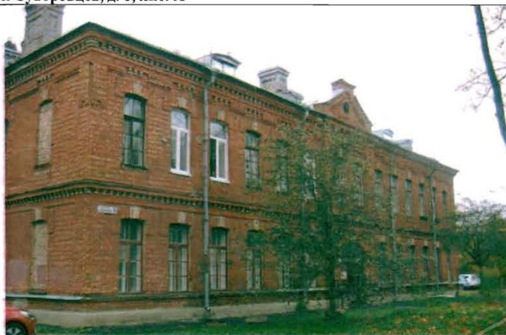
Фото 103. Восточный фасад. Общий вид.
