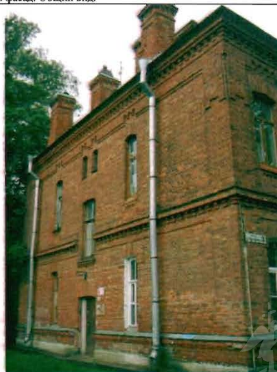
Фото 148. Северный фасад. Общий вид.
