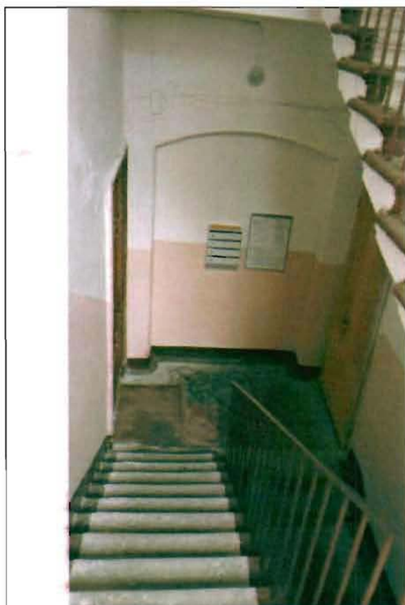
Фото 130. Лестница № 1 в южной части здания. Общий вид.
