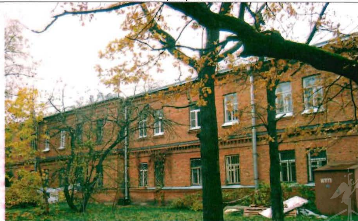
Фото 84. Южный фасад. Общий вид.
