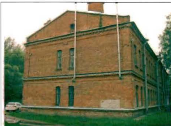
Фото 166. Южный фасад. Общий вид.
