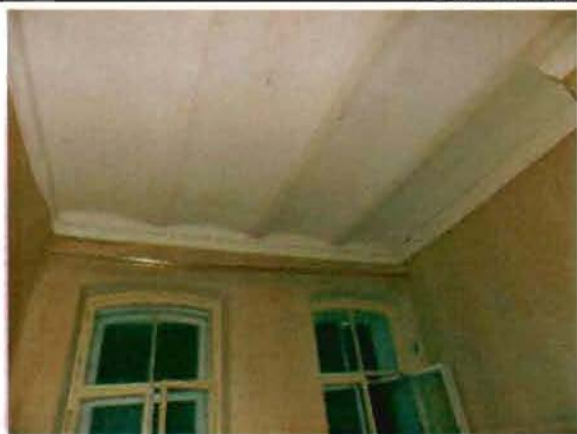
Фото 120. Помещение 1-го этажа. Общий вид.
