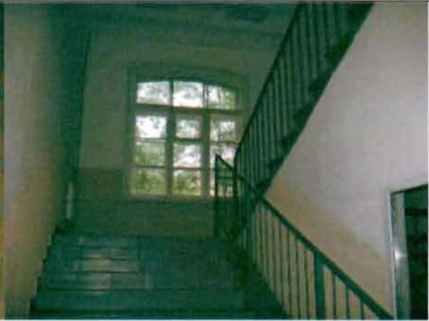
Фото 59. Интерьер. Лестница в северной части здания. Фрагмент.
