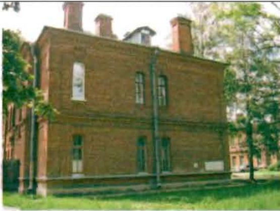
Фото 159. Северный фасад. Общий вид.
