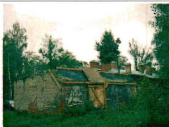
Фото 186. Западный, северный фасады. Общий вид.
