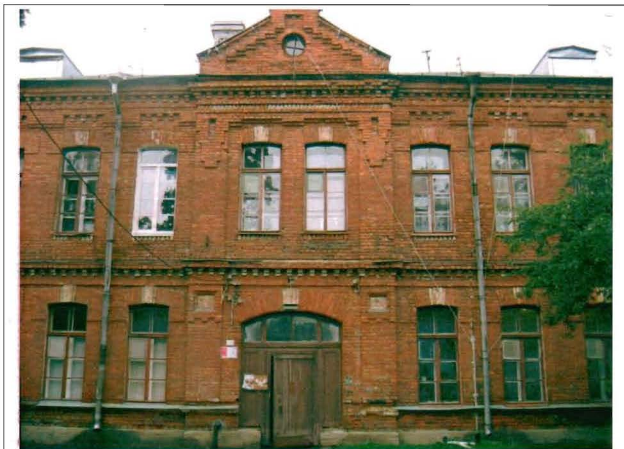
Фото 104. Восточный фасад. Центральная часть. Общий вид.
