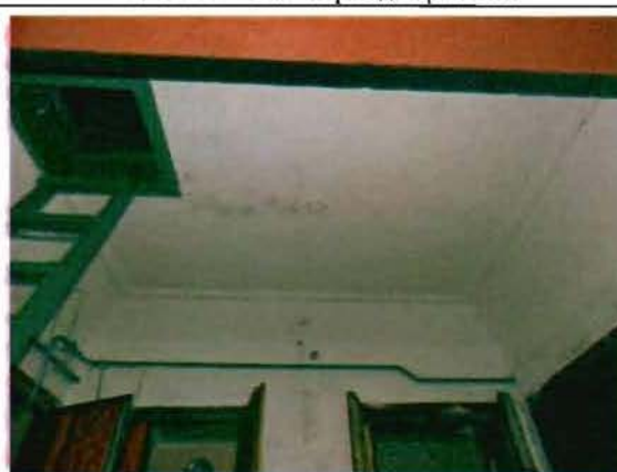
Фото 102. Отделка потолка тамбура. Общий вид.
