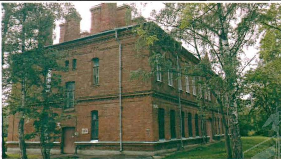
Фото 170. Северный, западный фасады. Общий вид.
