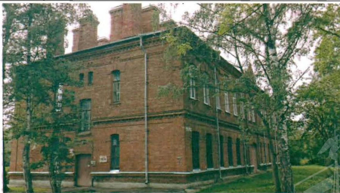
Фото 170. Северный, западный фасады. Общий вид.
