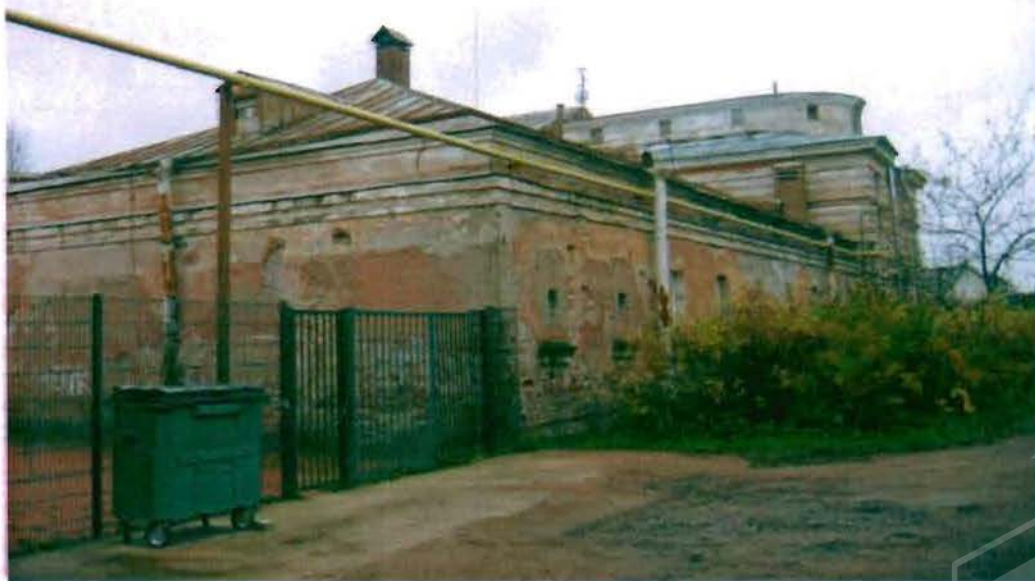
Фото 24. Западный, северный фасады. Общий вид.
