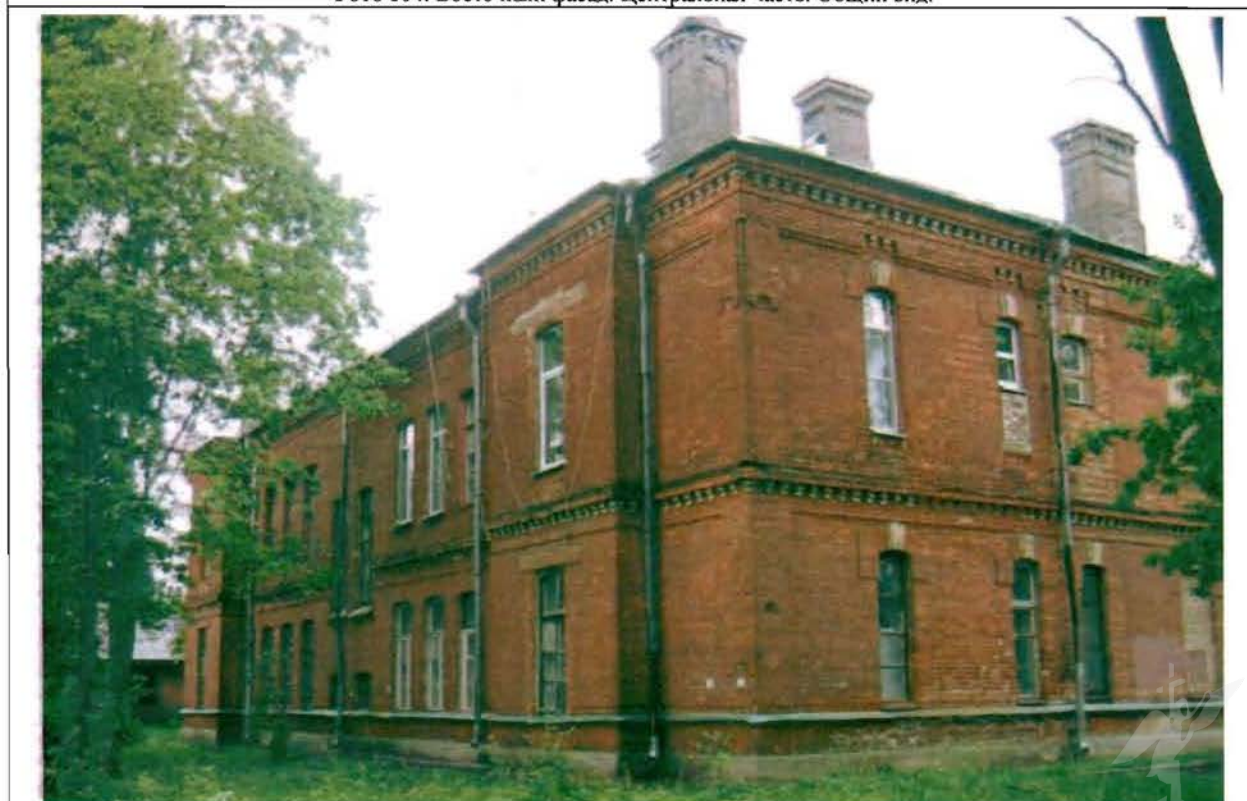
Фото 105. Западный, южный фасады. Общий вид.
