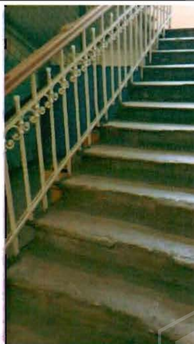
Фото 57. Лестница в центральной части здания. Фрагмент.
