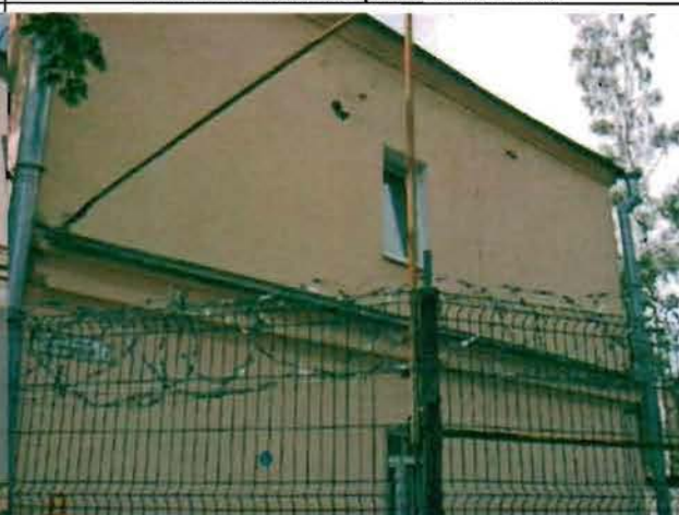
Фото 113. Северный фасад. Общий вид.
