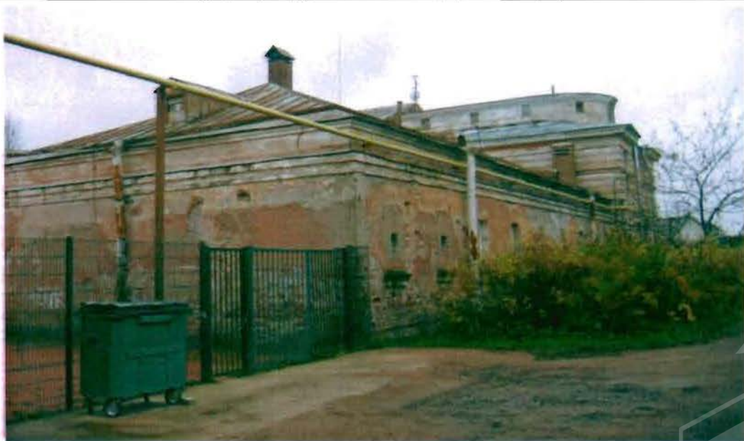
Фото 24. Западный, северный фасады. Общий вид.
