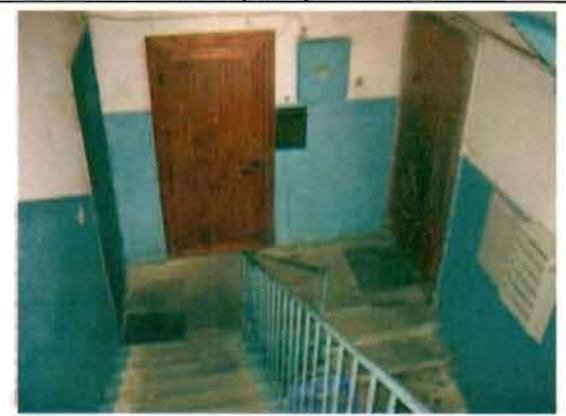
Фото 162. Лестница № 2 в северной части здания. Фрагмент.
