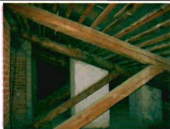
Фото 141. Конструкции крыши. Фрагмент.
