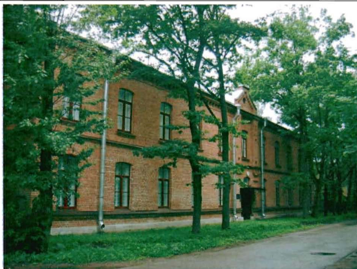
Фото 39. Восточный фасад. Общий вид.
