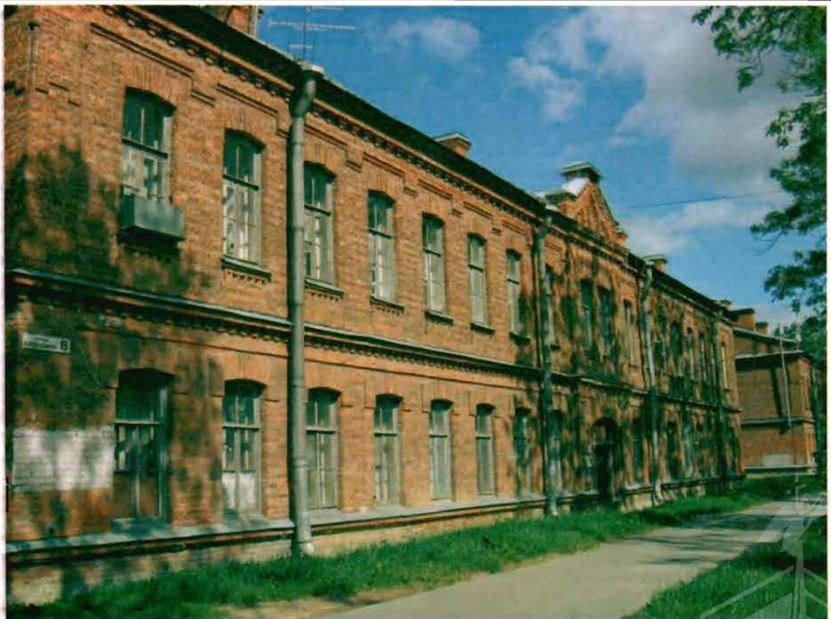
Фото 176. Восточный фасад. Общий вид.
