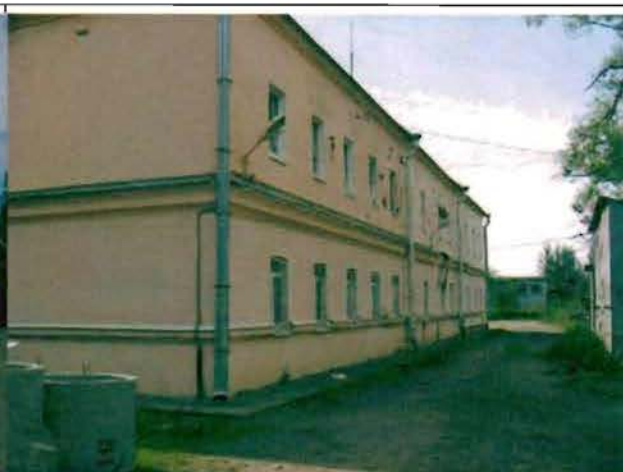
Фото 111. Западный фасад. Общий вид.
