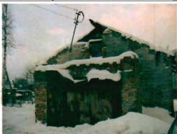
Фото 184. Восточный фасад. Общий вид. 14.01.2015.
