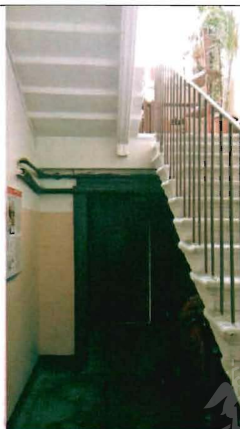
Фото 131. Лестница № 2 в северной части здания. Общий вид.
