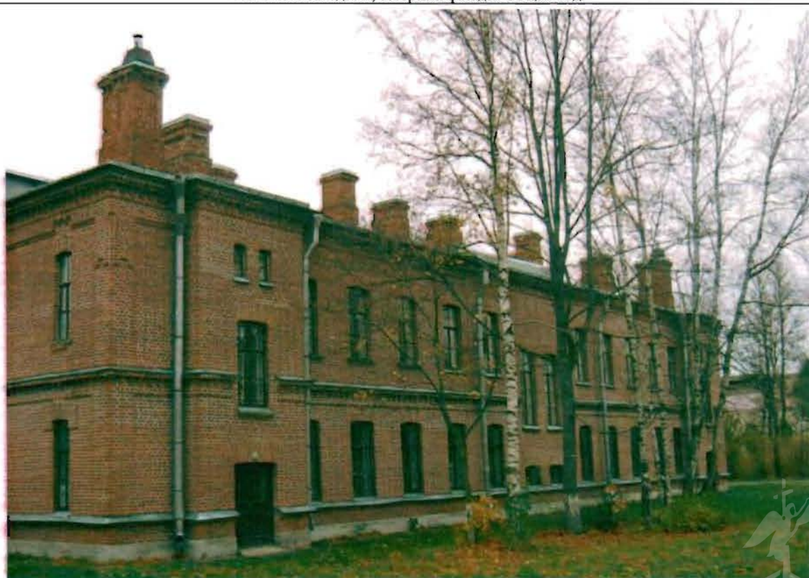
Фото 133. Восточный фасад. Общий вид.
