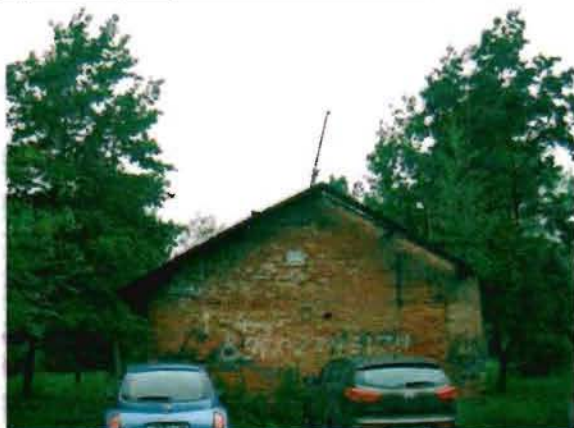
Фото 94. Восточный фасад. Общий вид.
