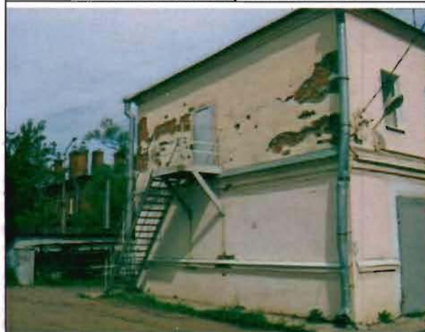
Фото 112. Южный фасад. Общий вид.
