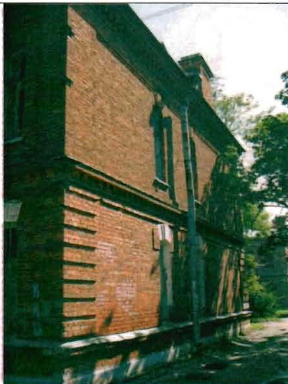
Фото 138. Южный фасад. Общий вид.
