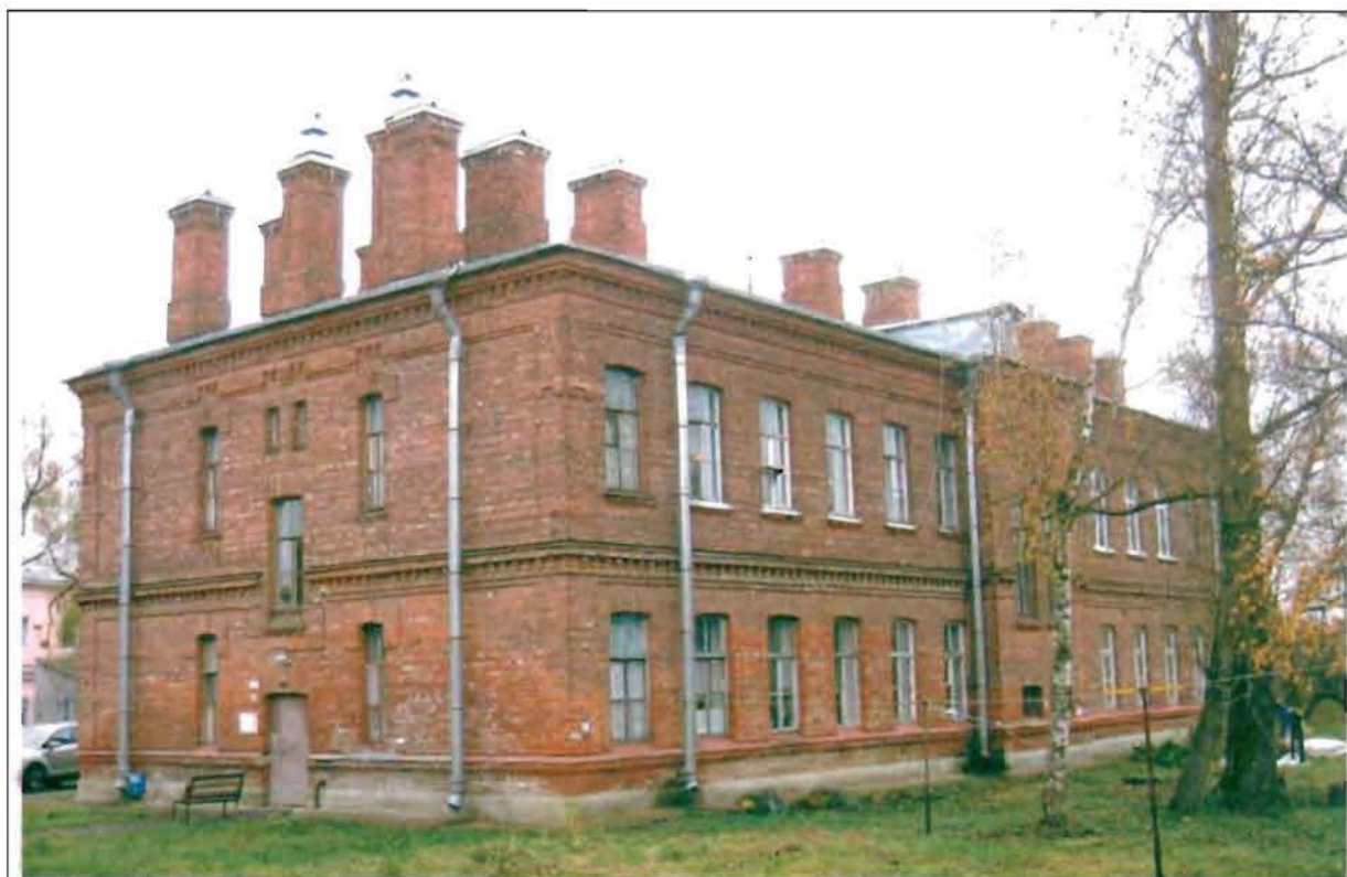
Фото 129. Западный, северный фасады. Общий вид.
