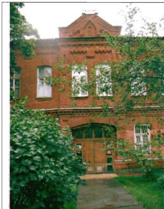
Фото 90. Восточный фасад. Центральная часть. Общий вид.
