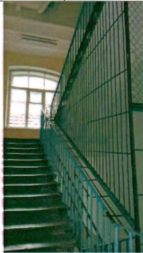
Фото 61. Интерьер. Лестница в южной части здания. Фрагмент.
