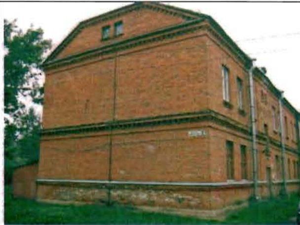
Фото 85. Восточный фасад. Общий вид.
