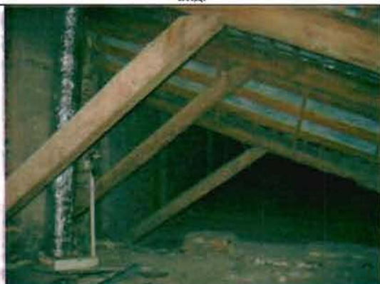
Фото 76. Конструкции крыши. Общий вид.
