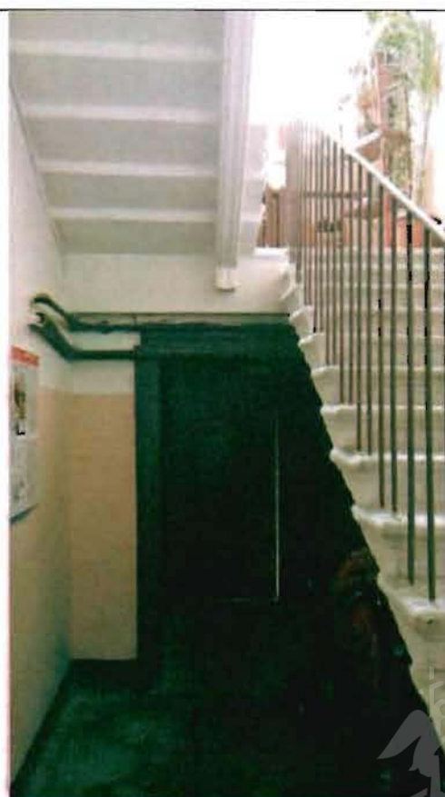
Фото 131. Лестница № 2 в северной части здания. Общий вид.
