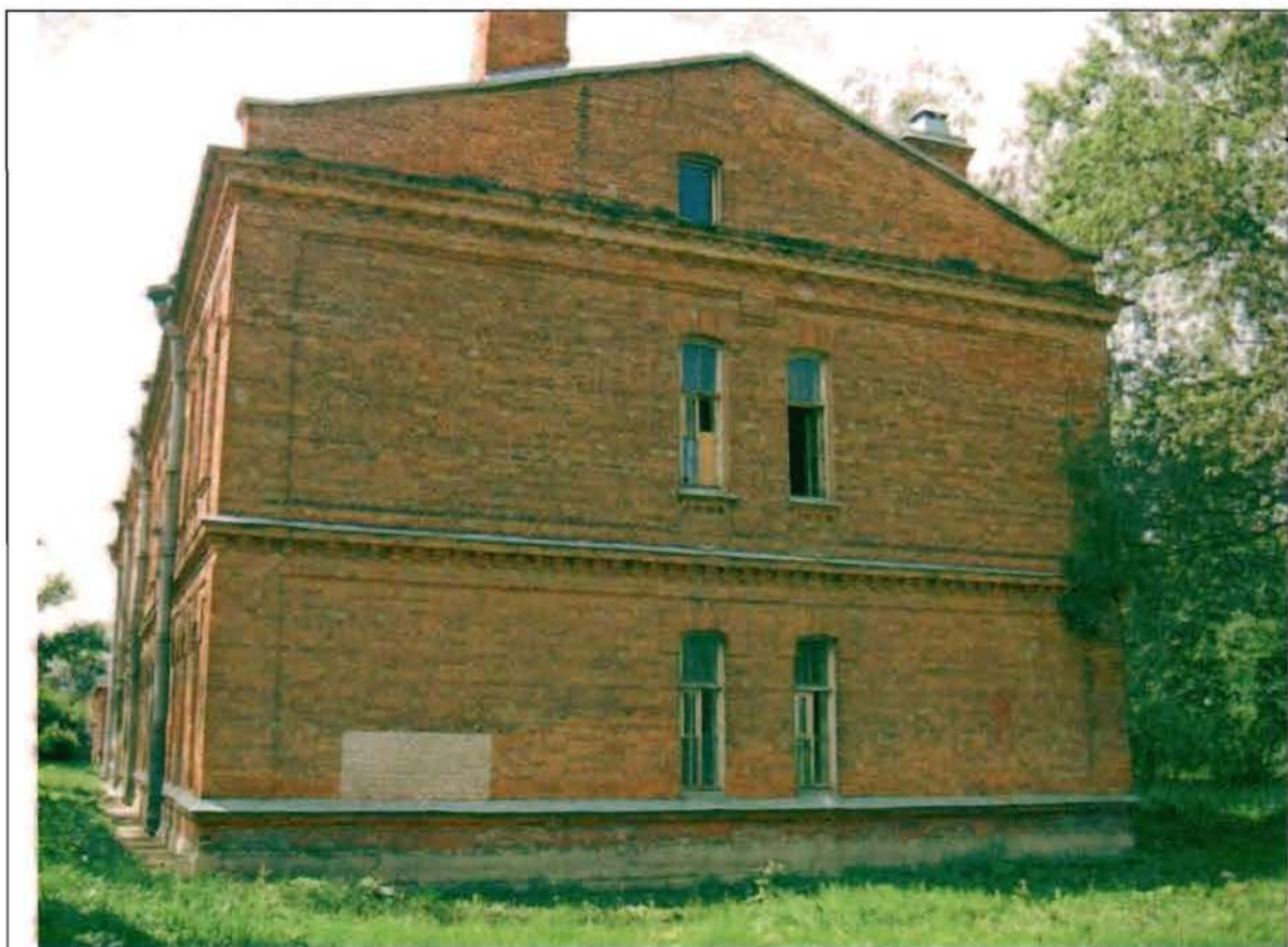
Фото 180. Северный фасад. Общий вид.
