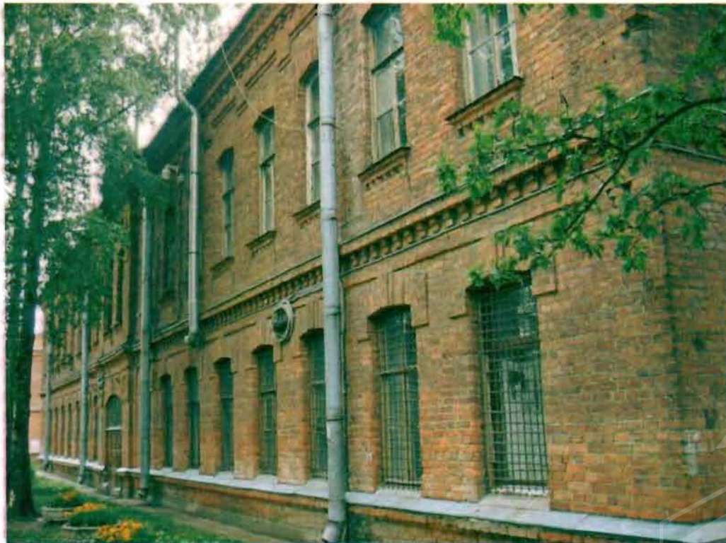
Фото 163. Восточный фасад. Общий вид.
