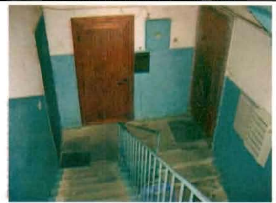
Фото 162. Лестница № 2 в северной части здания. Фрагмент.
