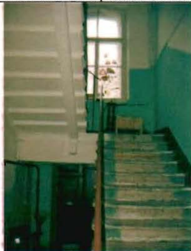
Фото 168. Лестница в южной части здания. Общий вид.
