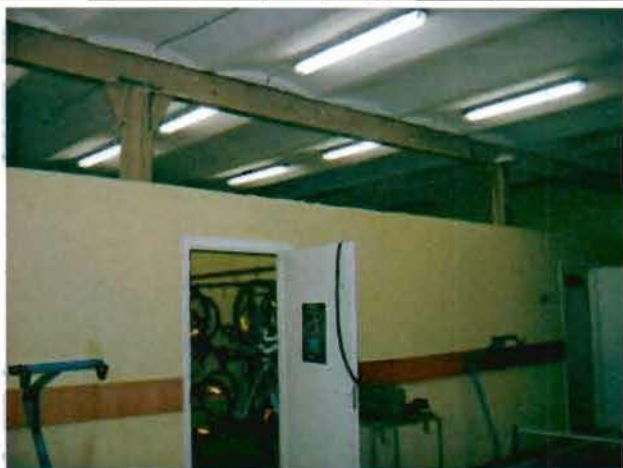
Фото 22. Интерьер. Помещение в уровне 1-го этажа. Общий вид.
