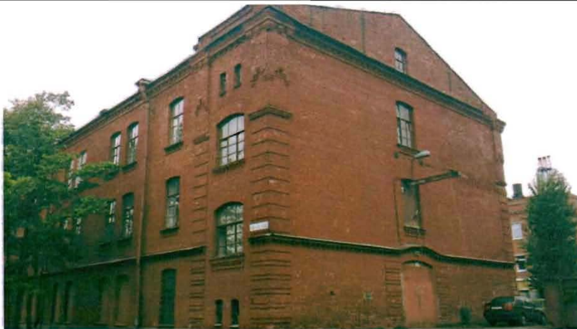
Фото 30. Северный фасад. Общий вид.
