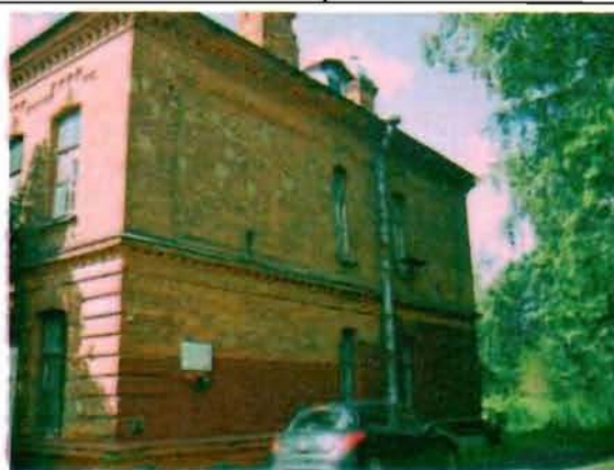
Фото 140. Северный фасад. Общий вид.
