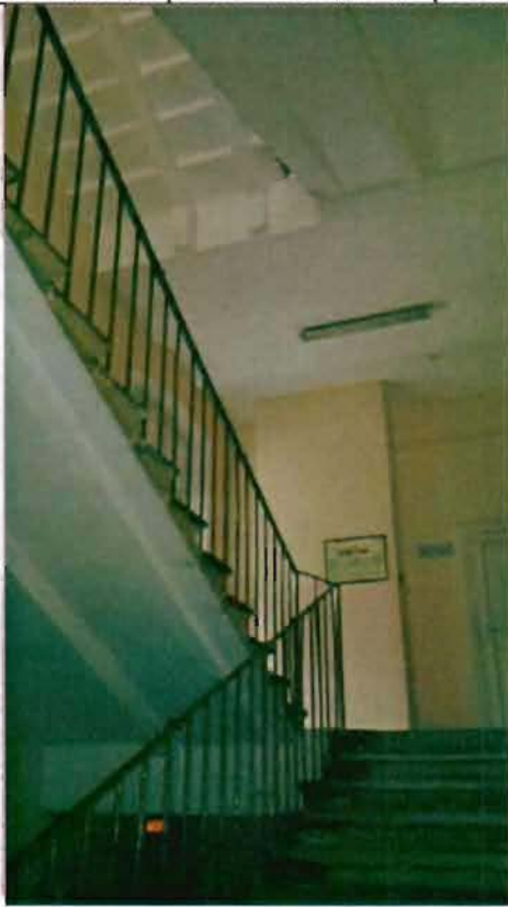
Фото 60. Интерьер. Лестница в южной части здания. Фрагмент.
