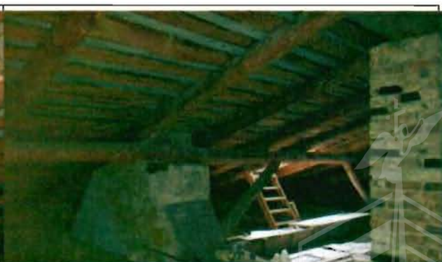
Фото 63. Конструкции крыши. Общий вид.
