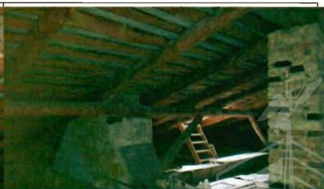
Фото 63. Конструкции крыши. Общий вид.
