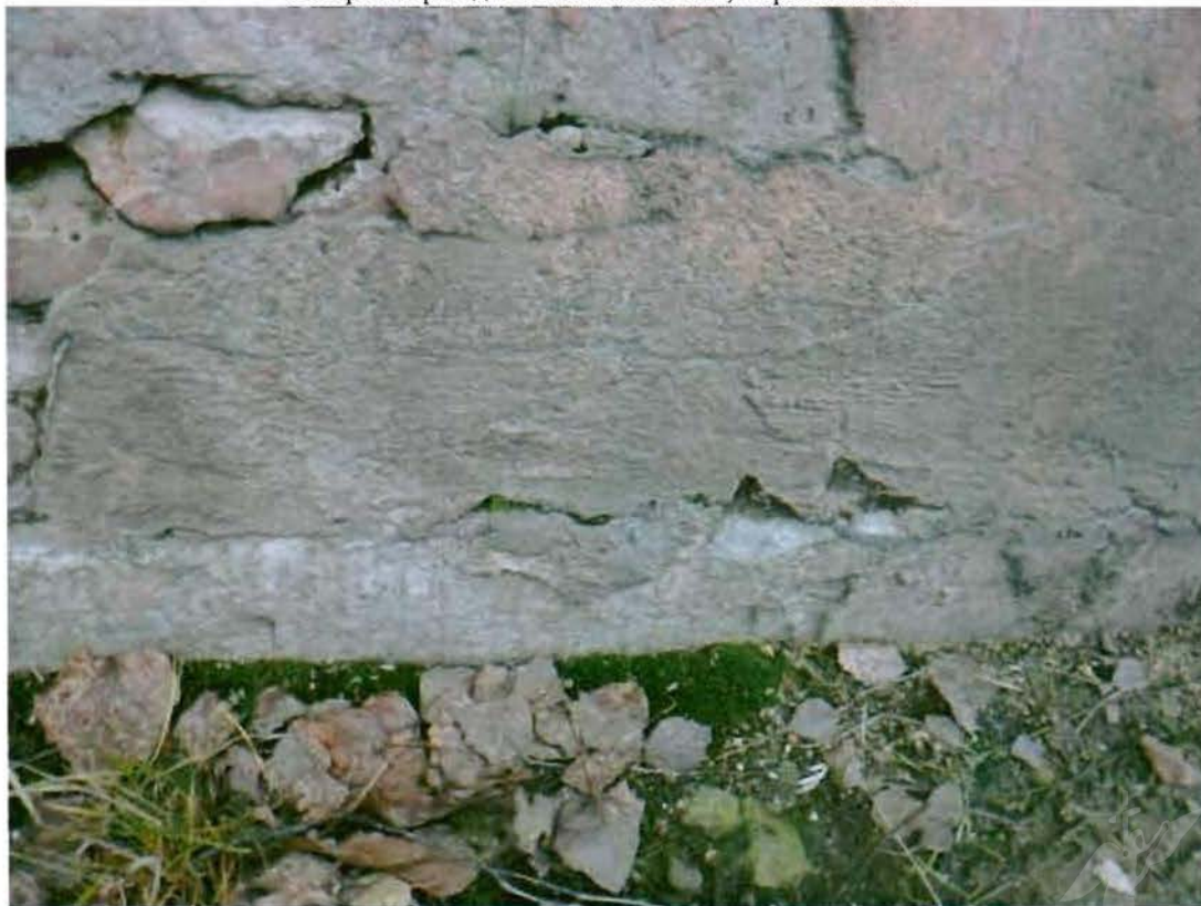
Цоколь, облицованный известняковой скобой. Съемка 27.11.2012, Воронина Н.В.
