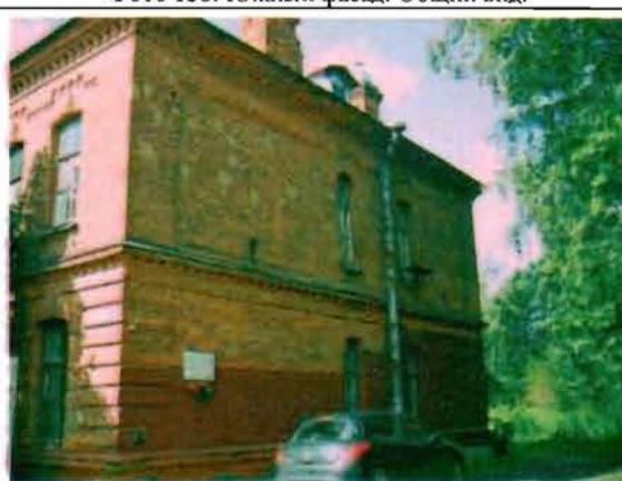
Фото 140. Северный фасад. Общий вид.
