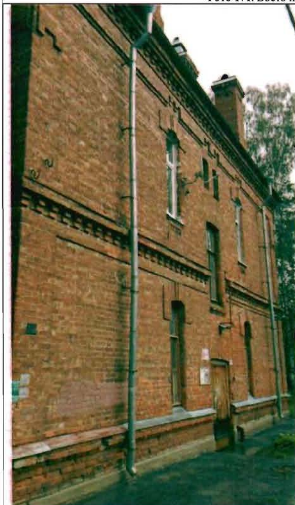
Фото 172. Южный фасад. Общий вид.
