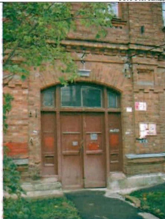
Фото 147. Дверной проем западного фасада. Общий вид.
