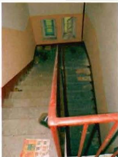
Фото 124. Лестница в южной части здания. Общий вид.
