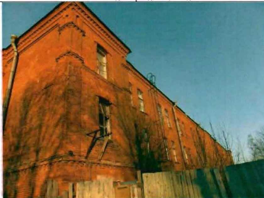
Фото 2. Восточный фасад. Общий вид. 29.12.2015.
