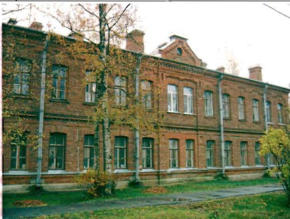
Фото 157. Западный фасад. Общий вид.
