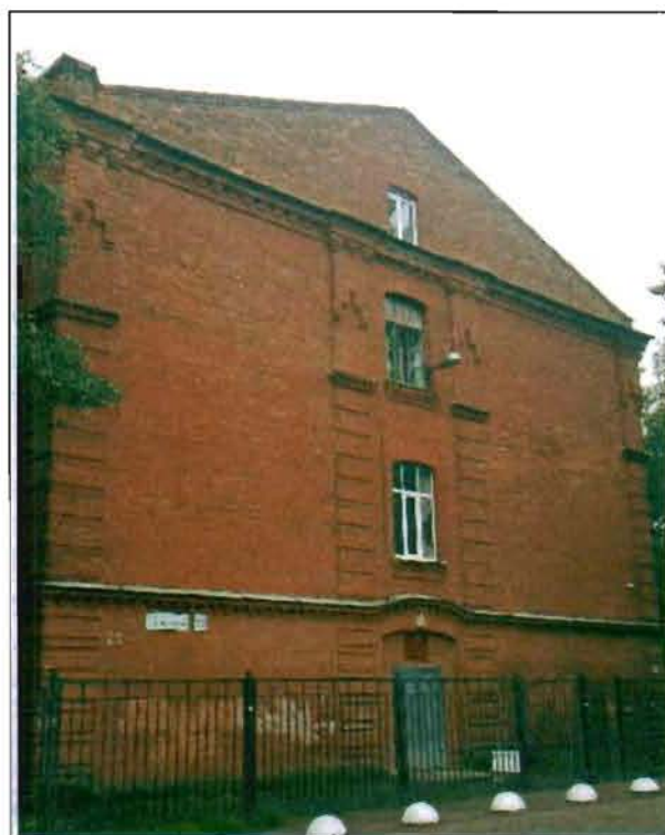
Фото 49. Северный фасад. Общий вид.
