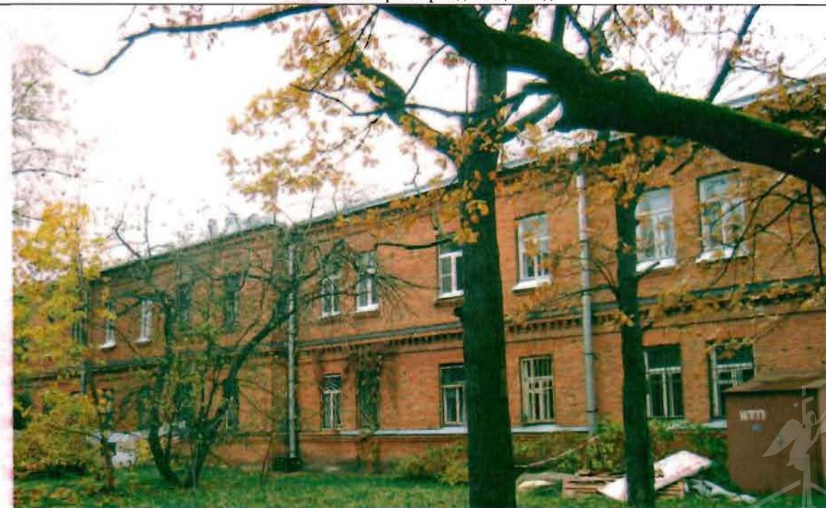
Фото 84. Южный фасад. Общий вид.
