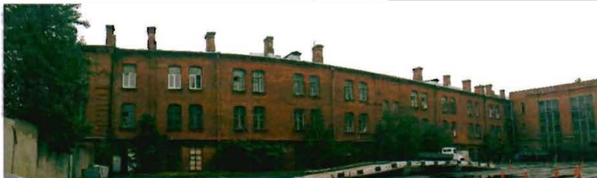
Фото 29. Западный фасад. Общий вид.
