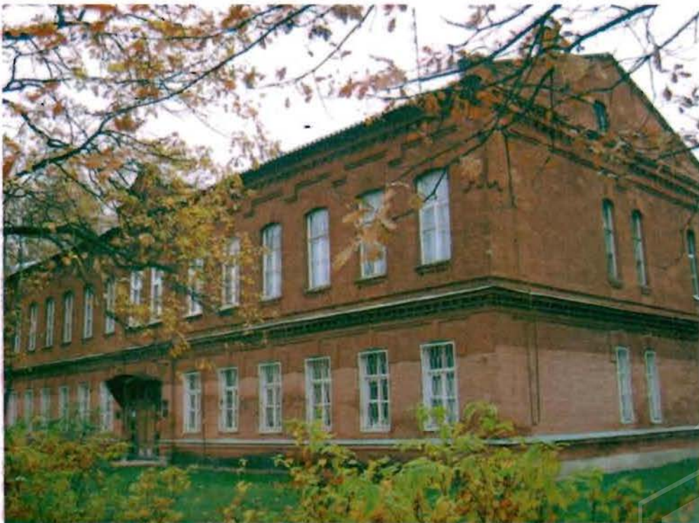
Фото 89. Западный, южный фасады. Общий вид.
