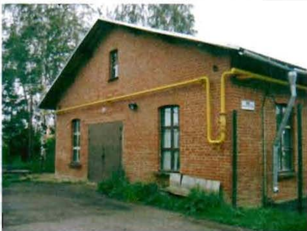
Фото 20. Северный фасад. Общий вид.
