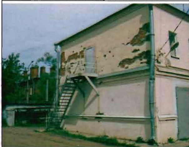
Фото 112. Южный фасад. Общий вид.
