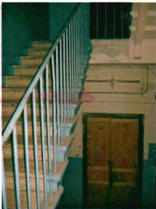
Фото 143. Лестница № 1 в северной части здания. Общий вид.
