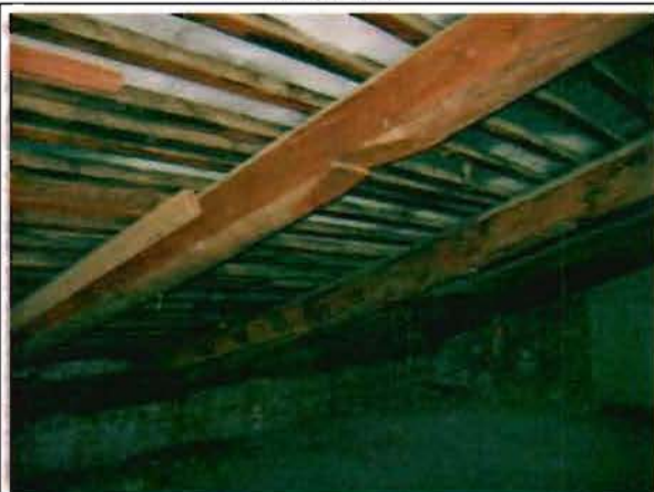
Фото 151. Конструкции крыши. Фрагмент.
