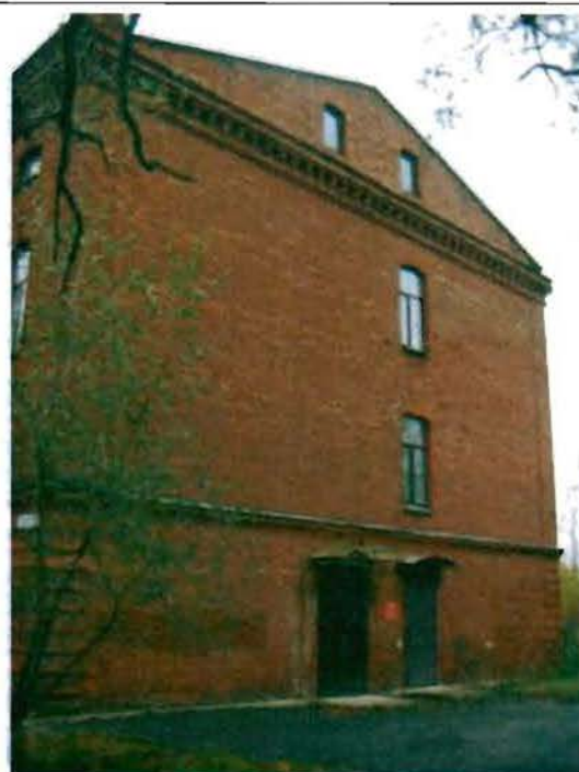
Фото 16. Южный фасад. Общий вид.
