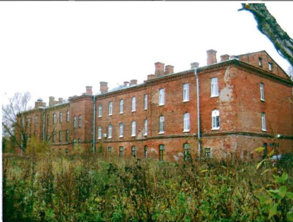
Фото 14. Восточный фасад. Общий вид.
