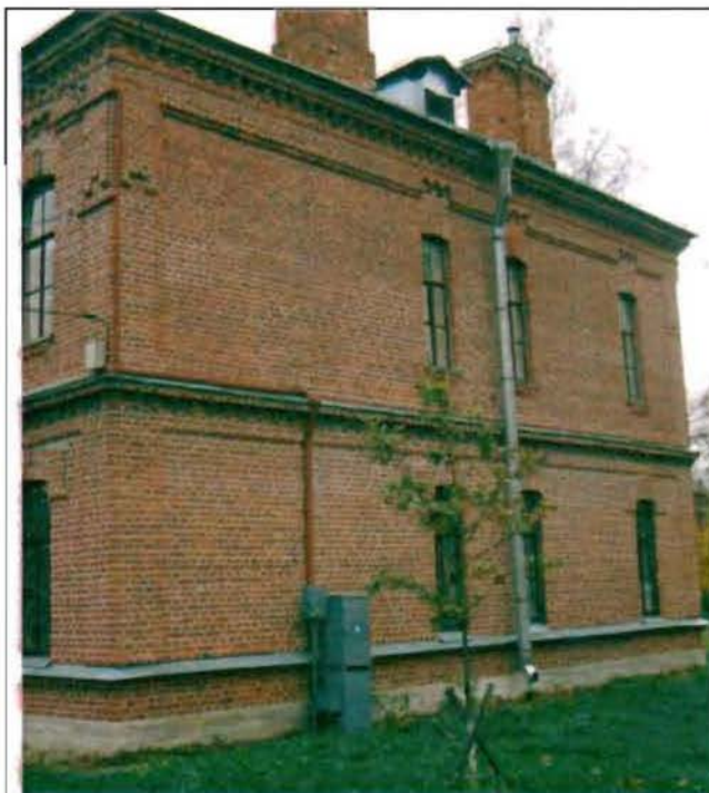
Фото 134. Южный фасад. Общий вид.
