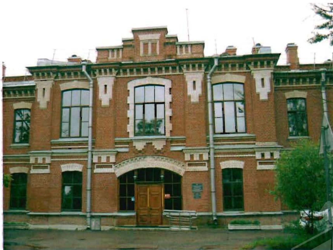
Фото 65. Северный фасад. Фрагмент центральной части фасада.
