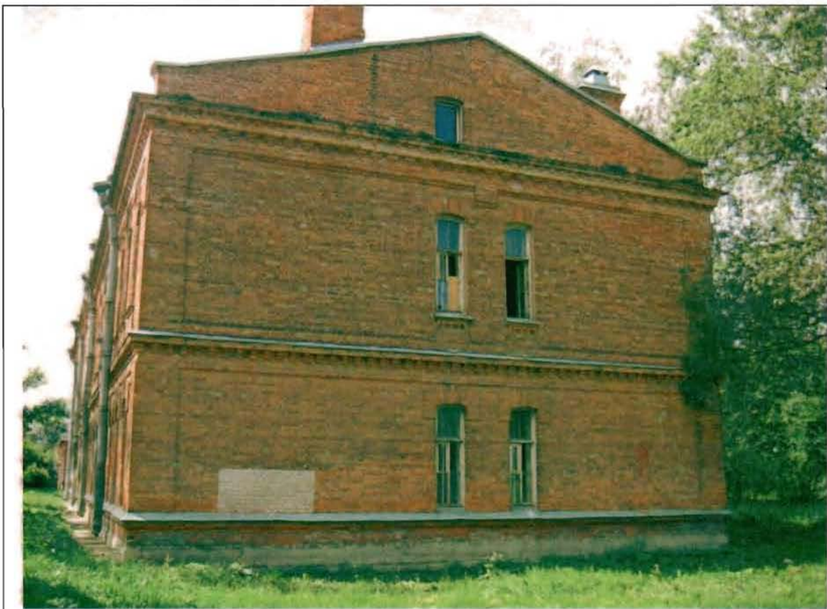
Фото 180. Северный фасад. Общий вид.
