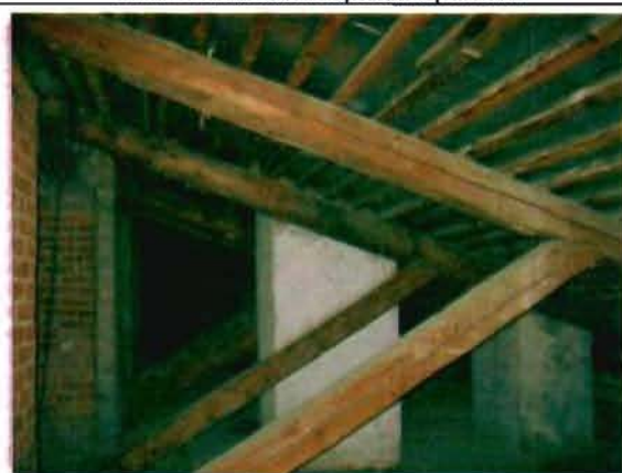
Фото 141. Конструкции крыши. Фрагмент.
