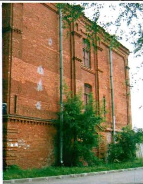
Фото 5. Южный фасад. Общий вид.
