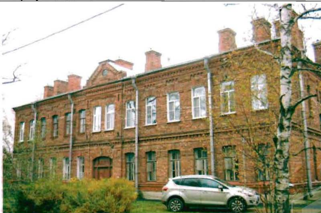
Фото 128. Восточный фасад. Общий вид.
