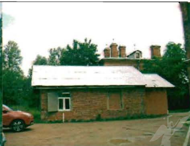
Фото 154. Южный фасад. Общий вид.
