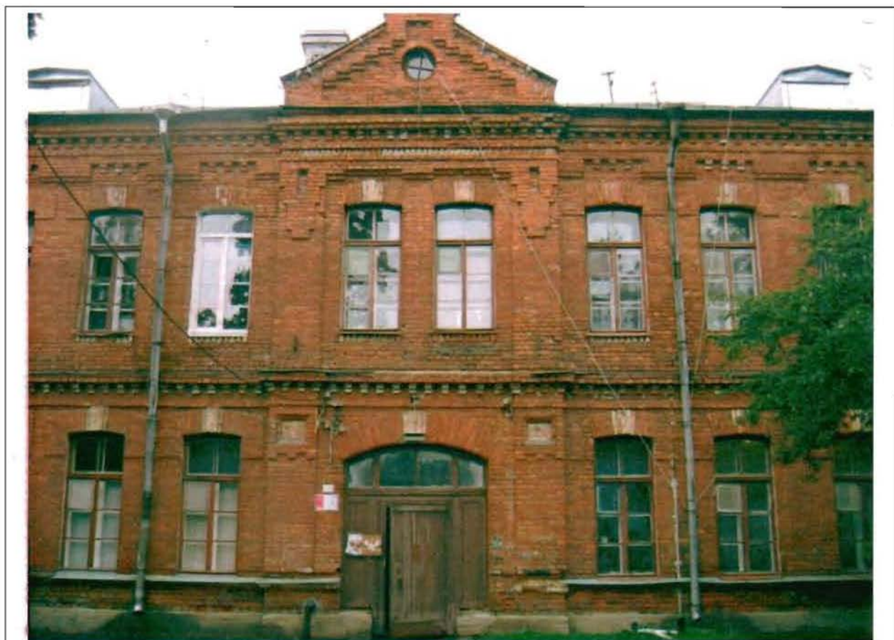
Фото 104. Восточный фасад. Центральная часть. Общий вид.
