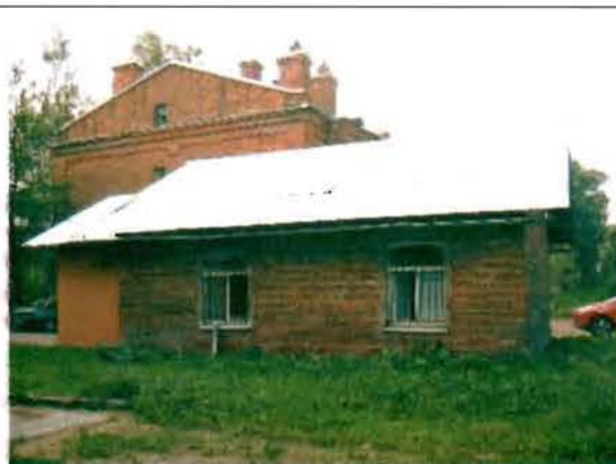
Фото 156. Западный фасад. Общий вид.
