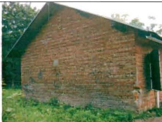
Фото 155. Северный фасад. Общий вид.
