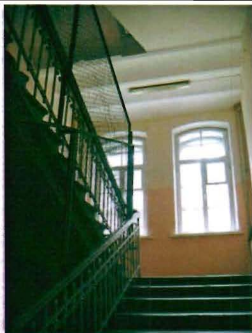
Фото 56. Лестница в центральной части здания. Фрагмент.
