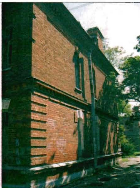
Фото 138. Южный фасад. Общий вид.
