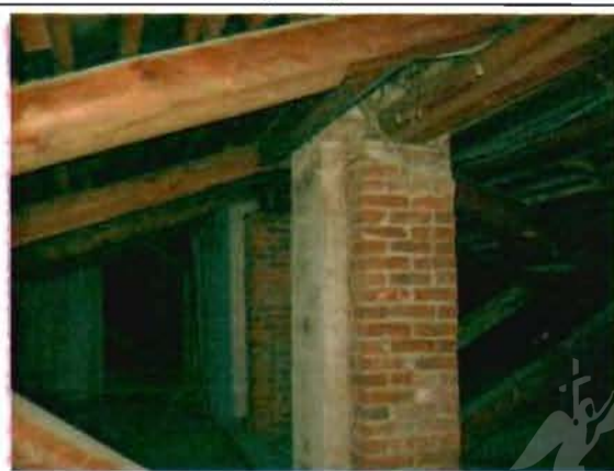
Фото 142. Конструкции крыши. Фрагмент.
