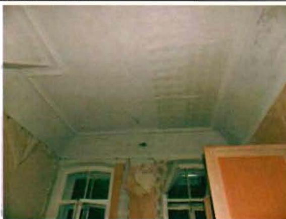
Фото 121. Помещение 1-го этажа.
