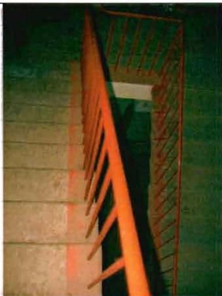
Фото 149. Лестница № 1 в северной части здания. Общий вид.
