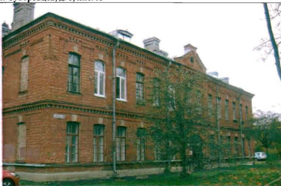
Фото 103. Восточный фасад. Общий вид.
