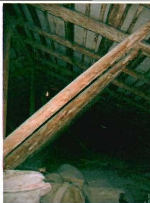
Фото 27. Конструкции крыши. Фрагмент.
