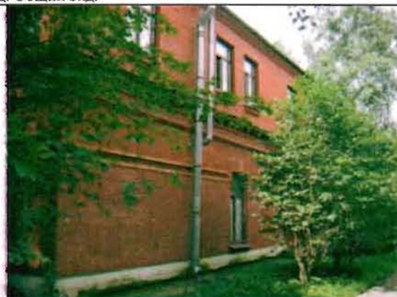
Фото 80. Северный фасад. Фрагмент.
