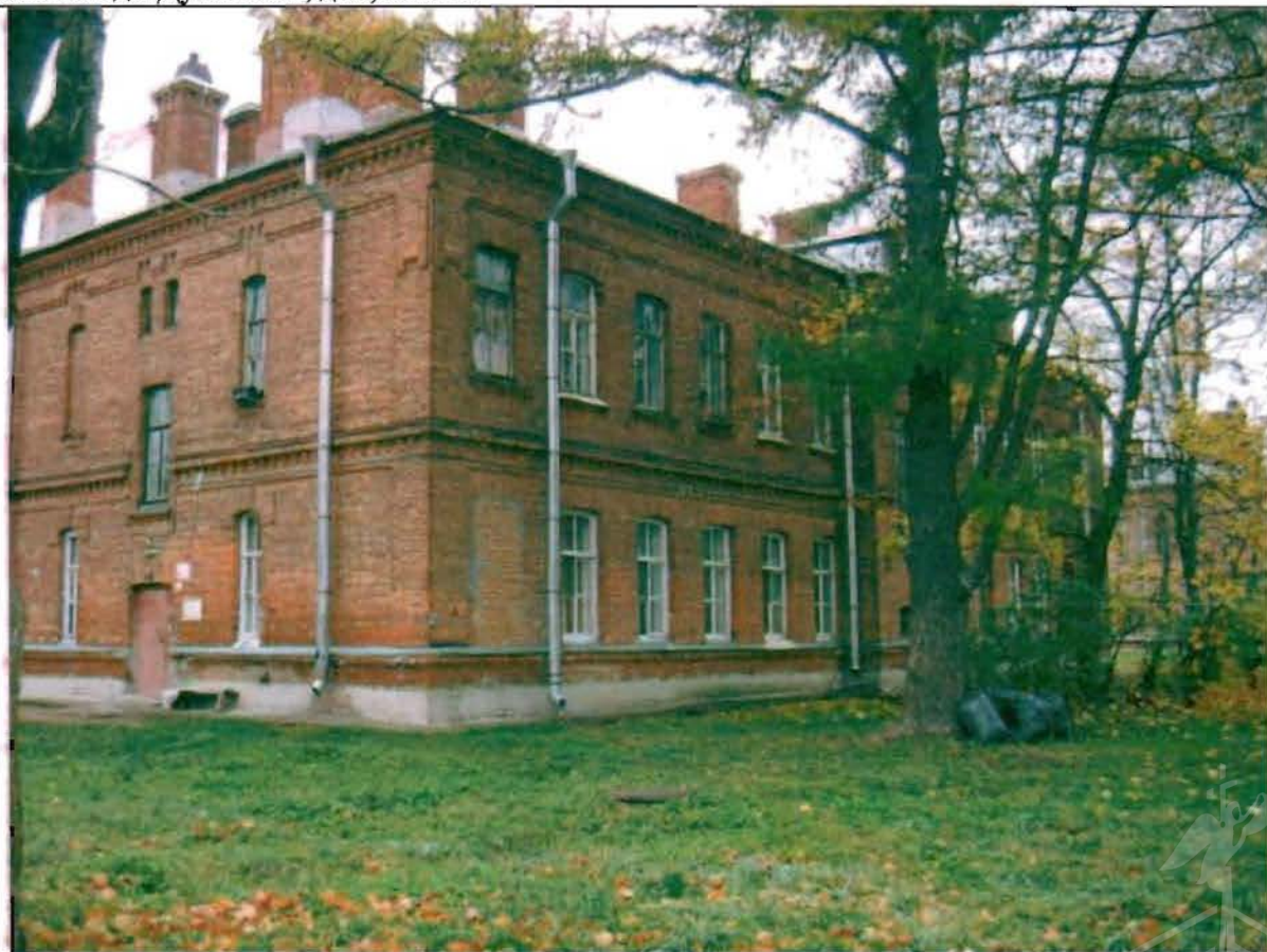
Фото 145. Восточный фасад. Общий вид.
