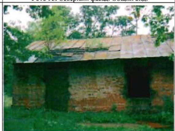
Фото 97. Южный фасад. Общий вид.
