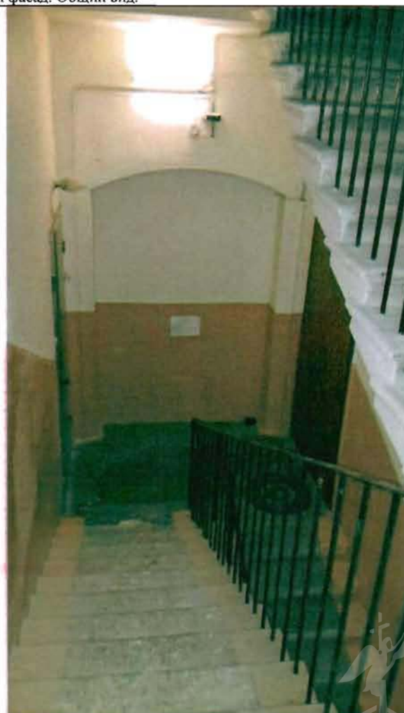
Фото 173. Лестница № 1 в северной части здания. Фрагмент.
