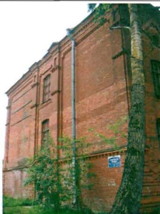
Фото 6. Северный фасад. Общий вид.
