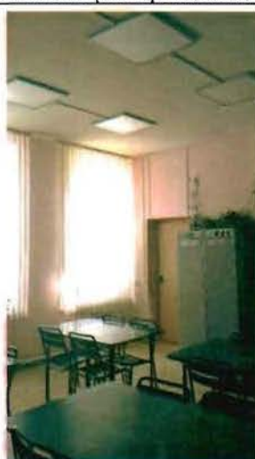
Фото 169. Помещение в уровне 1-го этажа. Общий вид.
