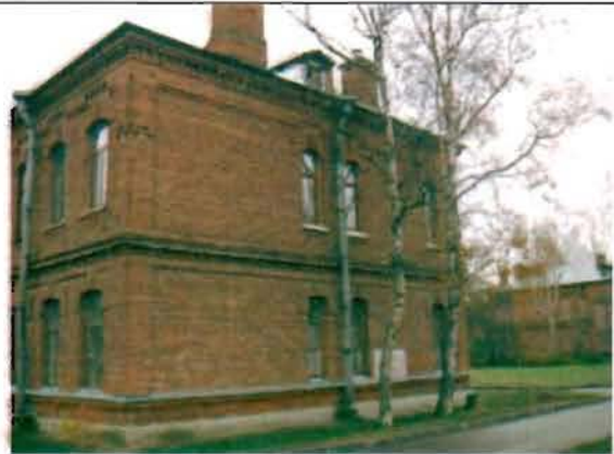
Фото 160. Северный фасад. Общий вид.
