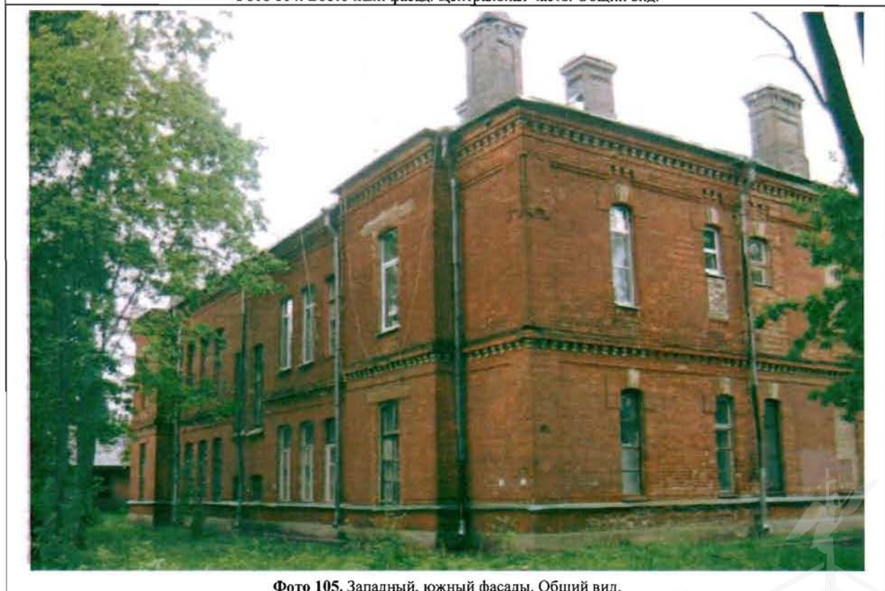
Фото 105. Западный, южный фасады. Общий вид.
