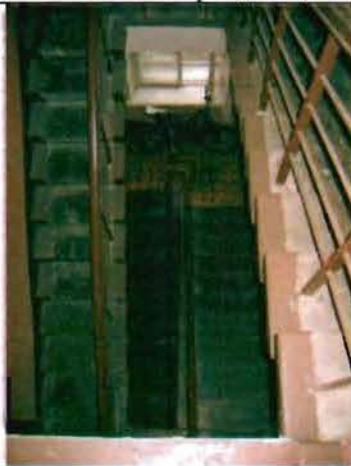
Фото 87. Лестница № 1. Общий вид.
