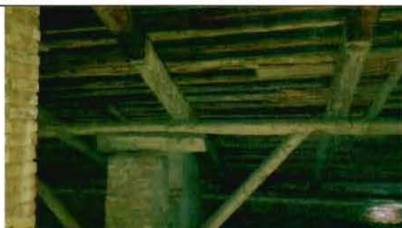
Фото 38. Конструкции крыши. Фрагмент.
