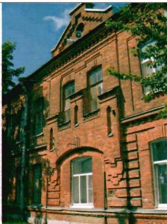
Фото 137. Восточный фасад. Фрагмент.
