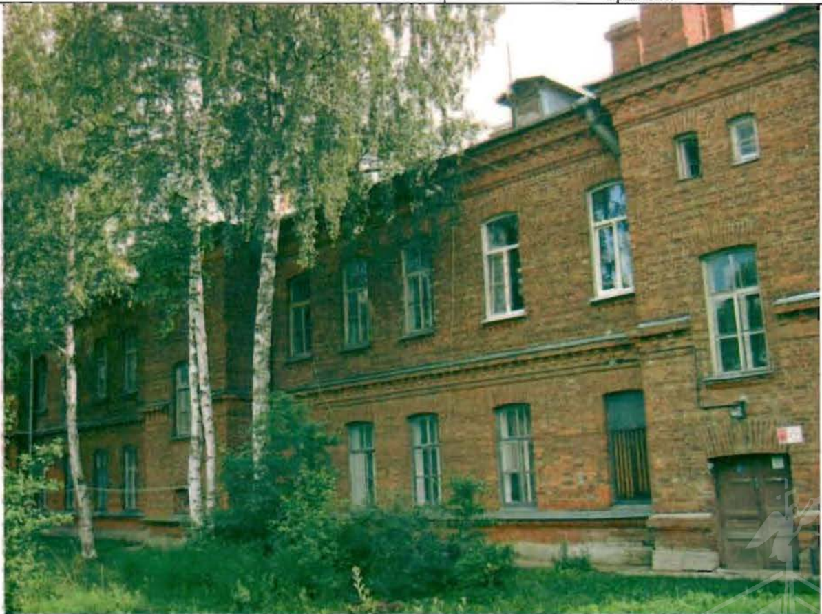
Фото 179. Западный фасад. Общий вид.
