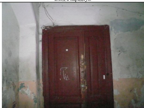
Фото №12 Вход в кв. 1
