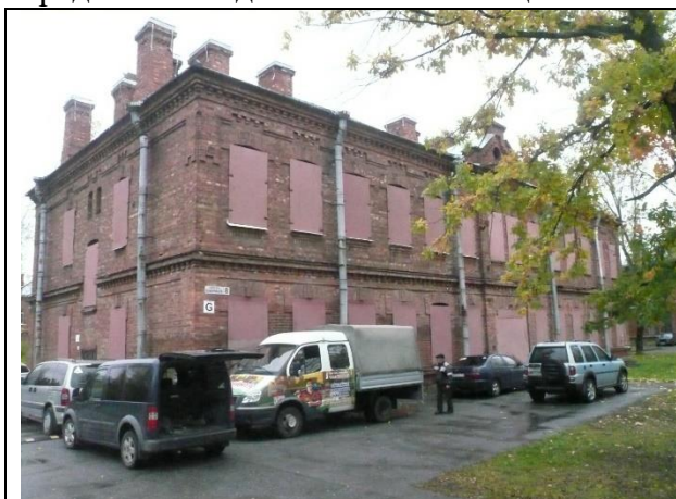
Фото №1 Фасад дома
