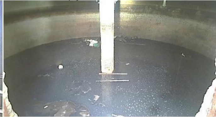
Фото 14. Внутреннее состояние объекта
