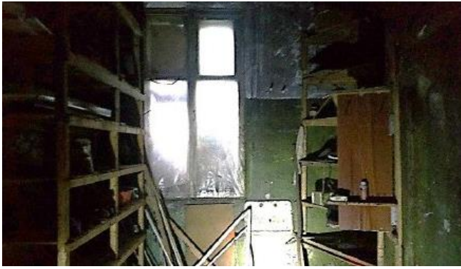
Фото 11. Внутреннее состояние объекта
