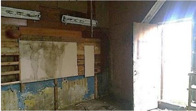
Фото 13. Внутреннее состояние объекта
