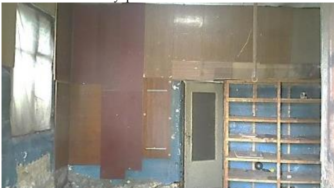
Фото 9. Внутреннее состояние объекта
