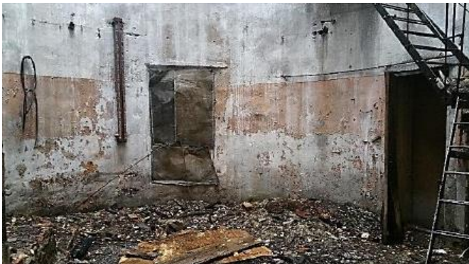
Фото 7. Внутреннее состояние объекта
