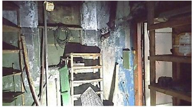
Фото 12. Внутреннее состояние объекта
