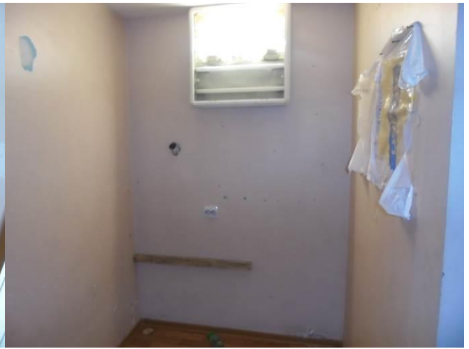
Фото 23 Общий вид и состояние помещения (ч. п. № 7)
