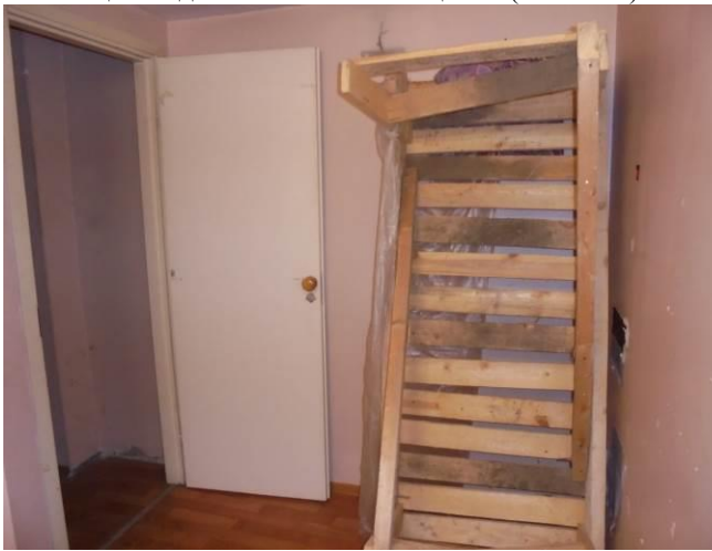
Фото 24 Общий вид и состояние помещения (ч. п. № 7)
