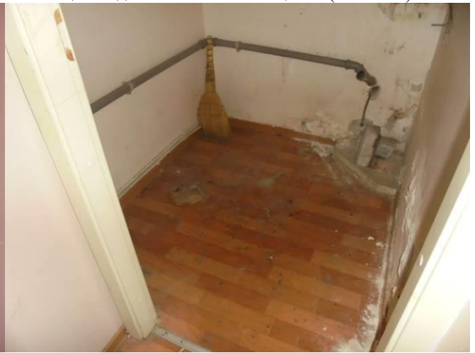
Фото 25 Общий вид и состояние помещения (ч. п. № 8)
