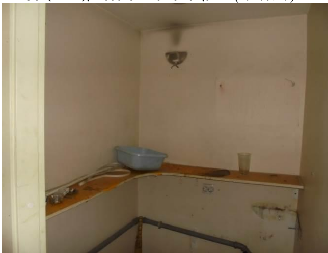
Фото 26 Общий вид и состояние помещения (ч. п. № 8)
