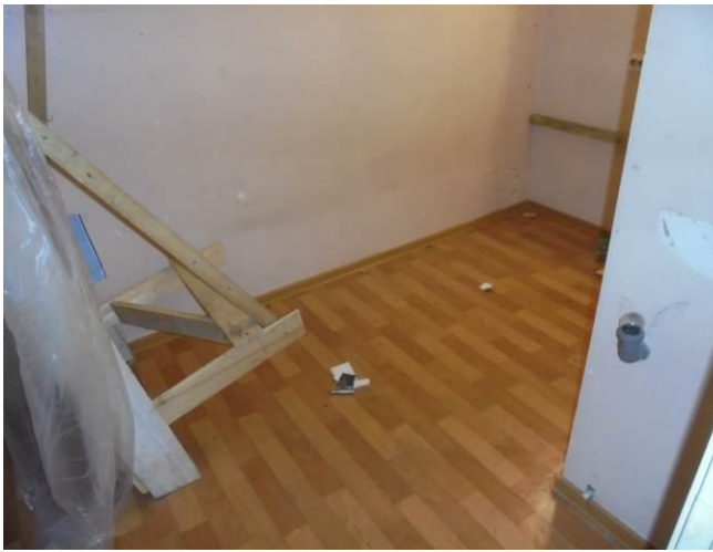
Фото 22 Общий вид и состояние помещения (ч. п. № 7)
