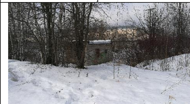
Фото 9. Вид фасада здания.
