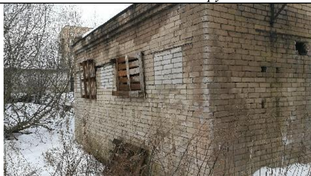
Фото 8. Вид фасада здания.
