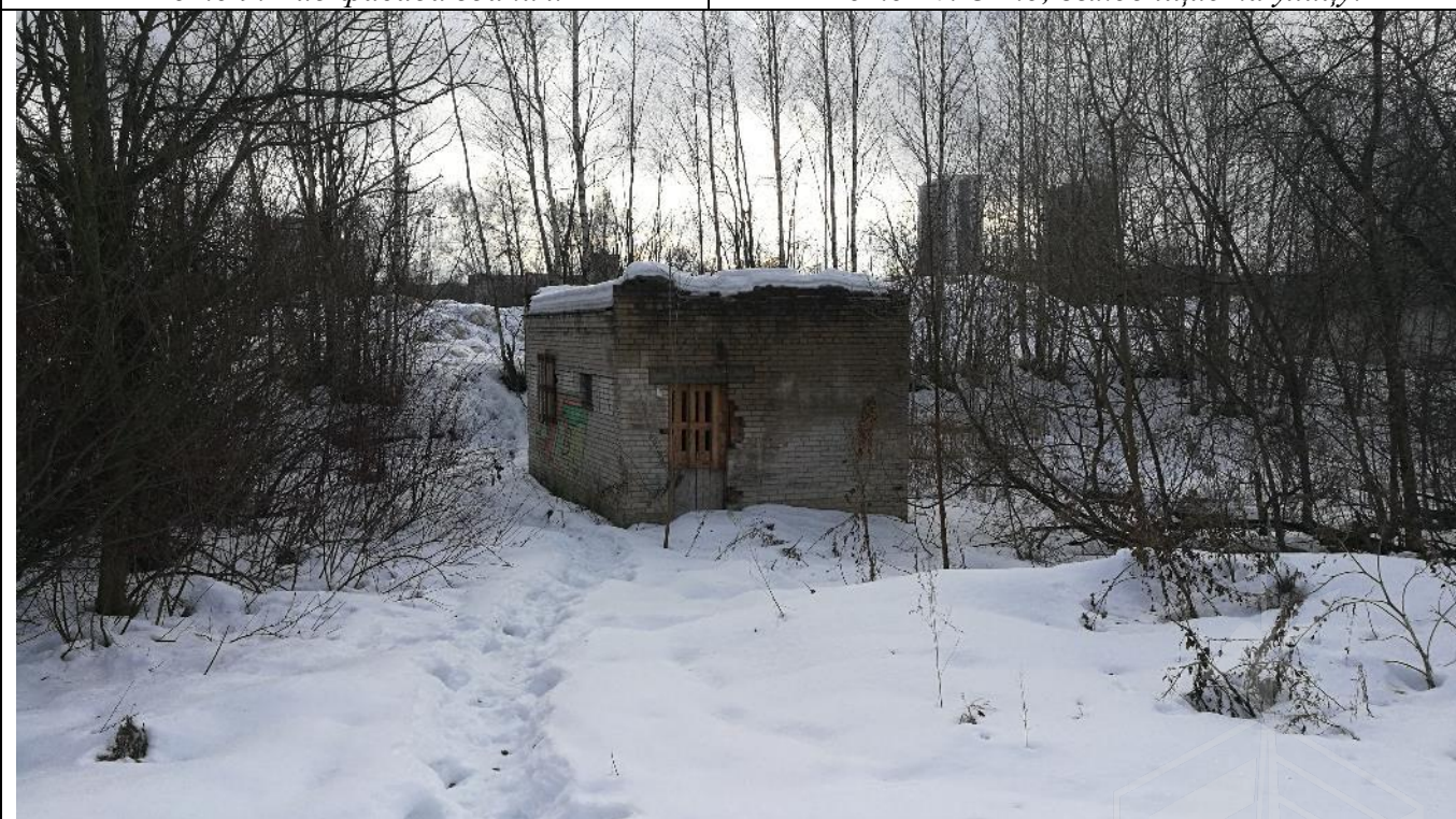
Фото 11. Вид фасада здания.
