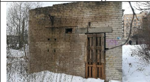
Фото 7. Вид фасада здания.
