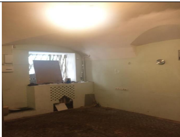
Фото 13. Состояние отделки Объекта оценки
