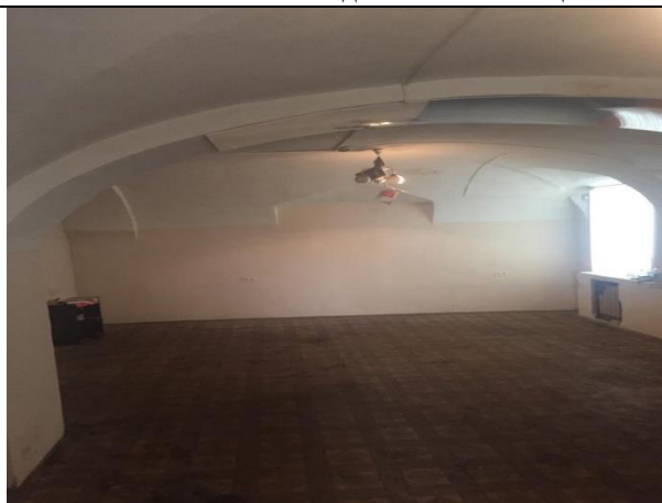
Фото 16. Состояние отделки Объекта оценки
