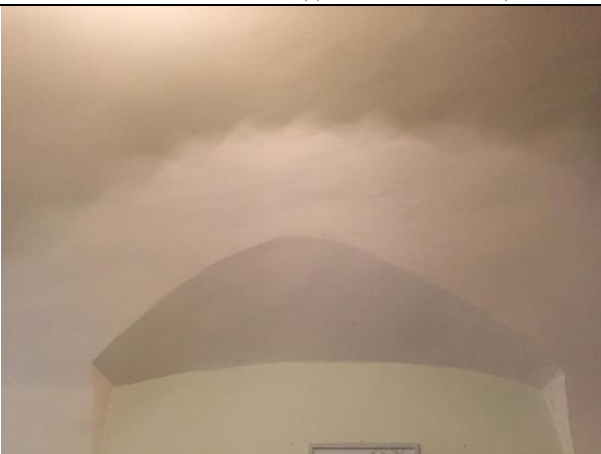
Фото 17. Состояние отделки Объекта оценки
