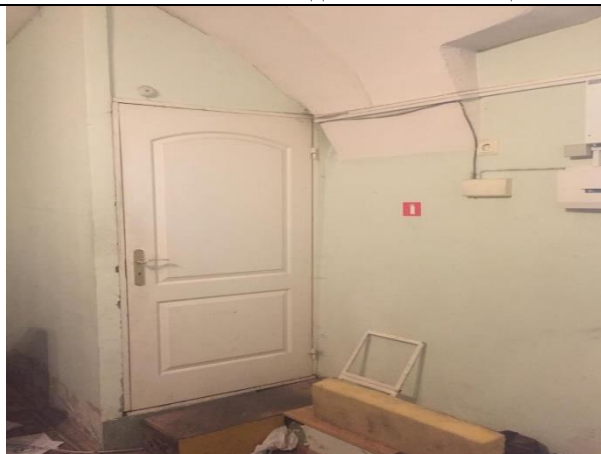
Фото 18. Состояние отделки Объекта оценки
