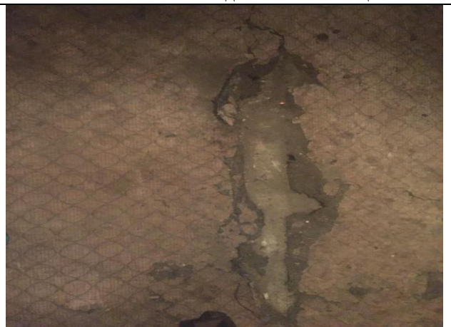
Фото 24. Состояние отделки Объекта оценки
