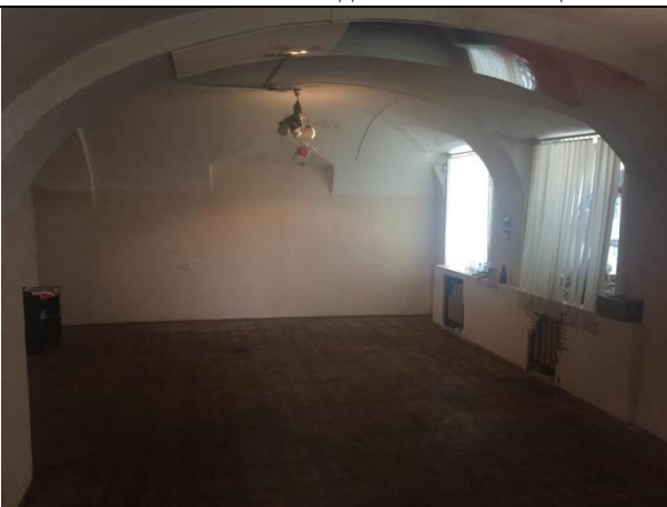
Фото 15. Состояние отделки Объекта оценки
