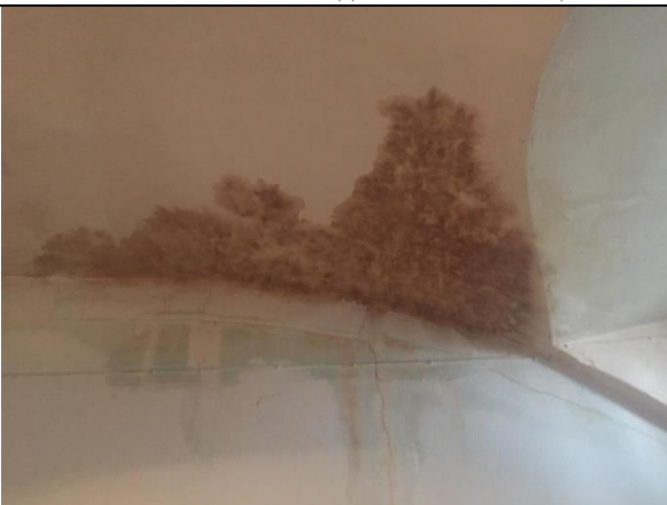
Фото 19. Состояние отделки Объекта оценки
