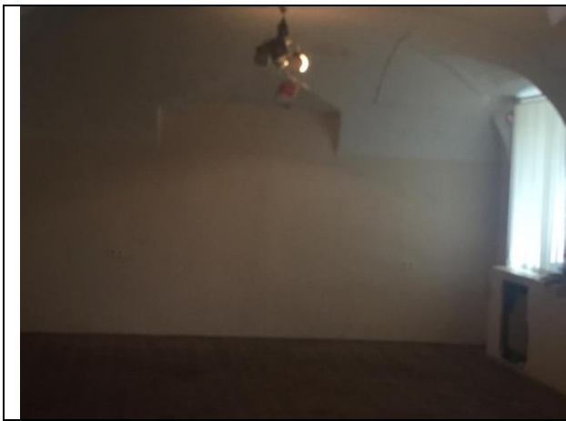
Фото 21. Состояние отделки Объекта оценки
