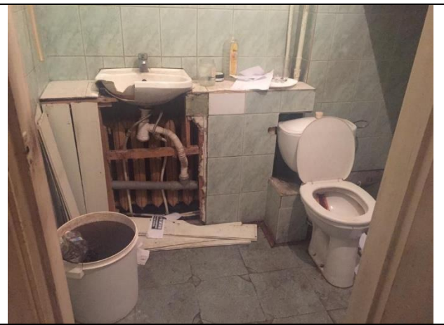
Фото 22. Состояние отделки Объекта оценки
