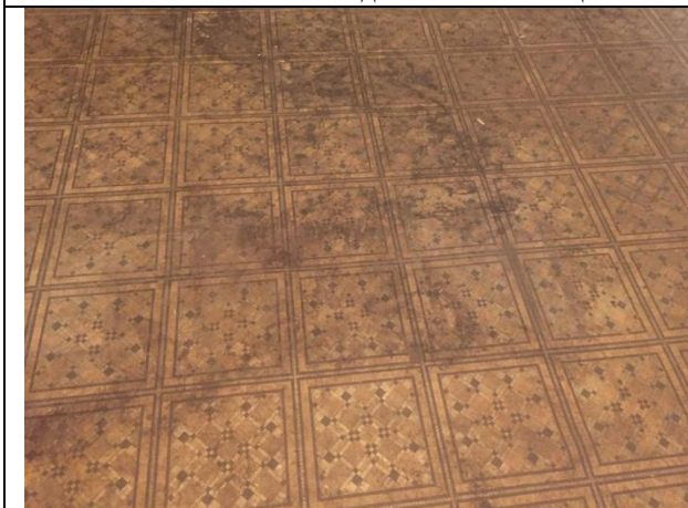
Фото 23. Состояние отделки Объекта оценки
