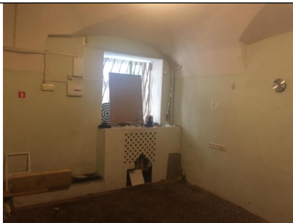
Фото 14. Состояние отделки Объекта оценки
