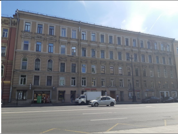
Фото 1. Вид на здание размещения Объекта оценки.
