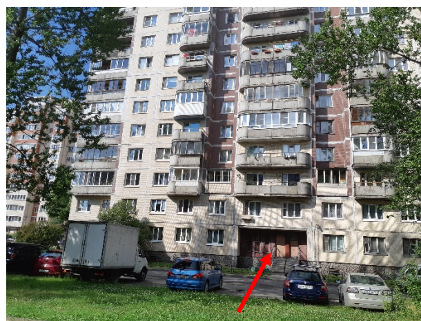
Фото 2. Вид на здание размещения Объекта оценки со двора (стрелкой указан вход в Объект оценки)
