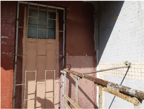
Фото 19. Вид окон Объекта оценки
