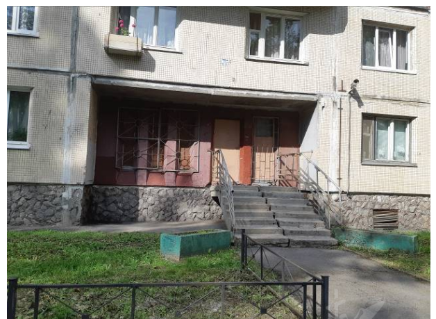
Фото 8. Вид отдельного входа со двора
