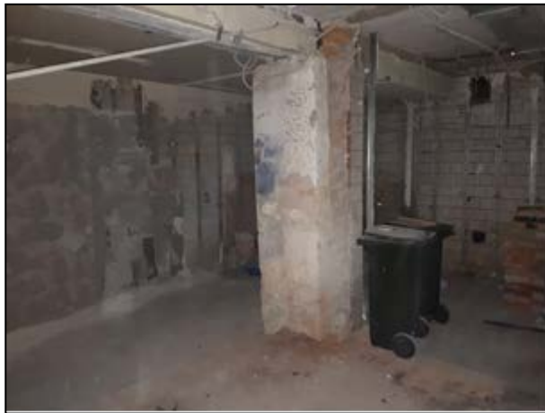
Фото 29. Состояние отделки (демонтирована часть стены между ч.п.)
