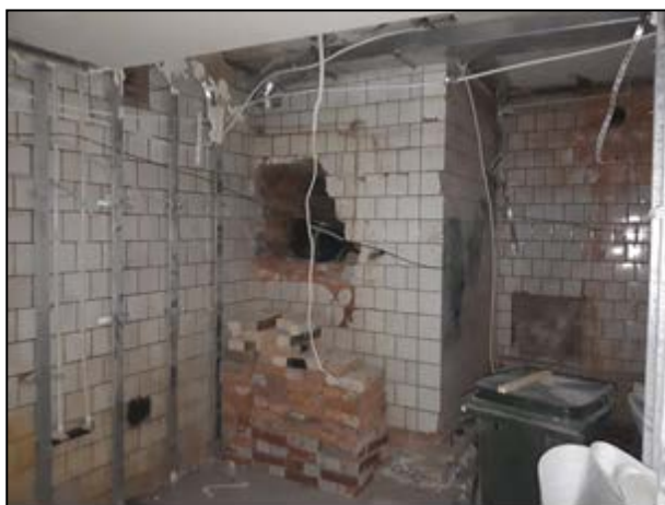
Фото 17. Доступ в помещение – отдельный вход со двора в виде погрузочного окна, высотой не более 0,7 м (вид со стороны помещения)
