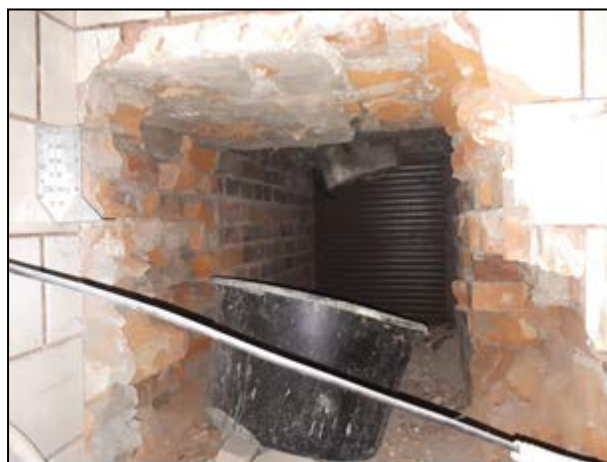
Фото 18. Отдельный вход со двора (в виде погрузочного окна, высотой не более 0,7 м) – вид со стороны помещения
