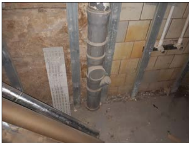
Фото 37. Состояние санитарно-технического оборудования
