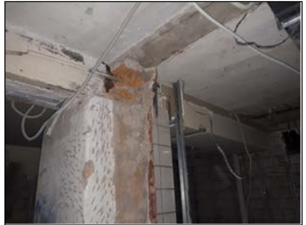
Фото 28. Состояние отделки (демонтирована часть стены между ч.п.)
