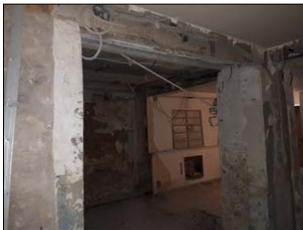
Фото 22. Ч.п. 1-3 (демонтирована часть стены между ч.п.)
