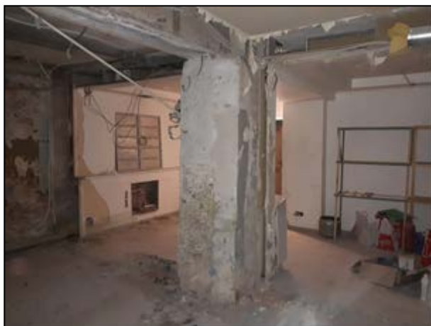
Фото 21. Ч.п. 1-3 (демонтирована часть стены между ч.п.)
