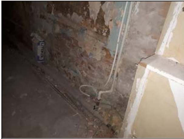
Фото 39. Состояние санитарно-технического оборудования
