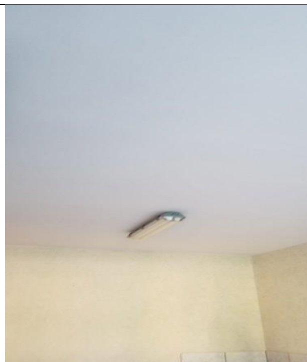
Фото 20. Общий вид и типичное состояние потолка в объекте оценки.
