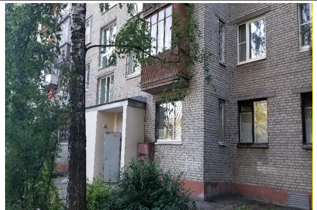
Фото 8. Общий вход в объект оценки со двора.
