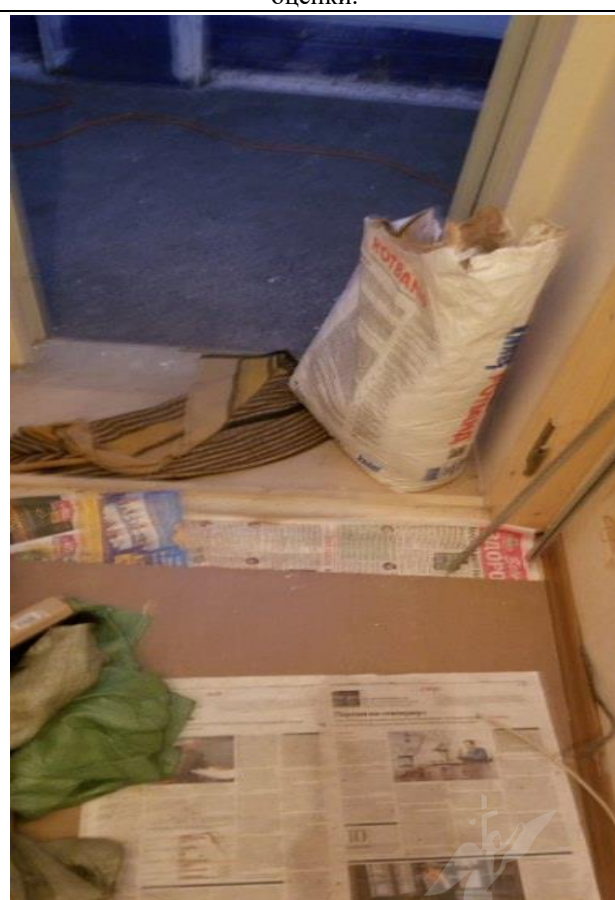
Фото 30. Общий вид и типичное состояние объекта оценки.
