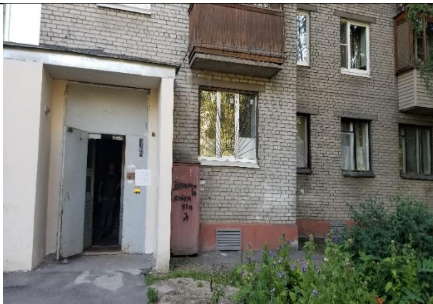
Фото 7. Общий вход в объект оценки со двора.
