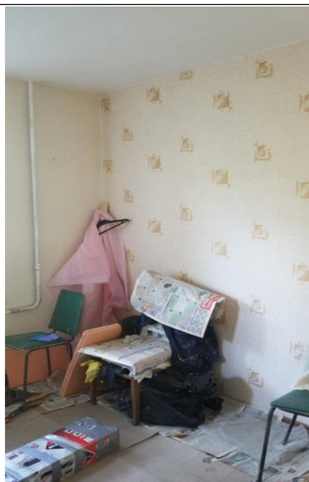
Фото 16. Общий вид и типичное состояние объекта оценки.
