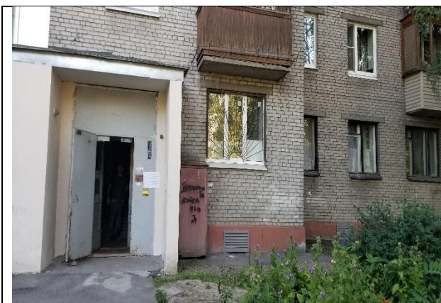
Фото 7. Общий вход в объект оценки со двора.
