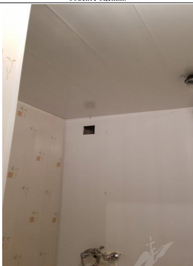
Фото 26. Общий вид и типичное состояние объекта оценки.
