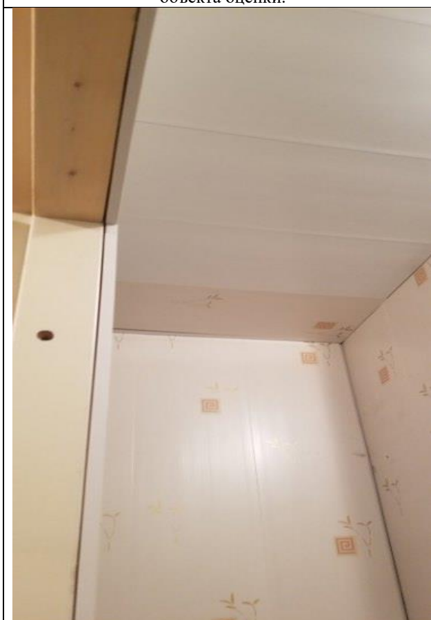
Фото 29. Общий вид и типичное состояние объекта оценки.
