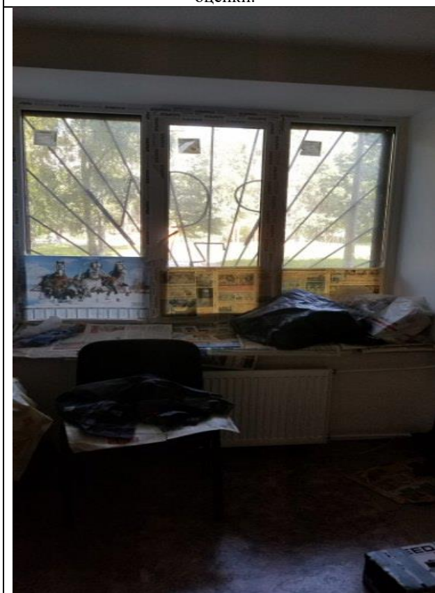
Фото 17. Общий вид и типичное состояние объекта оценки.
