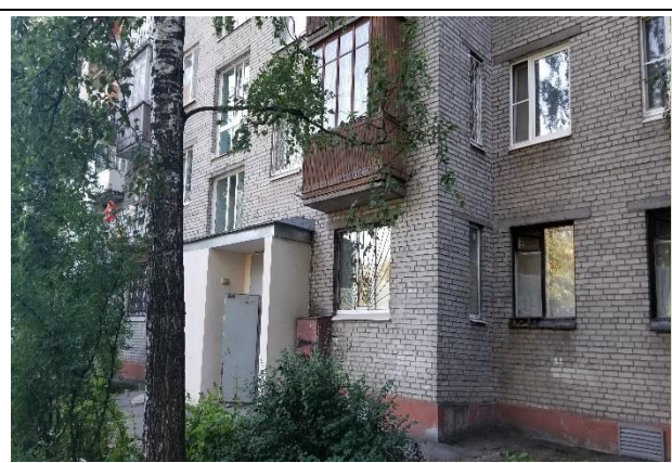
Фото 8. Общий вход в объект оценки со двора.
