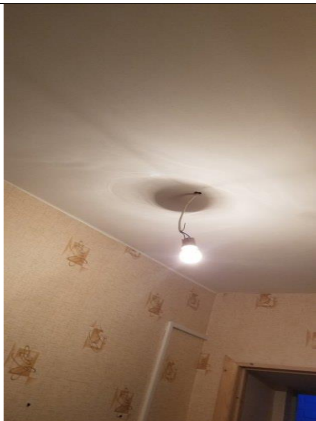
Фото 24. Общий вид и типичное состояние потолка в объекте оценки.
