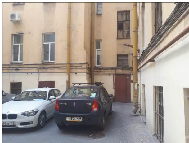
Фото 22. Состояние дворовых фасадов здания
