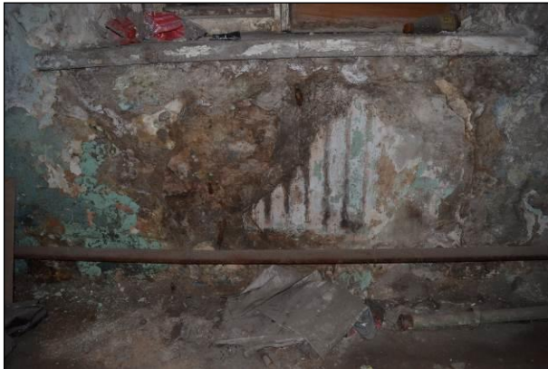
Фото 37. Состояние отопительных приборов (демонтированы)
