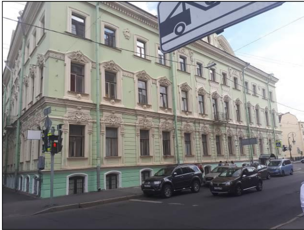
Фото 15. Общий вид здания со стороны Почтамтского переуллка
