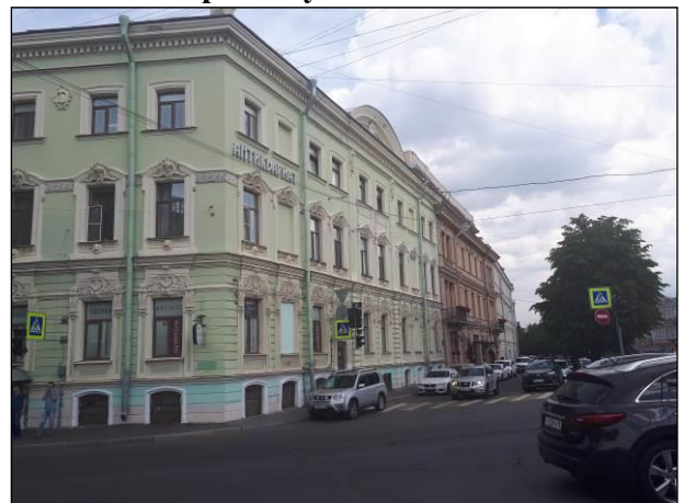
Фото 14. Общий вид здания со стороны наб. р. Мойки
