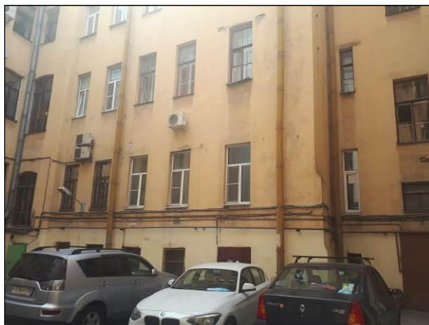
Фото 21. Состояние дворовых фасадов здания
