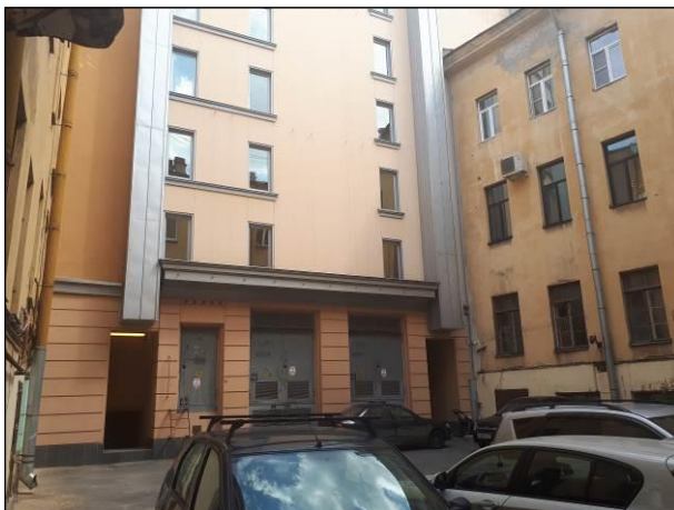
Фото 19. Стена соседнего здания № 54 по Большой Морской улице (гостиница)
