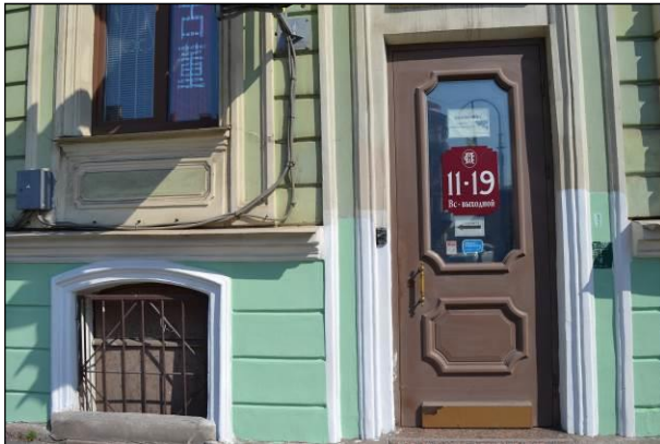
Фото 64. Окна помещения (над четвертым окном оборудован вход в магазин «Антиквариат», расположенный на первом этаже над оцениваемым помещением)
