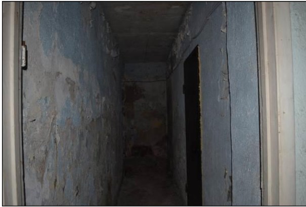
Фото 33. Часть помещения 7 (металлическая дверь – вход со стороны дворовой территории, ключ утерян)
