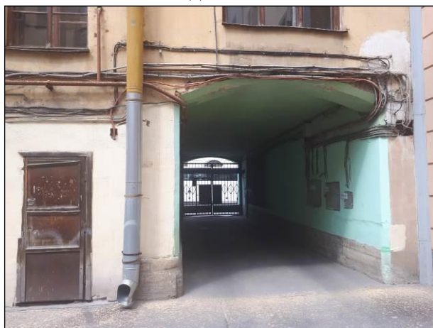
Фото 23. Арка жилого дома, вид со стороны двора
