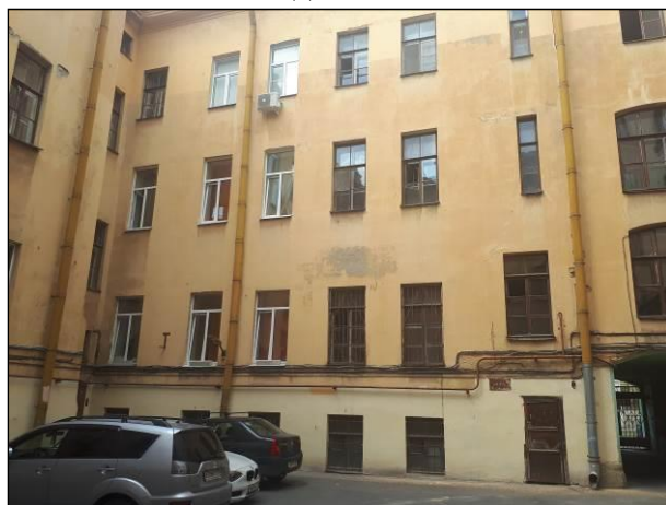
Фото 24. Состояние дворовых фасадов здания
