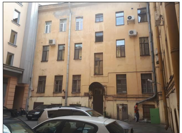
Фото 20. Состояние дворовых фасадов здания
