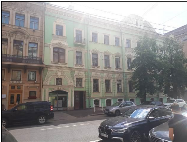
Фото 17. Фасад здания со стороны Большой Морской улицы (арка – вход во двор)
