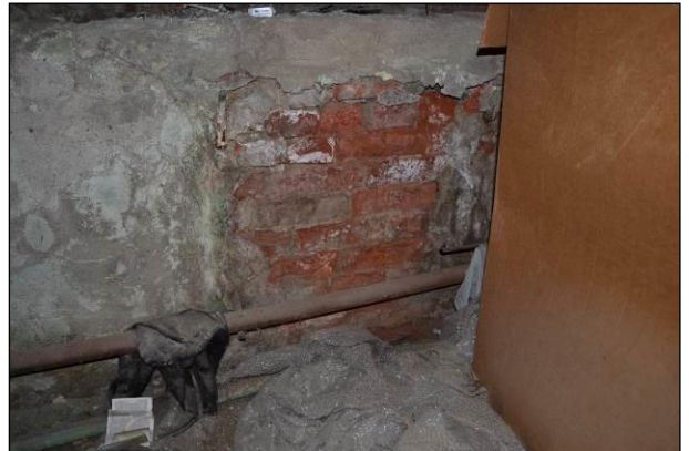
Фото 38. Состояние отопительных приборов (демонтированы)
