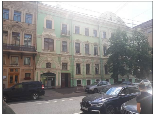
Фото 18. Фасад здания со стороны Большой Морской улицы (арка – вход во двор)
