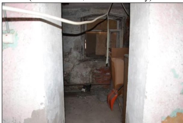
Фото 29. Вход в помещения 5 и 6 (объединены)
