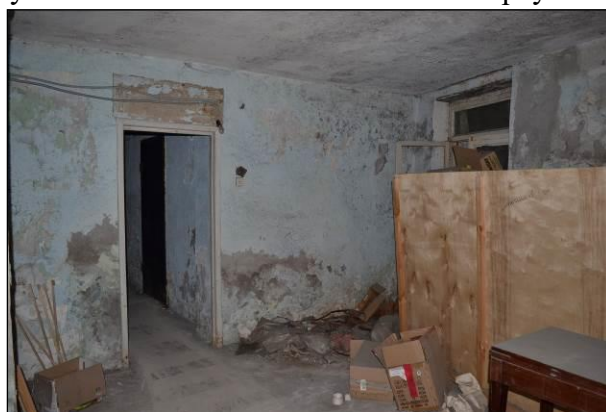
Фото 32. Проход в помещения 1, 2, 3 и 4
