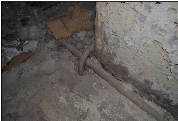
Фото 43. Инженерные коммуникации в помещении
