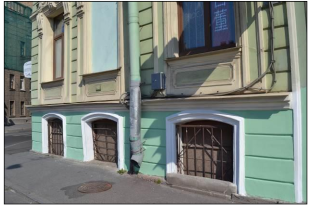
Фото 63. Окна помещения (три окна выходят на наб. р. Мойки)
