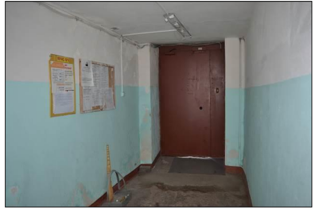
Фото 51. Дверь парадной, вид изнутри
