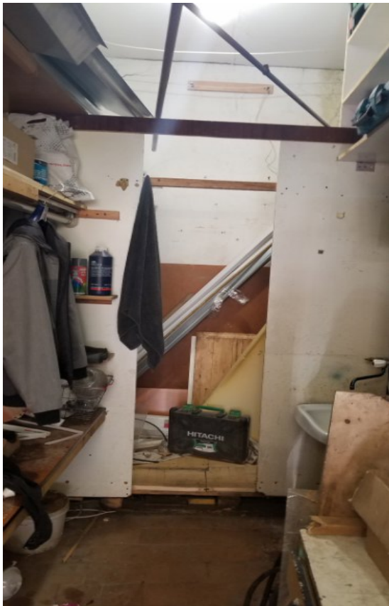
Фото 13. Общий вид и типичное состояние объекта оценки.
