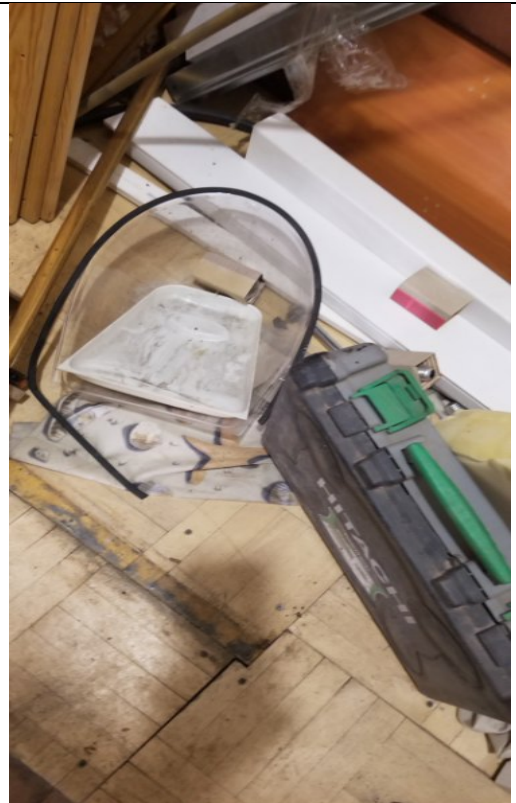
Фото 16. Общий вид и типичное состояние объекта оценки. Состояние пола.
