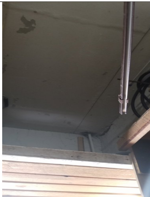
Фото 20. Общий вид и типичное состояние объекта оценки. Состояние потолка.
