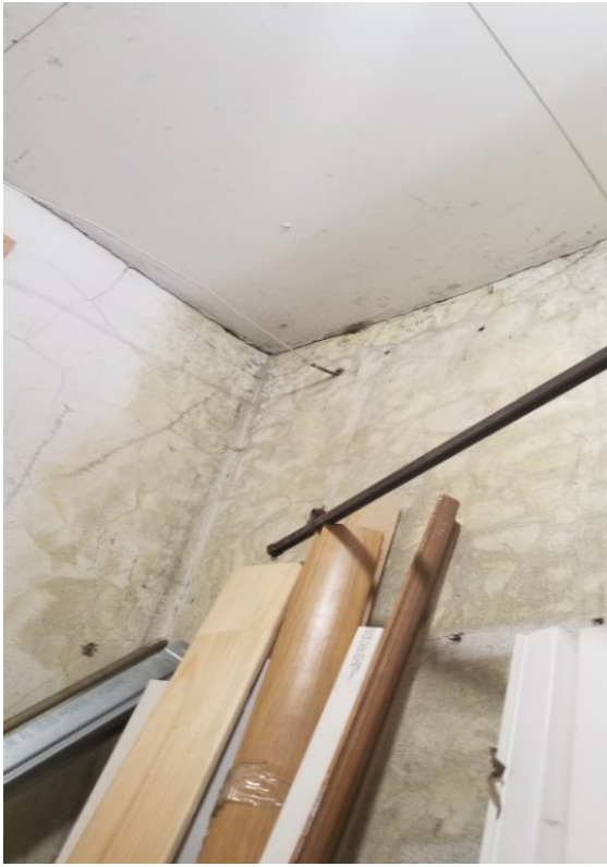
Фото 15. Общий вид и типичное состояние объекта оценки. Состояние потолка
