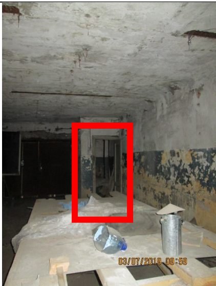
Фото 9. Часть помещения 1. Вид на часть помещения 2.
