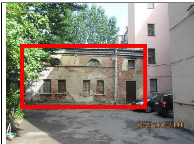
Фото 7. Здание размещения Объекта оценки - двухэтажная пристройка к четырехэтажному зданию.
