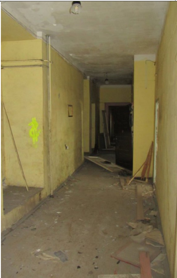
Фото 57. Состояние ч.п.1 пом. 3С-Н
