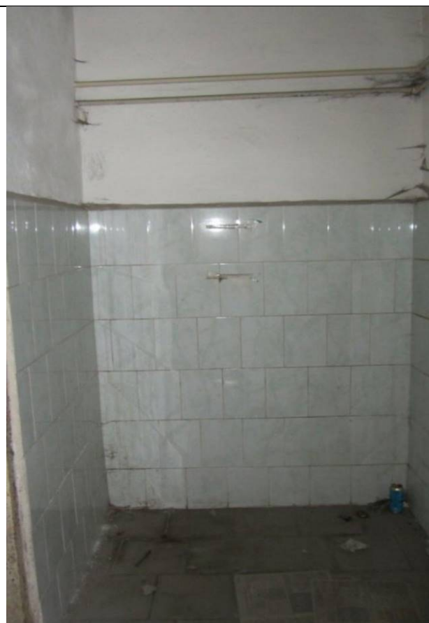
Фото 62. Состояние ч.п. 4 пом. 3С-Н
