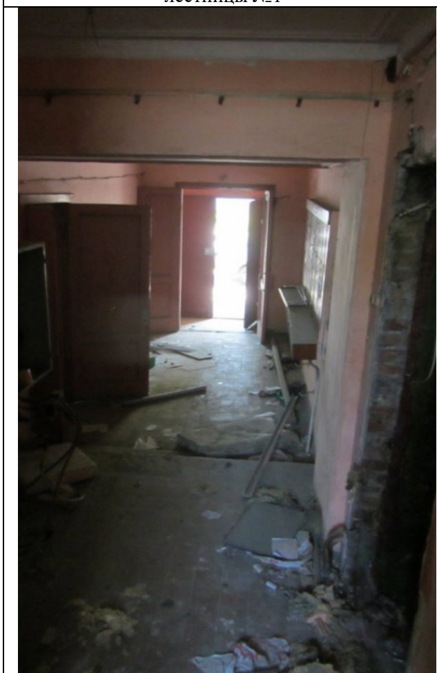
Фото 31. Состояние лестничной клетки №1
