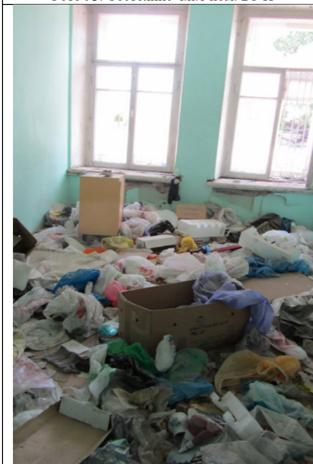
Фото 95. Состояние ч.п.5 пом. 2С-Н
