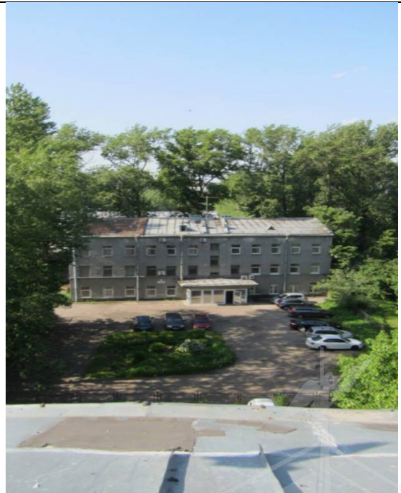
Фото 138. Вид из окна пом. 1 н.ч., выходящего во двор
