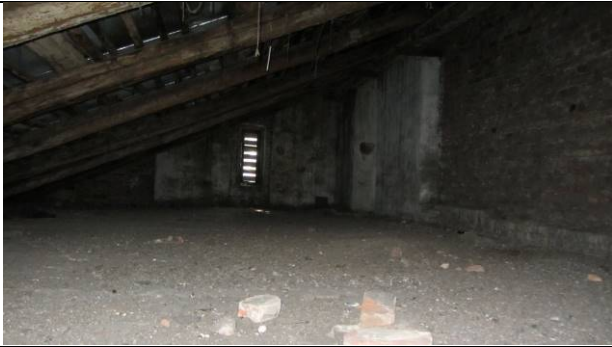
Фото 127. Состояние пом. 1 н.ч.
