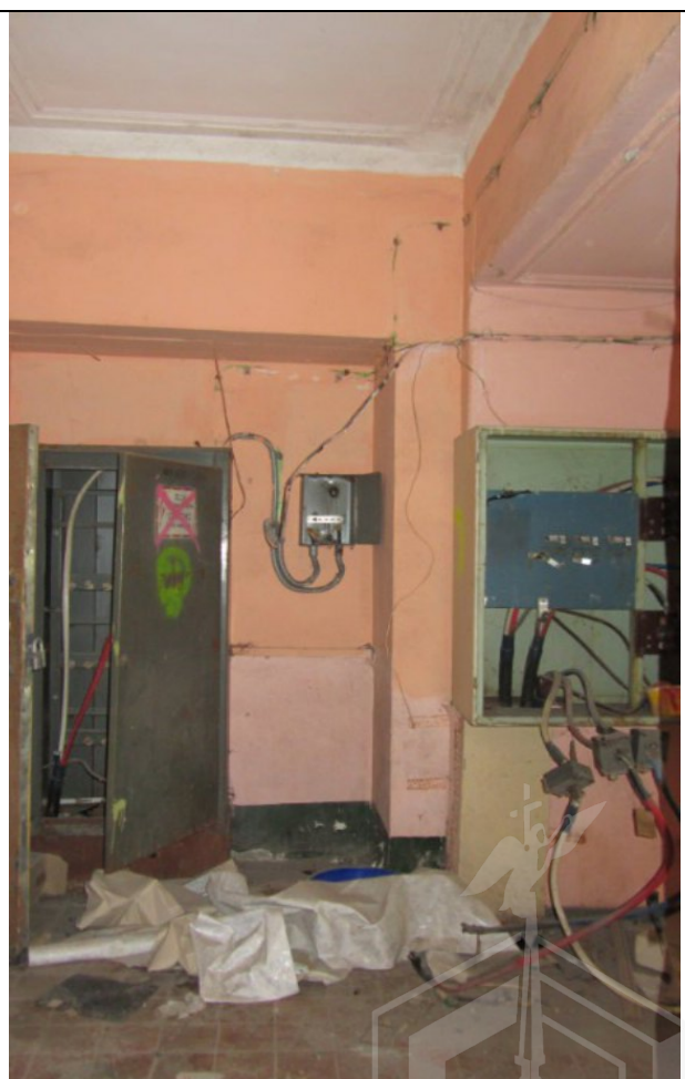
Фото 32. Состояние лестничной клетки №1
