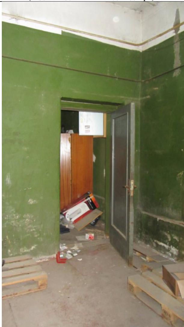
Фото 42. Состояние ч.п.1 пом. 4С-Н (проход в ч.п. 3)
