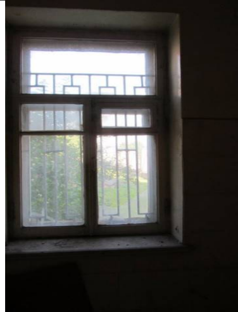
Фото 104. Состояние ч.п.3 пом. 2С-Н
