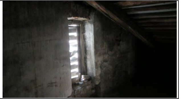
Фото 140. Состояние пом. 1 н.ч.
