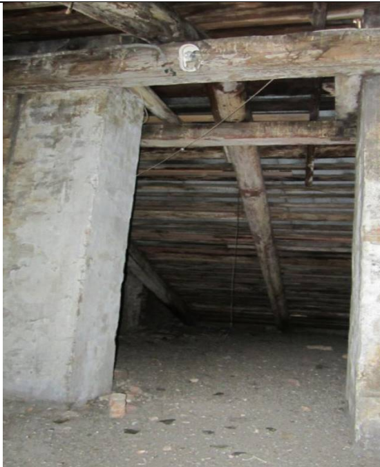
Фото 129. Состояние пом. 1 н.ч.
