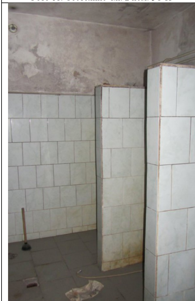
Фото 63. Состояние ч.п. 4 пом. 3С-Н
