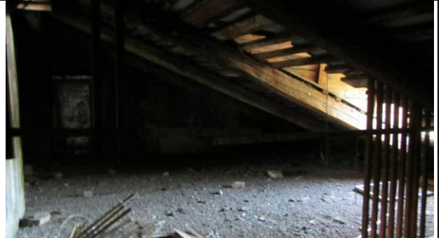
Фото 120. Состояние пом. 1 н.ч.
