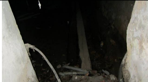
Фото 158. Состояние пом. 1-Н
