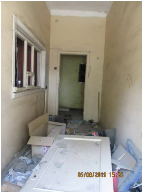
Фото 59. Состояние ч.п. 13 пом. 3С-Н
