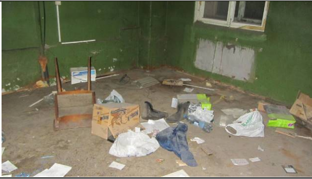
Фото 51. Состояние ч.п.3 пом. 4С-Н
