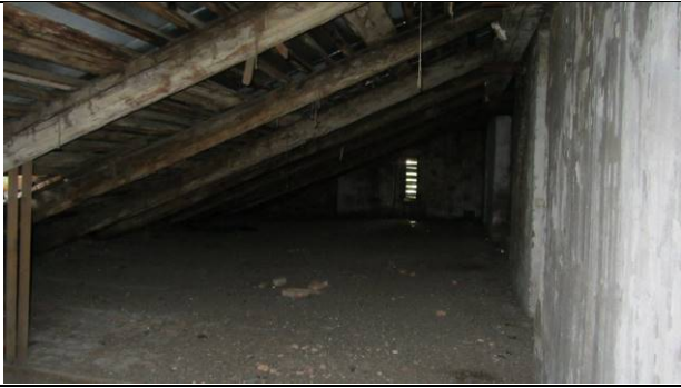
Фото 123. Состояние пом. 1 н.ч.
