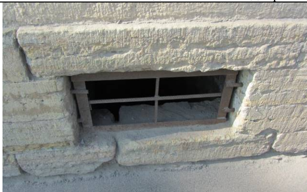
Фото 163. Окно пом. 2-Н, выходящее на улицу
