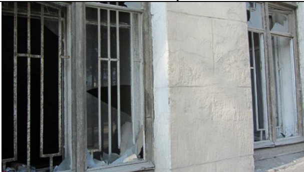
Фото 23. Вид на окна Объекта оценки, выходящие на улицу Чугунная
