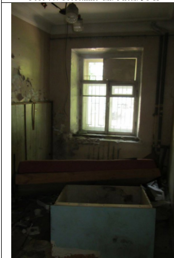
Фото 79. Состояние ч.п. 7 пом. 3С-Н
