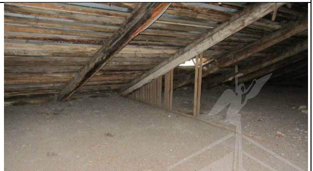
Фото 122. Состояние пом. 1 н.ч.
