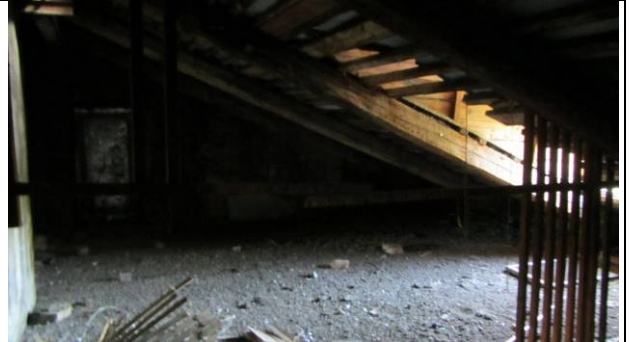
Фото 120. Состояние пом. 1 н.ч.
