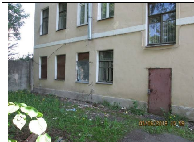
Фото 13. Вход в Объект оценки со двора
