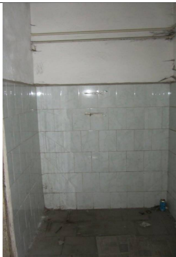
Фото 62. Состояние ч.п. 4 пом. 3С-Н
