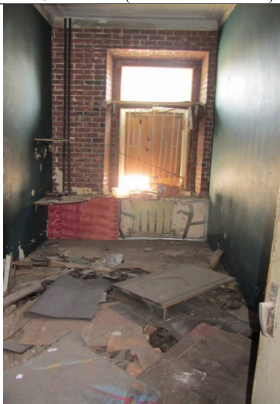
Фото 91. Состояние ч.п.6 пом. 2С-Н
