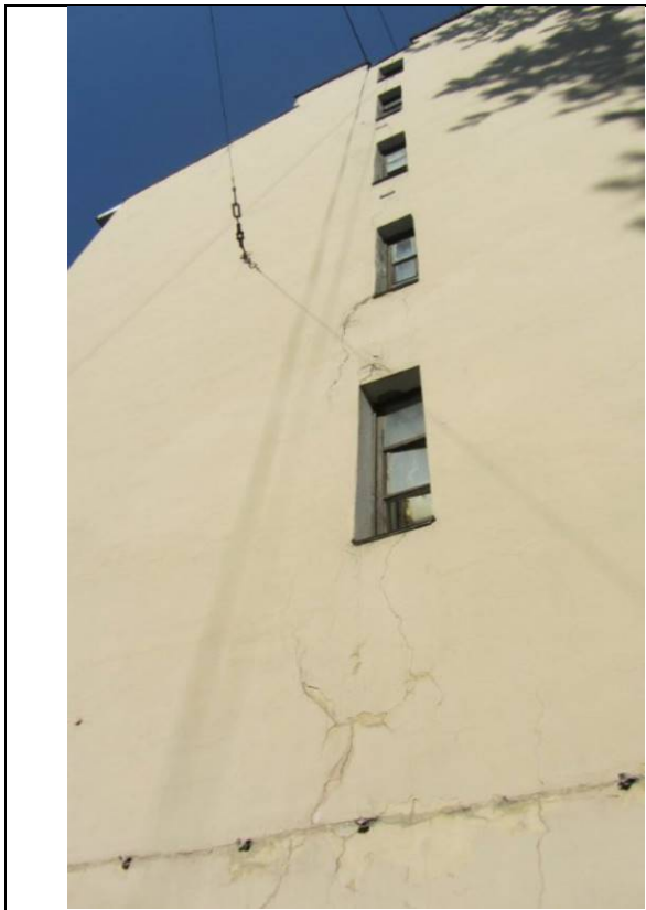
Фото 21. Вид на здание размещения Объекта оценки с торца
