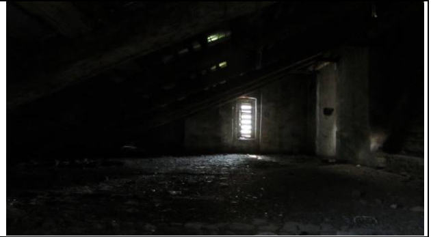
Фото 126. Состояние пом. 1 н.ч.
