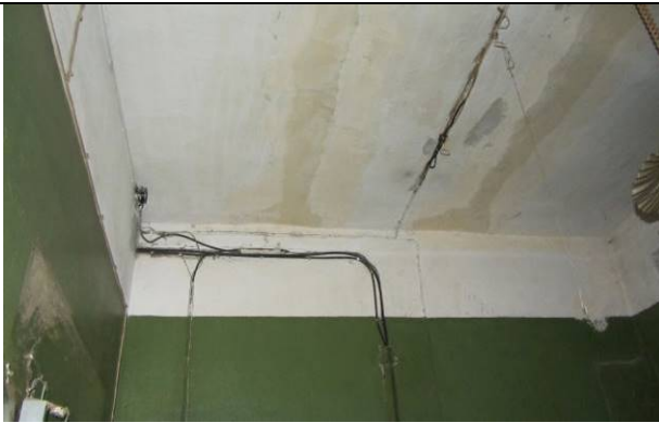
Фото 53. Состояние ч.п.3 пом. 4С-Н
