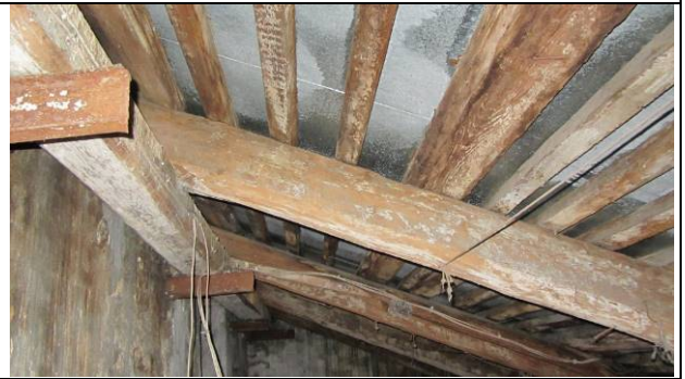
Фото 142. Состояние пом. 1 н.ч.
