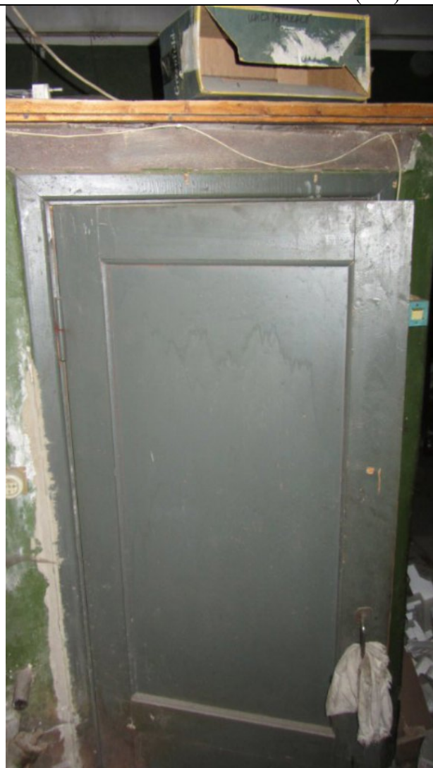
Фото 46. Входная дверь в ч.п. 2 пом. 4С-Н
