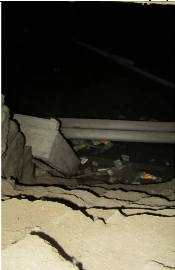
Фото 165. Состояние пом. 2-Н
