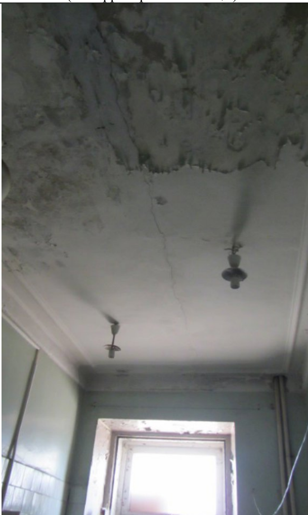
Фото 107. Состояние ч.п.4 пом. 2С-Н
