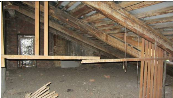
Фото 121. Состояние пом. 1 н.ч.
