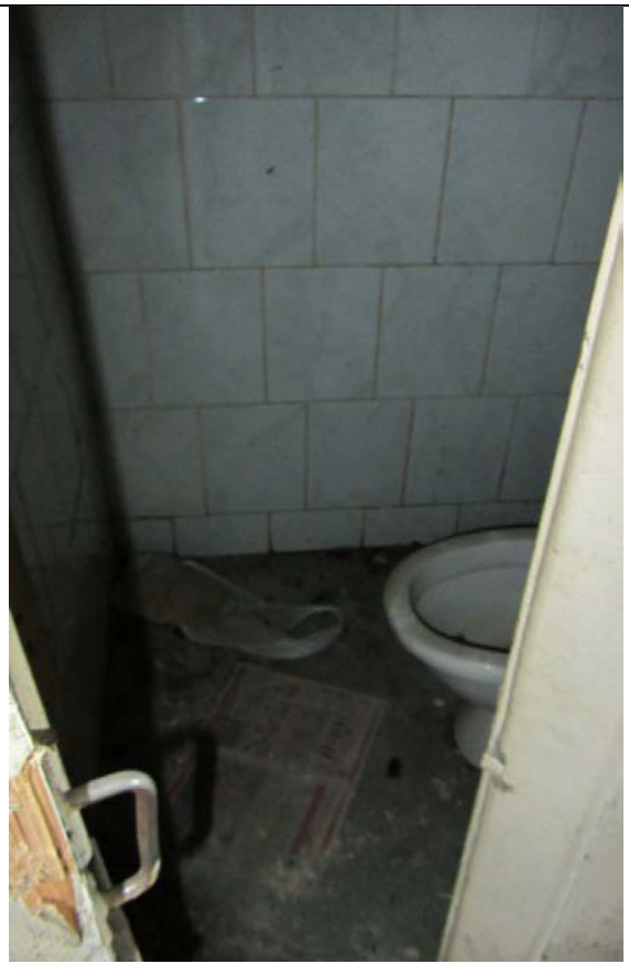
Фото 98. Состояние ч.п.2 пом. 2С-Н
