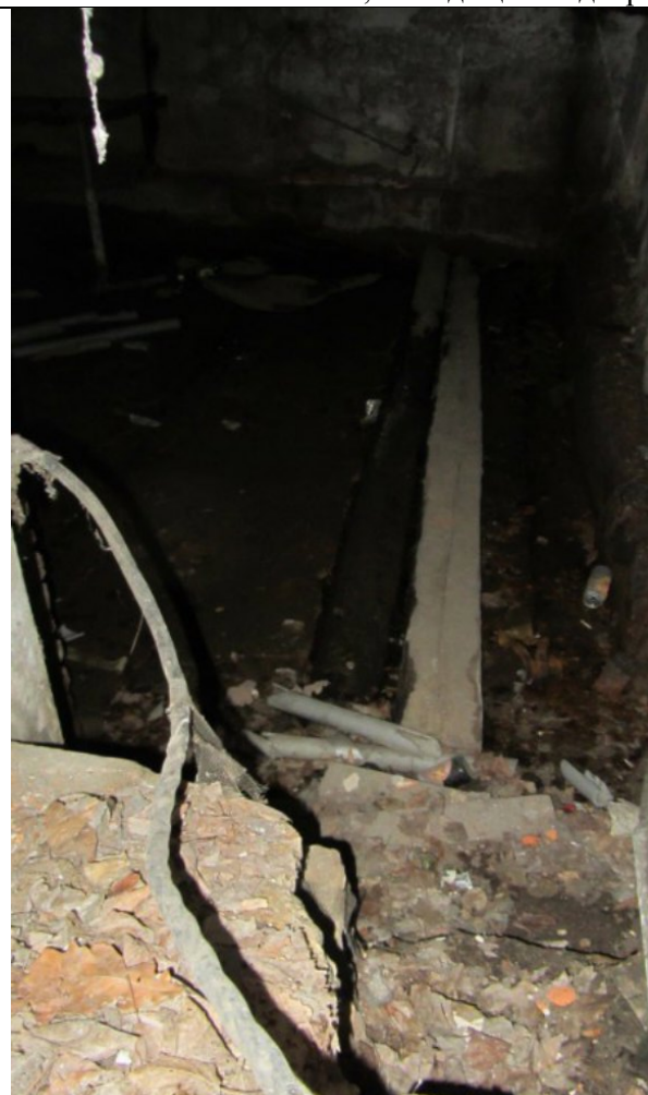
Фото 159. Состояние пом. 1-Н
