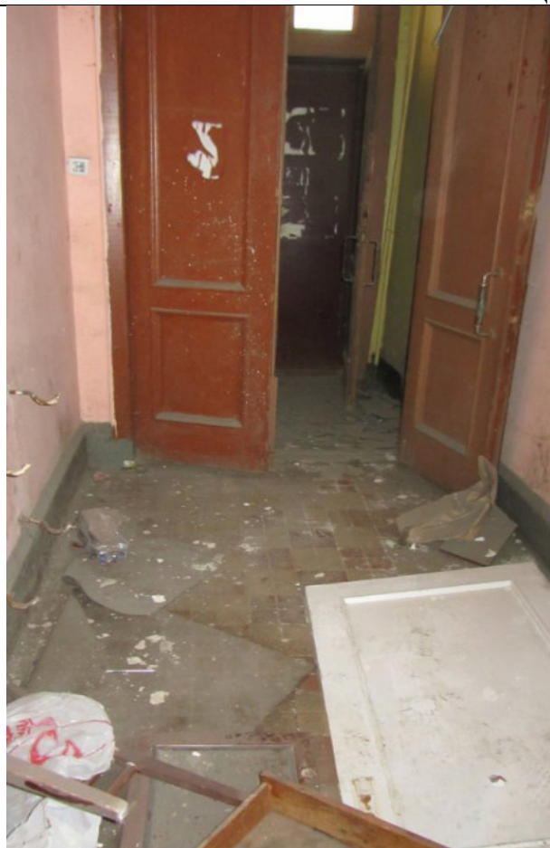
Фото 89. Общий вход с ул. Чугунная для пом. 3С-Н и 2С-Н (лестничная клетка №2)
