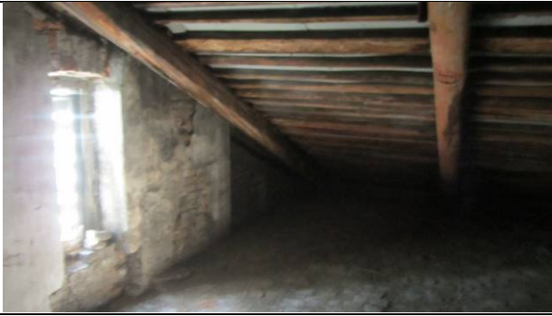
Фото 139. Состояние пом. 1 н.ч.
