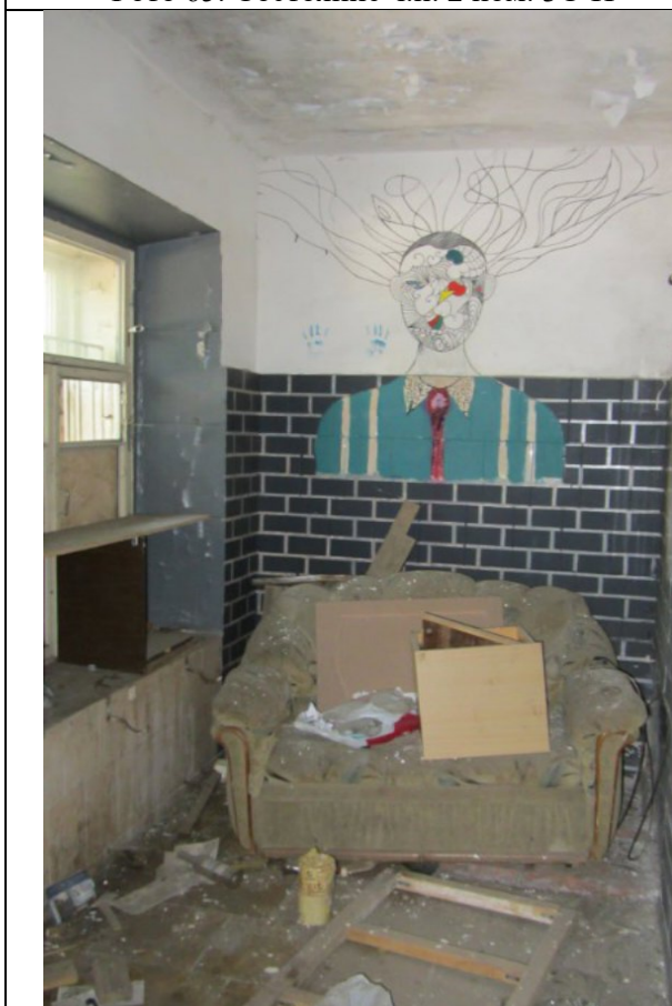
Фото 67. Состояние ч.п. 2 пом. 3С-Н
