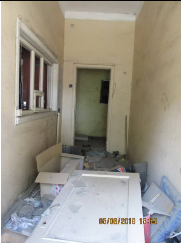
Фото 59. Состояние ч.п. 13 пом. 3С-Н
