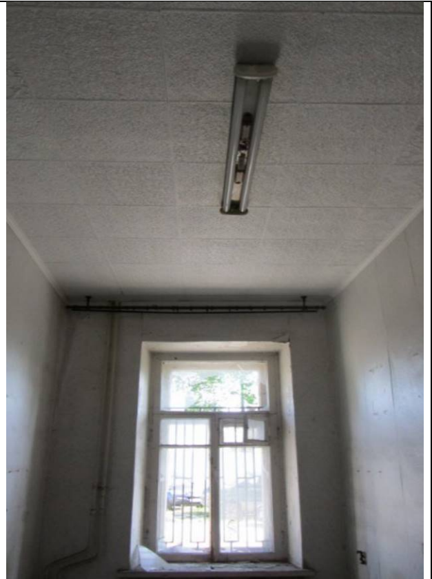
Фото 74. Состояние ч.п. 11 пом. 3С-Н
