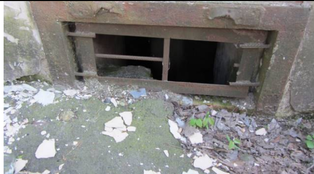
Фото 157. Окно пом. 1-Н, выходящее во двор
