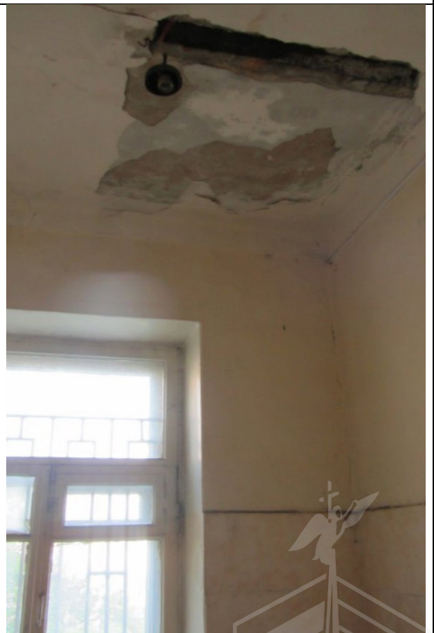
Фото 100. Состояние ч.п.3 пом. 2С-Н
