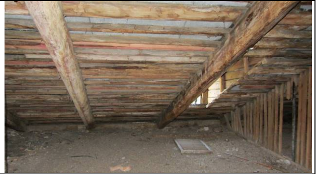
Фото 134. Состояние пом. 1 н.ч.
