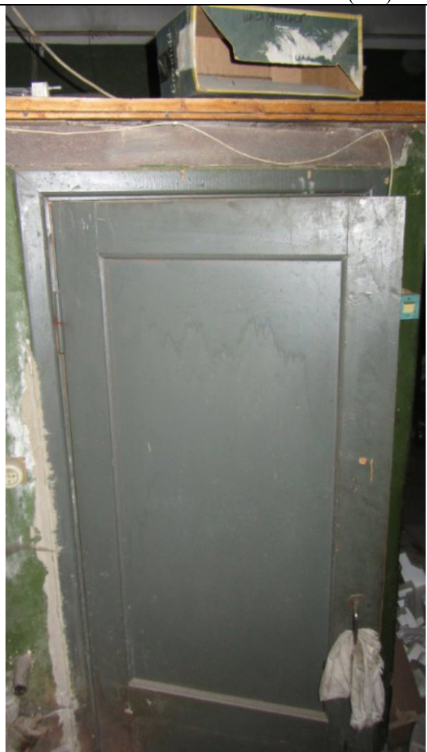
Фото 46. Входная дверь в ч.п. 2 пом. 4С-Н
