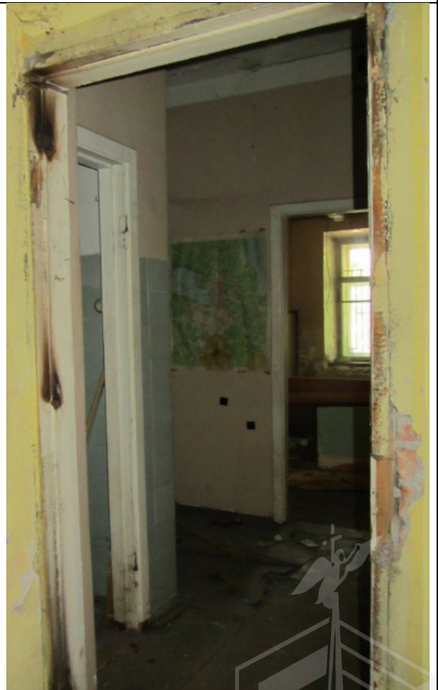
Фото 76. Состояние ч.п. 5 пом. 3С-Н (вид на проход в ч.п.6 и ч.п.7)
