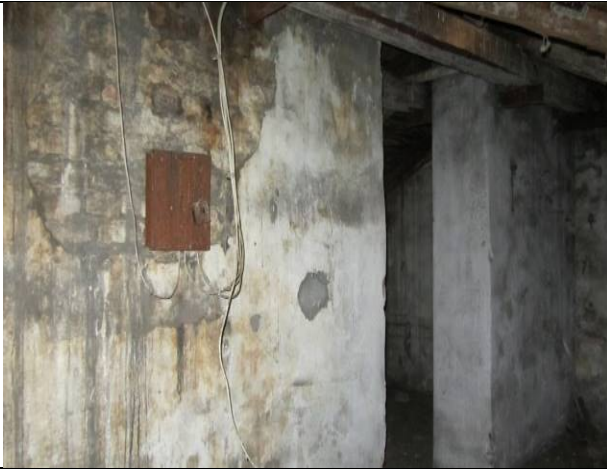
Фото 145. Состояние пом. 1 н.ч.
