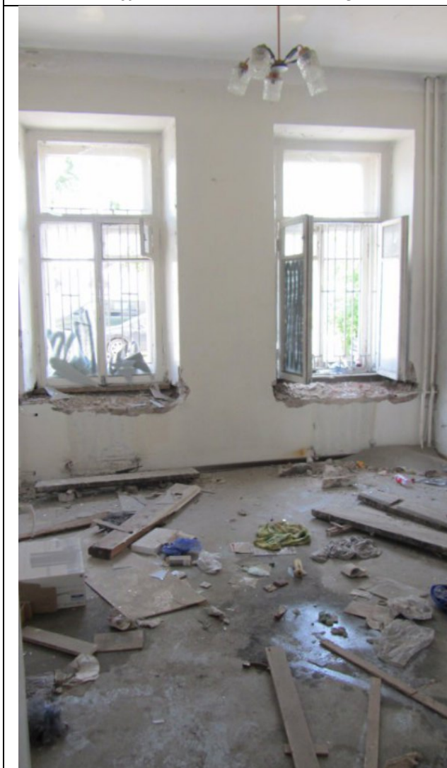
Фото 71. Состояние ч.п. 12 пом. 3С-Н
