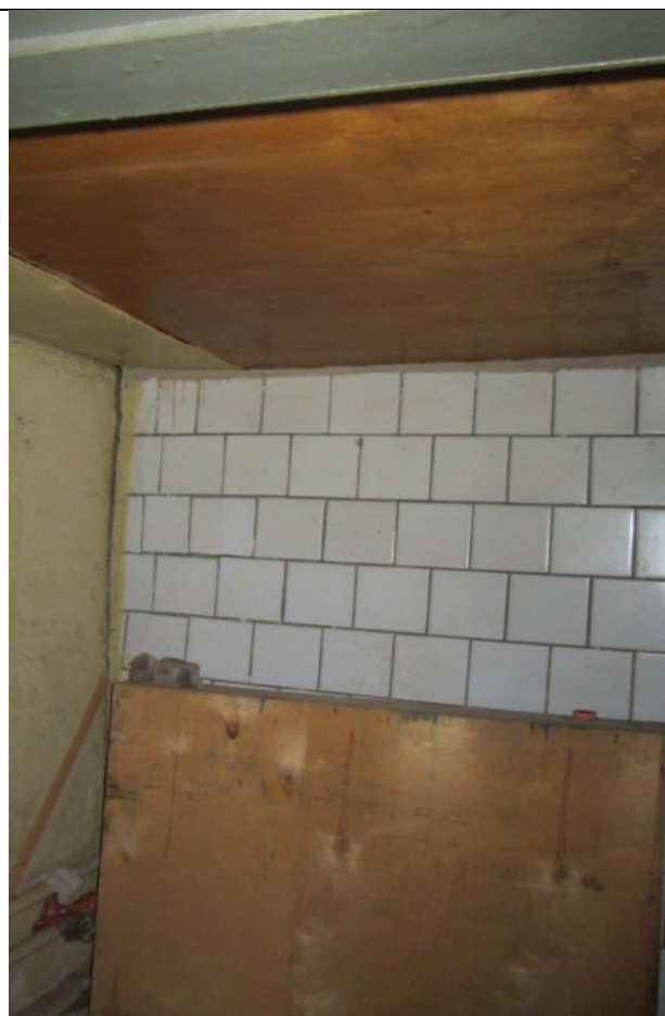
Фото 48. Состояние ч.п.2 пом. 4С-Н
