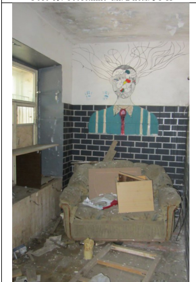
Фото 67. Состояние ч.п. 2 пом. 3С-Н
