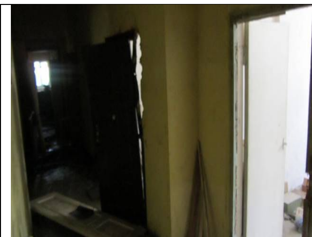
Фото 70. Состояние ч.п. 1 пом. 3С-Н
