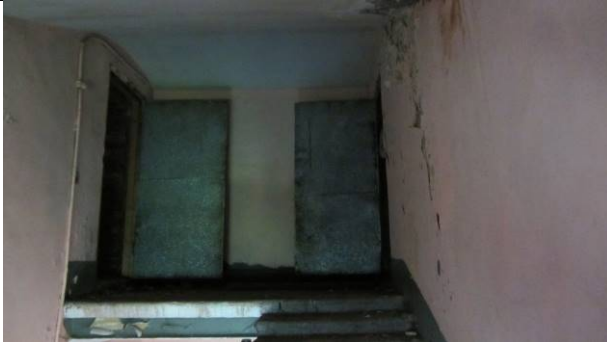
Фото 119. Вход на чердак помещения 1 н.ч. (с лестницы №2)
