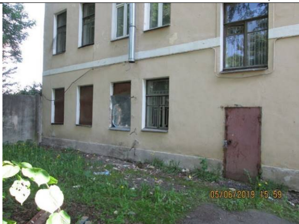
Фото 161. Общий вход в пом. 2-Н со двора
