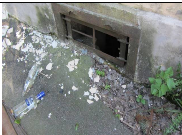
Фото 156. Окно пом. 1-Н, выходящее во двор
