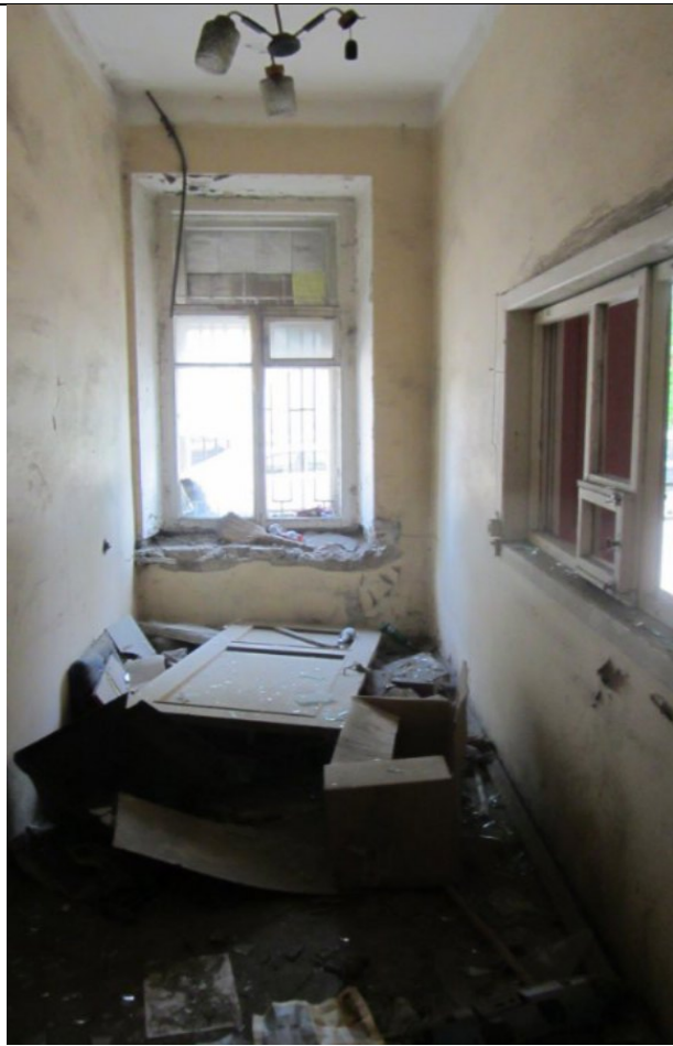
Фото 58. Состояние ч.п. 13 пом. 3С-Н
