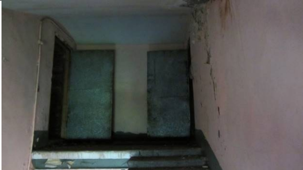
Фото 119. Вход на чердак помещение 1 н.ч. (с лестницы №2)
