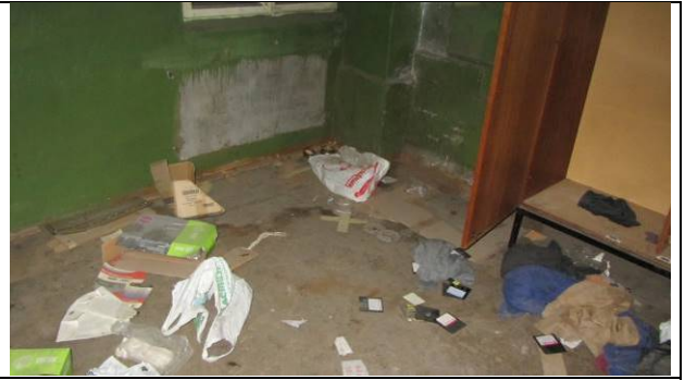
Фото 52. Состояние ч.п.3 пом. 4С-Н
