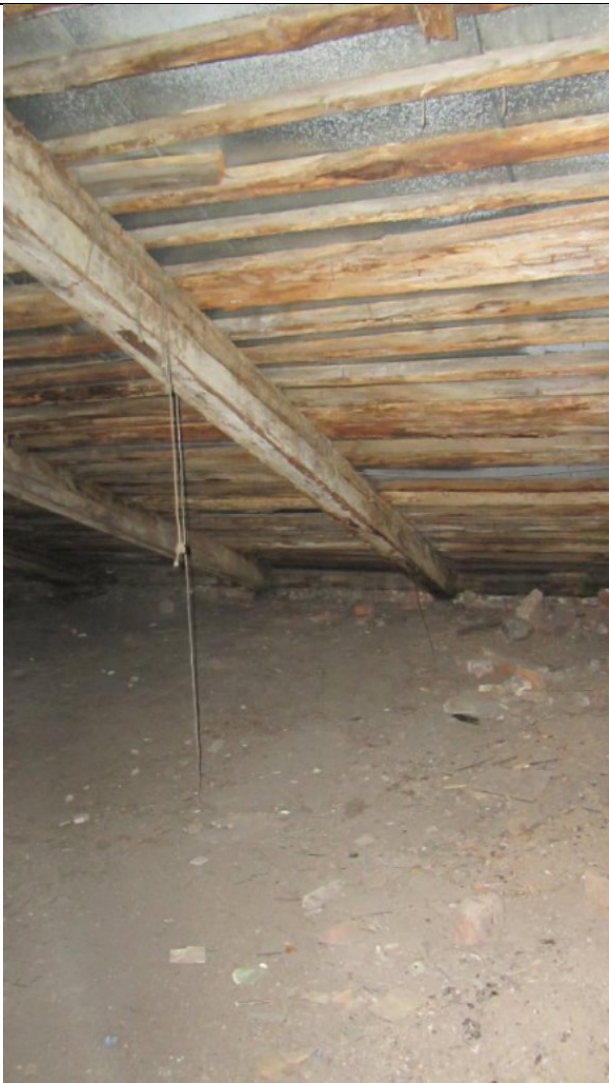
Фото 143. Состояние пом. 1 н.ч.
