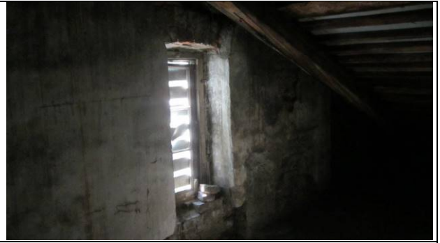
Фото 140. Состояние пом. 1 н.ч.
