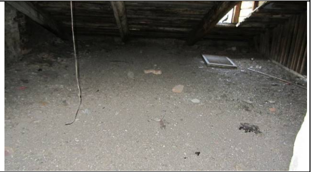
Фото 128. Состояние пом. 1 н.ч.
