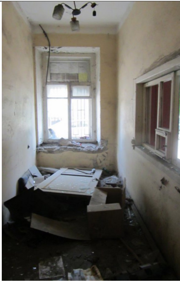
Фото 58. Состояние ч.п. 13 пом. 3С-Н
