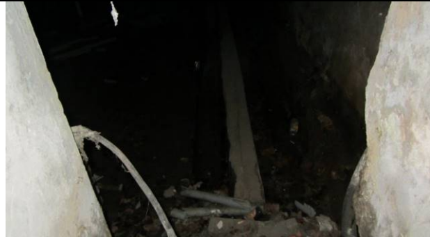
Фото 158. Состояние пом. 1-Н
