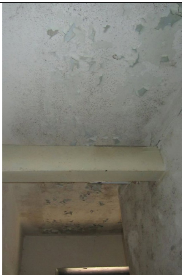
Фото 66. Состояние ч.п. 2 пом. 3С-Н
