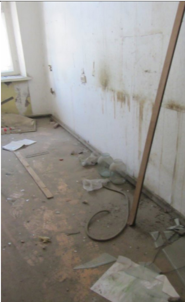
Фото 75. Состояние ч.п. 11 пом. 3С-Н
