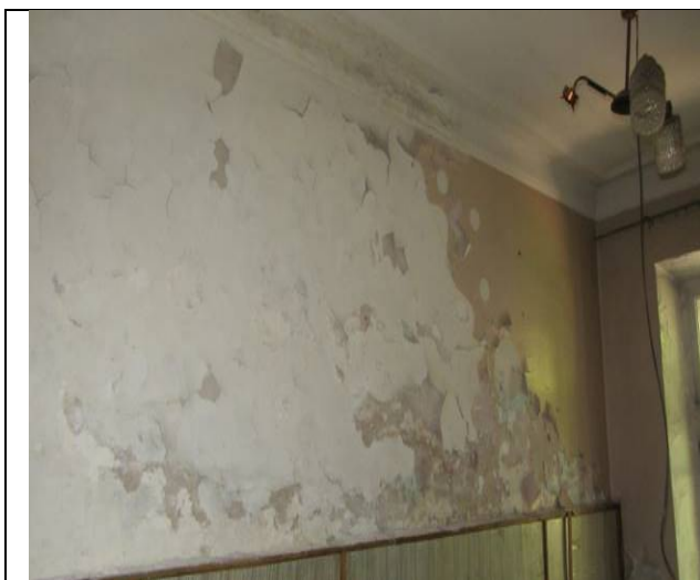
Фото 81. Состояние ч.п. 7 пом. 3С-Н
