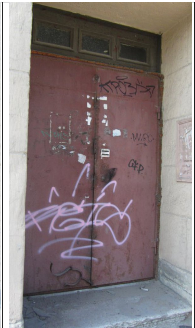
Фото 28. Вход на лестничную клетку №2
