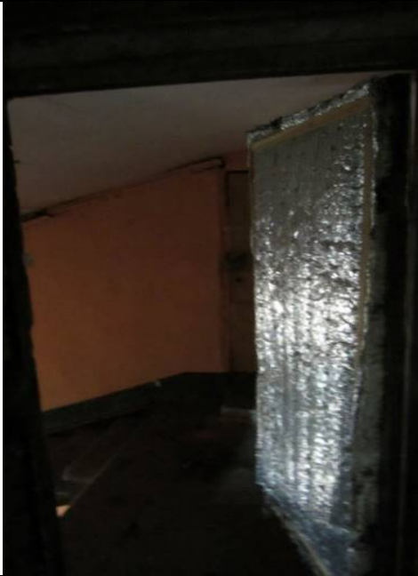
Фото 147. Выход на лестницу №1 из пом. 1 н.ч.
