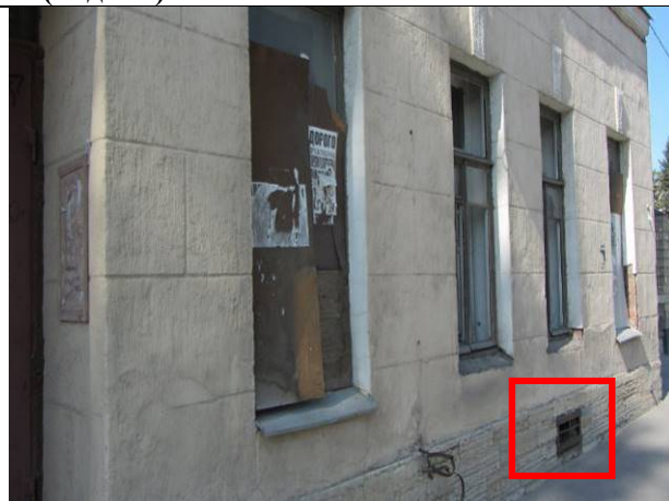
Фото 162. Окно пом. 2-Н, выходящее на улицу
