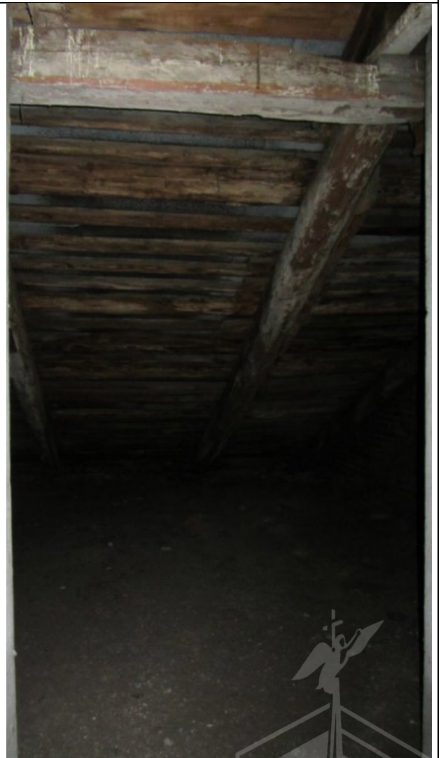
Фото 144. Состояние пом. 1 н.ч.
