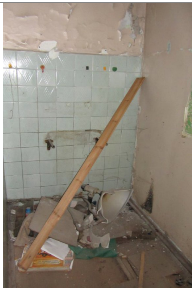
Фото 78. Состояние ч.п. 5 пом. 3С-Н
