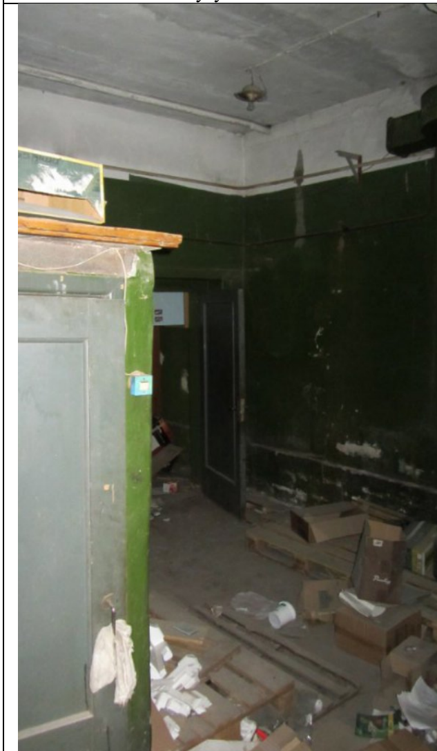
Фото 41. Состояние ч.п.1 пом. 4С-Н
