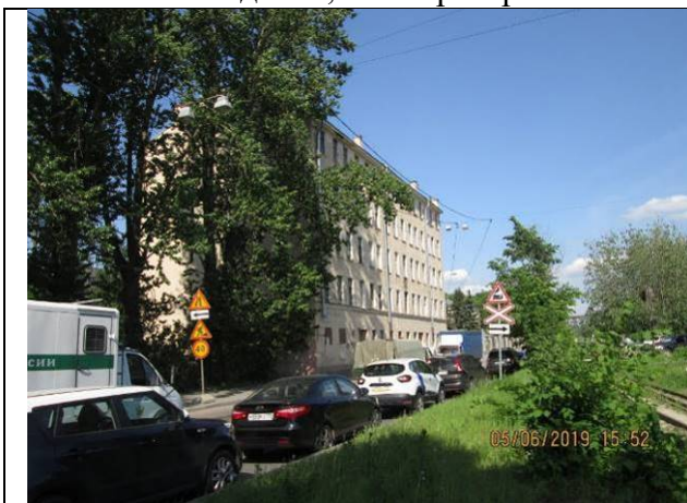
Фото 1. Вид на здание размещения Объекта оценки с Чугунной улице
