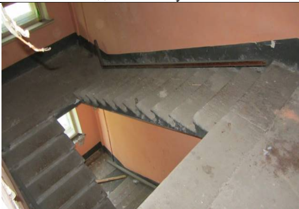
Фото 149. Подход к пом. 1 н.ч. с лестницы №1
