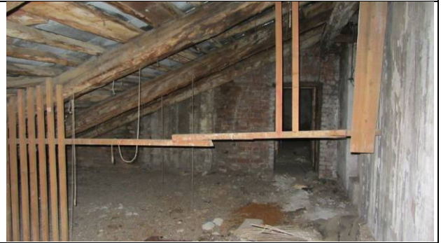
Фото 136. Состояние пом. 1 н.ч.
