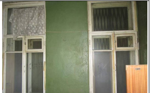
Фото 54. Состояние ч.п.3 пом. 4С-Н
