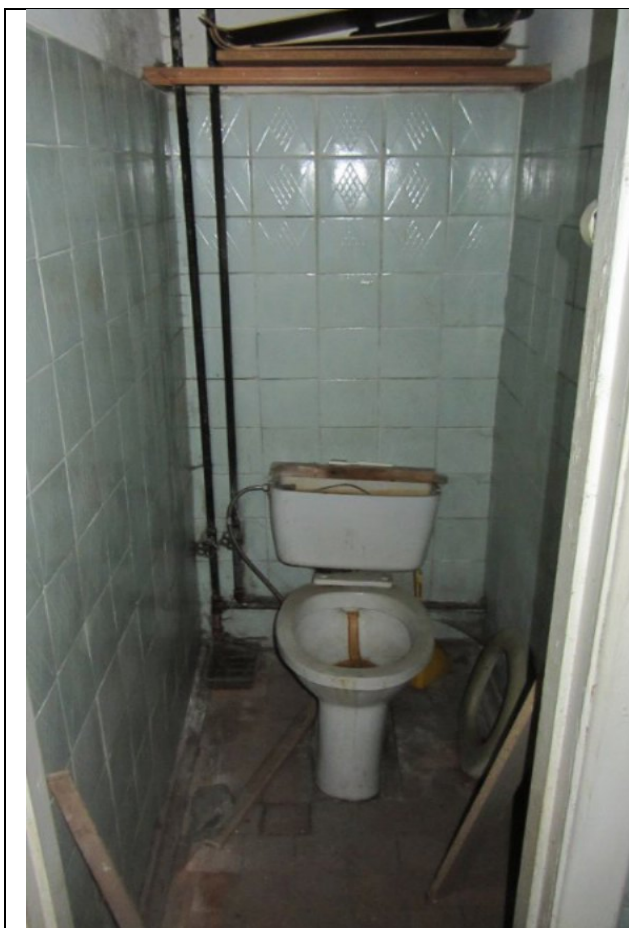
Фото 77. Состояние ч.п. 6 пом. 3С-Н
