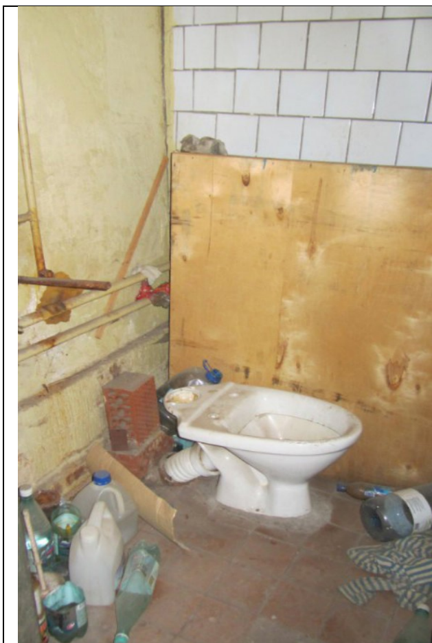
Фото 47. Состояние ч.п.2 пом. 4С-Н
