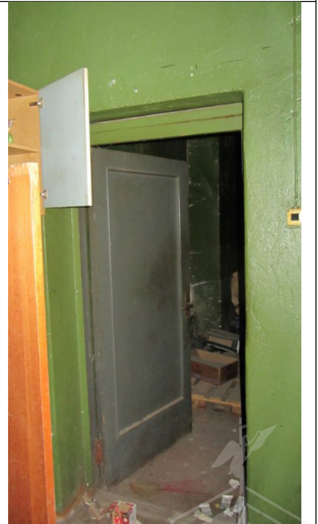
Фото 56. Состояние ч.п.3 пом. 4С-Н (вид на выход в ч.п. 1)
