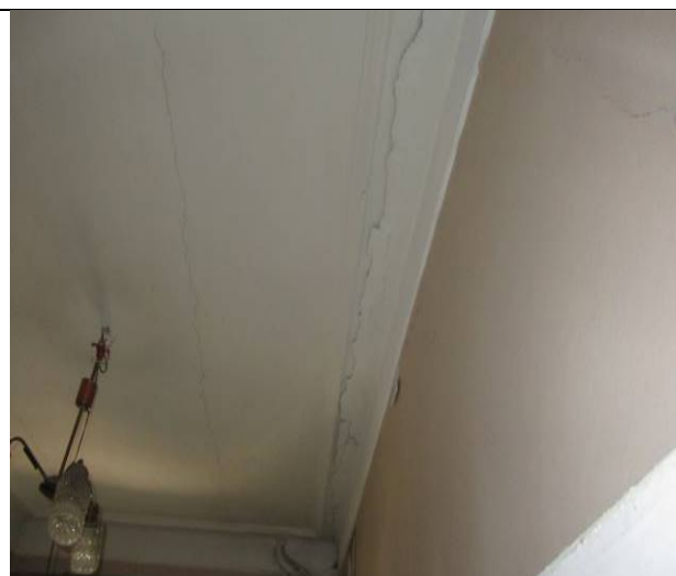
Фото 82. Состояние ч.п. 7 пом. 3С-Н
