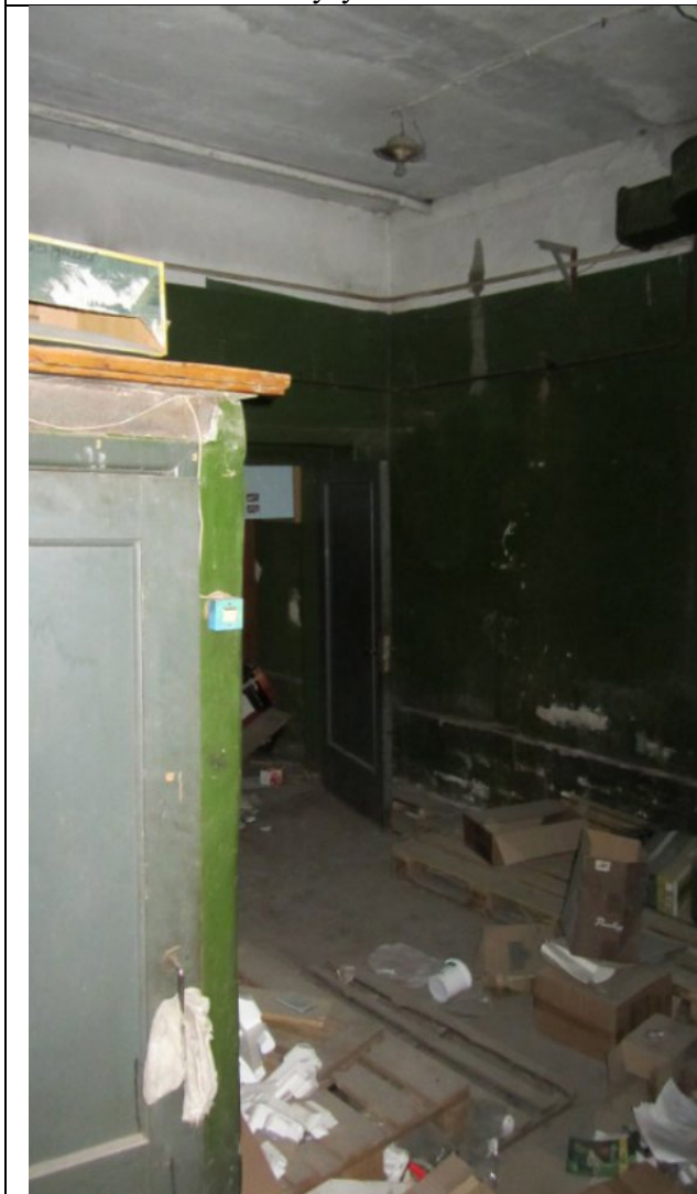
Фото 41. Состояние ч.п.1 пом. 4С-Н
