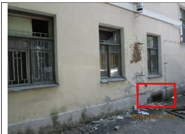
Фото 155. Окно пом. 1-Н, выходящее во двор
