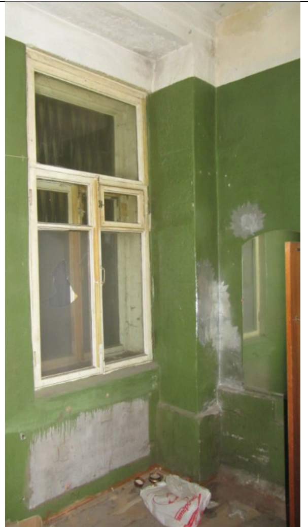
Фото 55. Состояние ч.п.3 пом. 4С-Н
