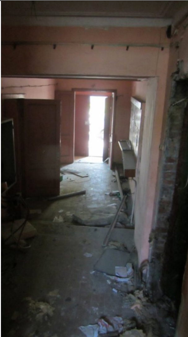
Фото 151. Подход к пом. 1 н.ч. с лестницы №1
