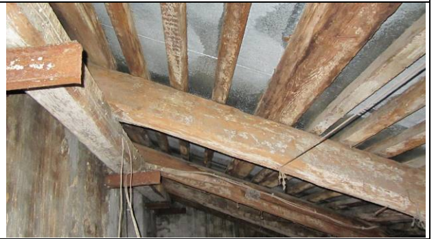
Фото 142. Состояние пом. 1 н.ч.
