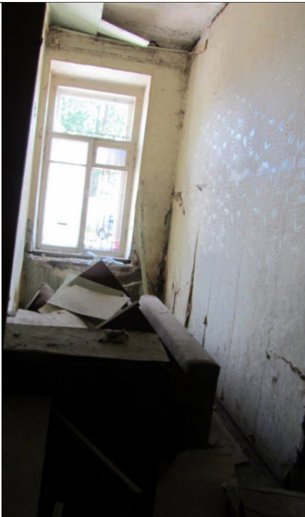
Фото 85. Состояние ч.п. 9 пом. 3С-Н
