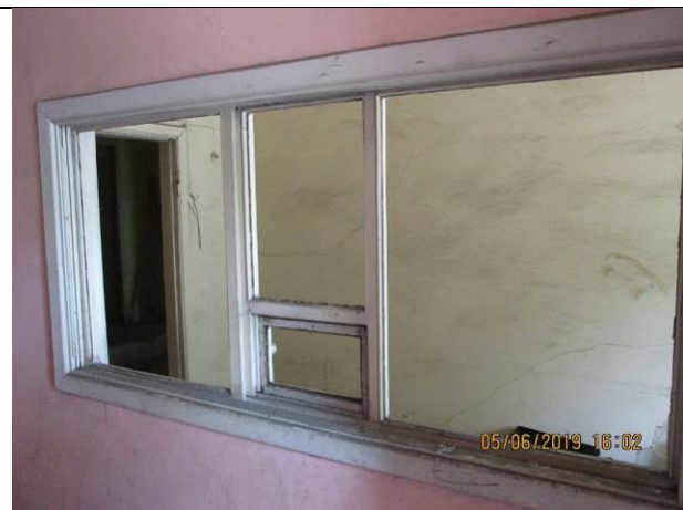
Фото 34. Состояние лестничной клетки №1
