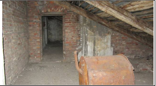
Фото 124. Состояние пом. 1 н.ч.
