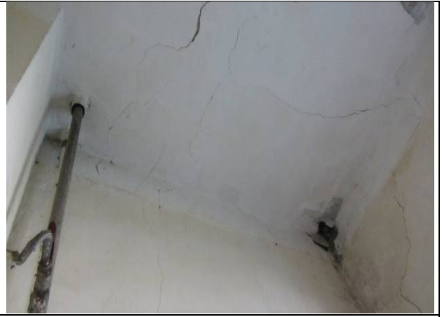
Фото 102. Состояние ч.п.3 пом. 2С-Н
