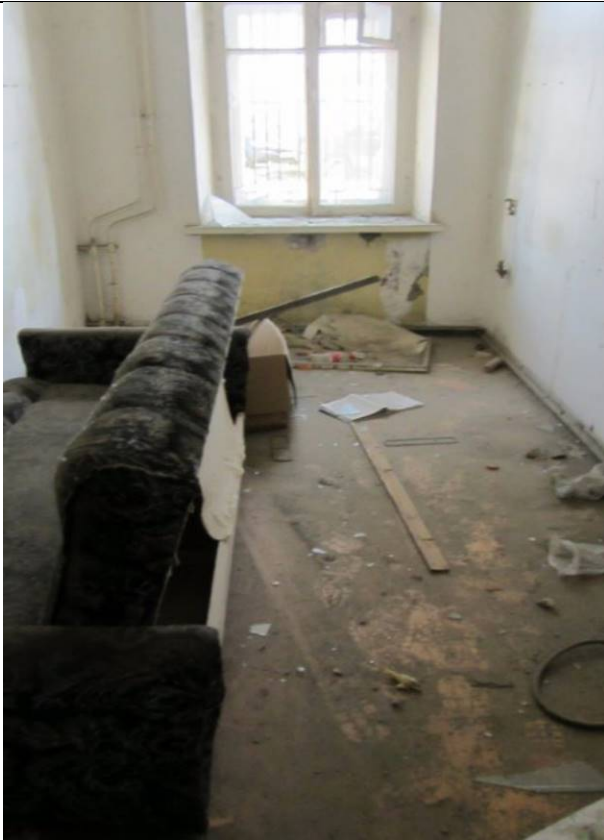
Фото 73. Состояние ч.п. 11 пом. 3С-Н
