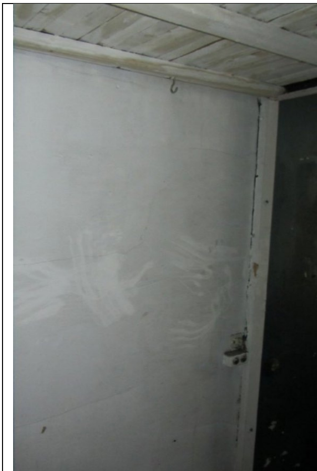
Фото 93. Состояние ч.п.6 пом. 2С-Н
