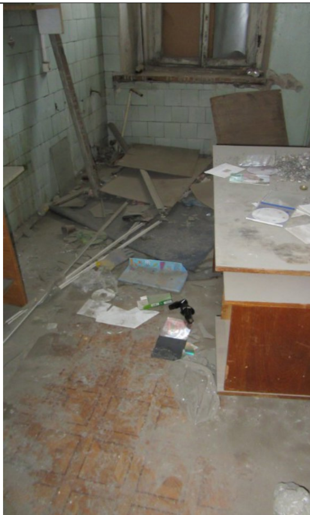
Фото 108. Состояние ч.п.4 пом. 2С-Н
