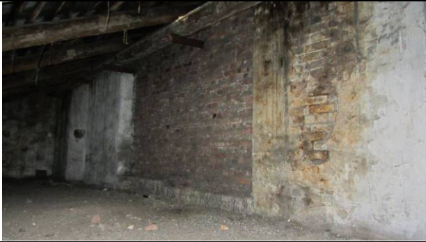
Фото 125. Состояние пом. 1 н.ч.
