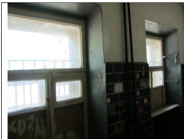
Фото 69. Состояние ч.п. 2 пом. 3С-Н
