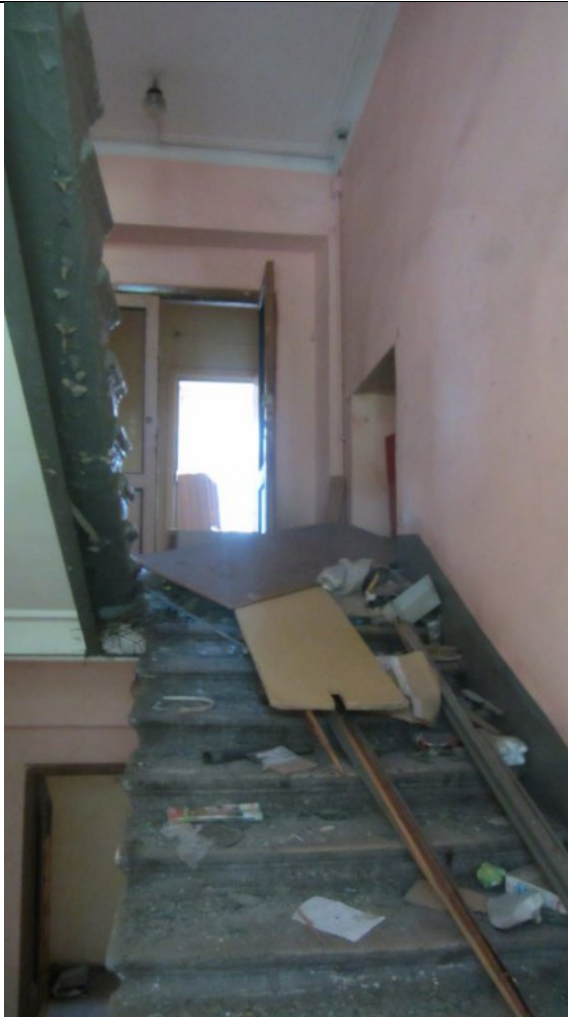
Фото 117. Подход к пом. 1 н.ч. по лестнице №2
