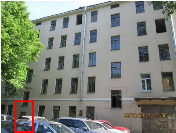
Фото 153. Подход ко входу в пом. 1-Н со двора
