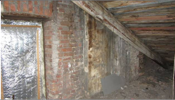
Фото 135. Состояние пом. 1 н.ч.
