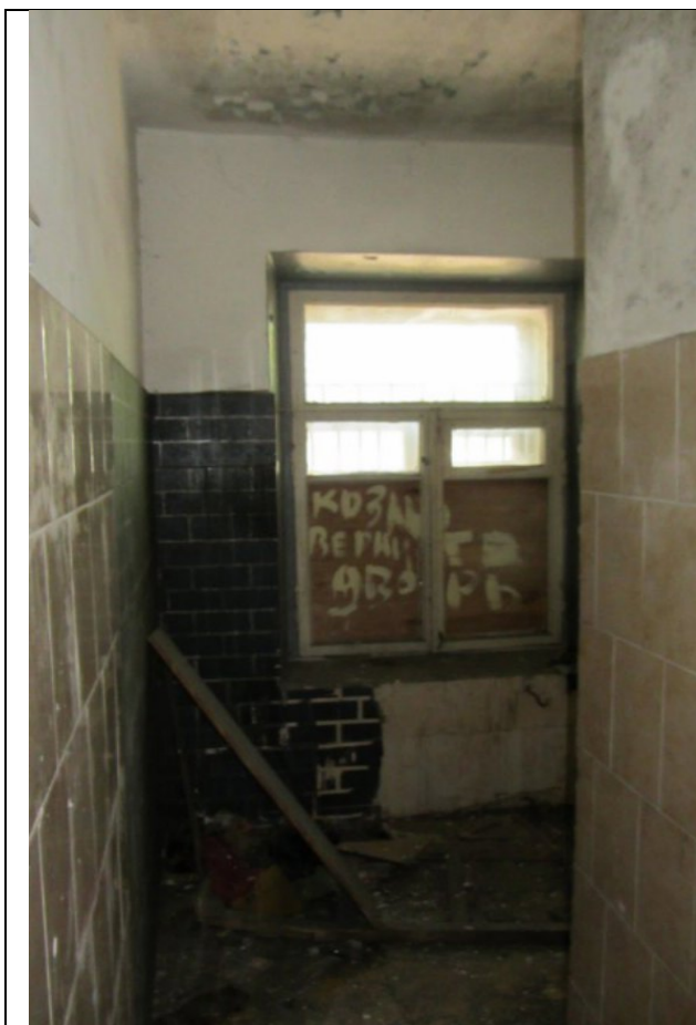
Фото 65. Состояние ч.п. 2 пом. 3С-Н
