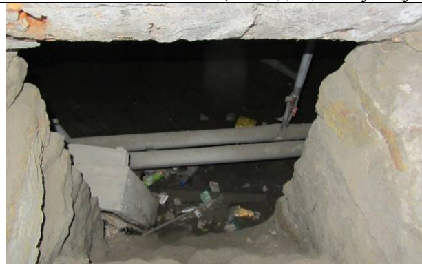
Фото 164. Окно пом. 2-Н, выходящее на улицу
