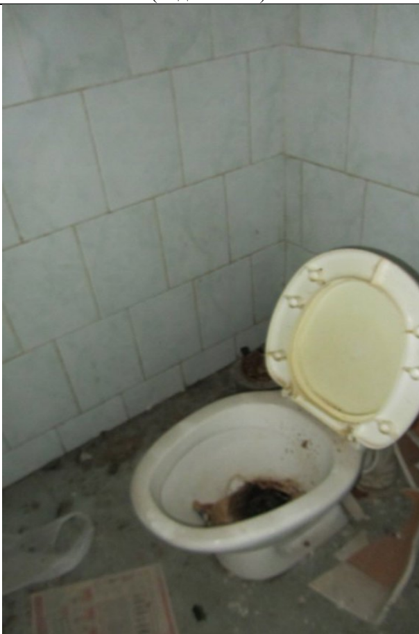
Фото 99. Состояние ч.п.2 пом. 2С-Н
