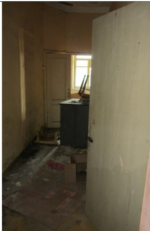
Фото 90. Вход в пом. 2С-Н (состояние ч.п.1)
