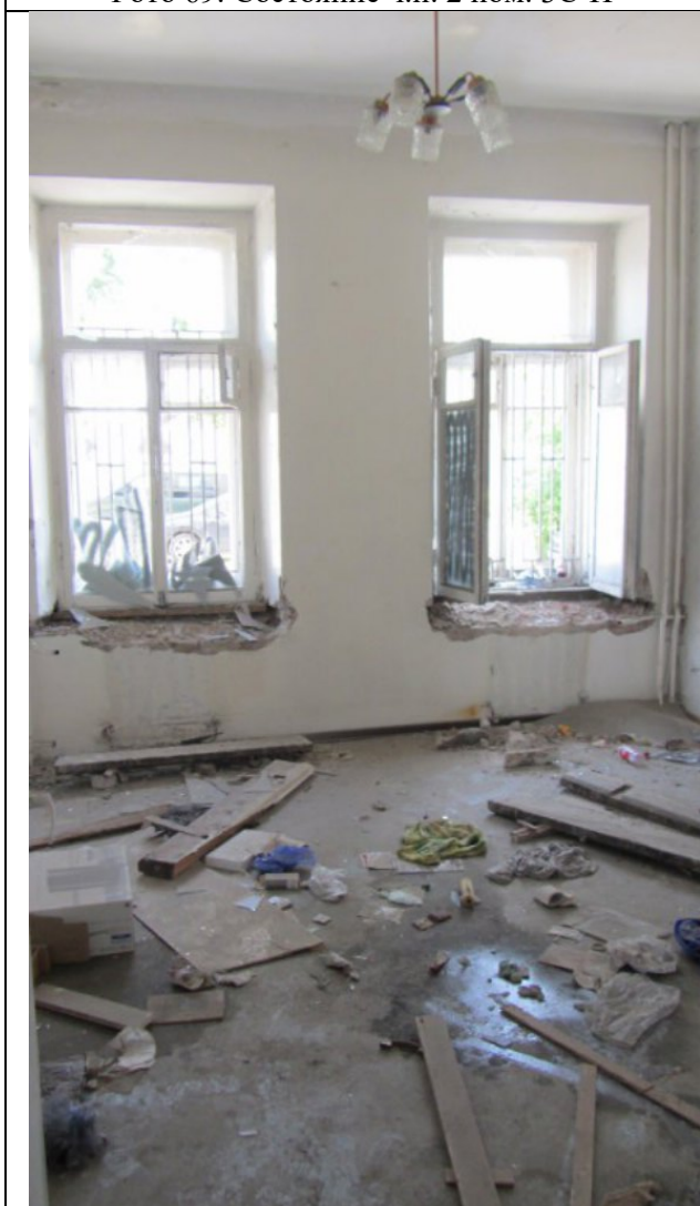
Фото 71. Состояние ч.п. 12 пом. 3С-Н
