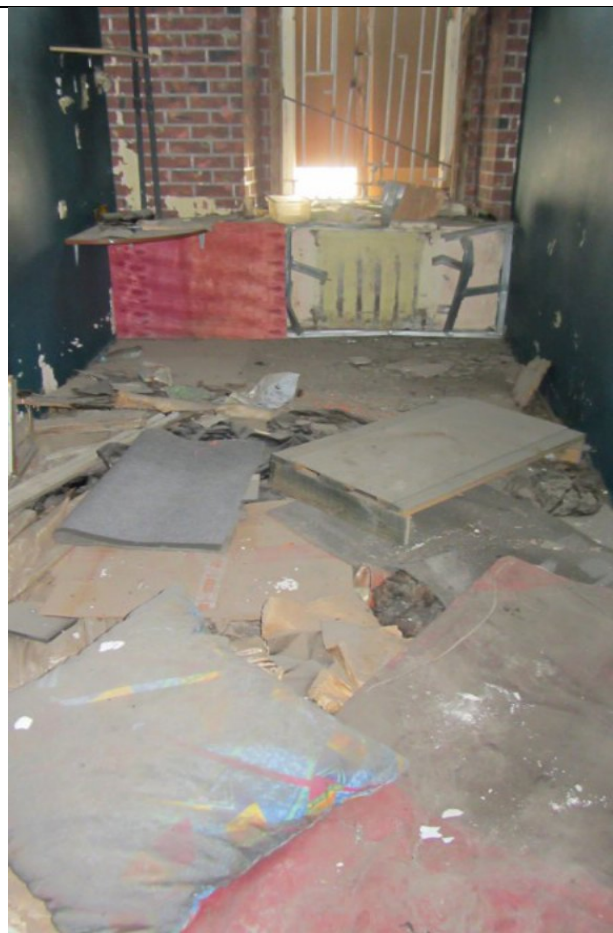
Фото 94. Состояние ч.п.6 пом. 2С-Н
