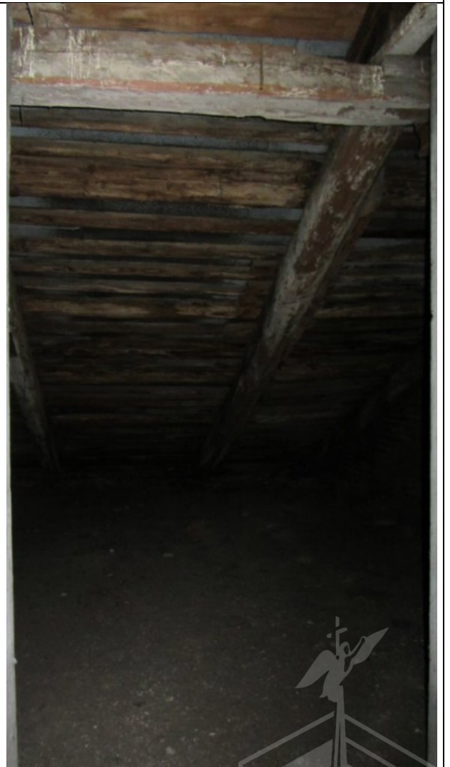
Фото 144. Состояние пом. 1 н.ч.
