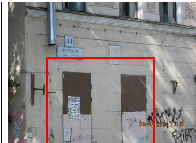
Фото 39. Окна пом. 4С-Н, выходящие на ул. Чугунная
