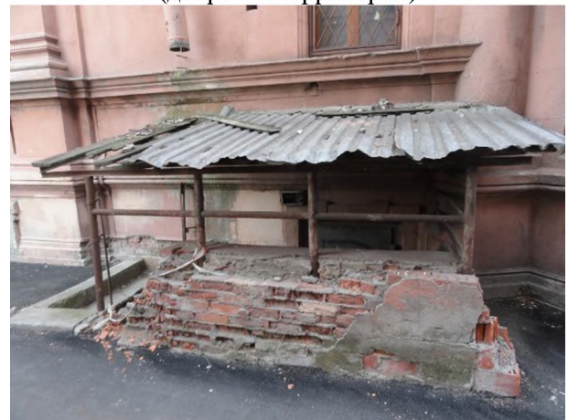
Фото 10. Вид отдельного входа со двора в подвал
