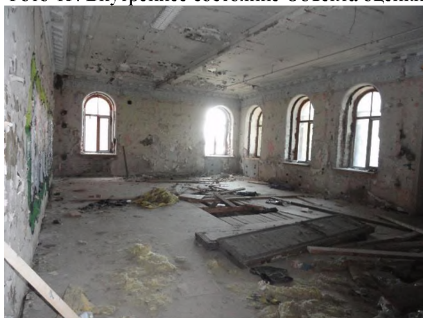
Фото 15. Внутреннее состояние Объекта оценки
