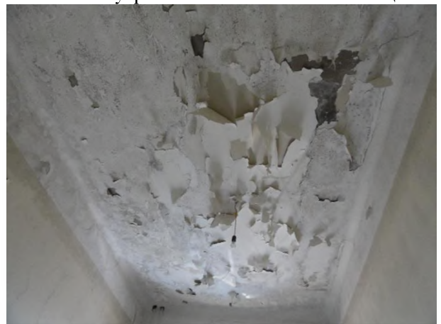
Фото 22. Внутреннее состояние Объекта оценки
