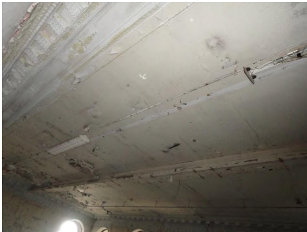
Фото 19. Внутреннее состояние Объекта оценки
