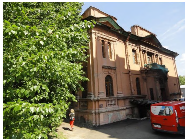
Фото 2. Общий вид оцениваемого здания со двора
