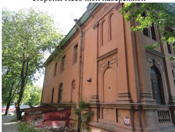
Фото 3. Общий вид оцениваемого здания со двора
