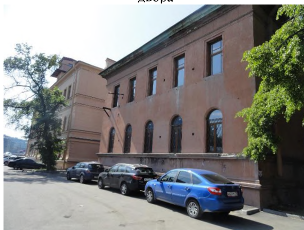
Фото 4. Общий вид оцениваемого здания со двора
