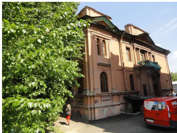
Фото 2. Общий вид оцениваемого здания со двора
