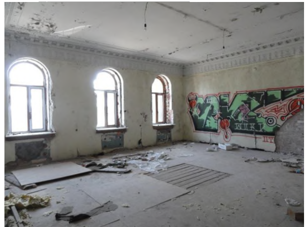
Фото 20. Внутреннее состояние Объекта оценки
