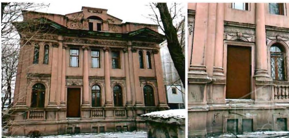
41, 42. Северо-западный фасад со стороны Песочной наб.
