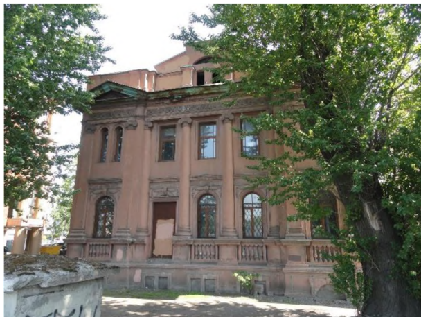
Фото 1. Общий вид оцениваемого здания со стороны Песочной набережной
