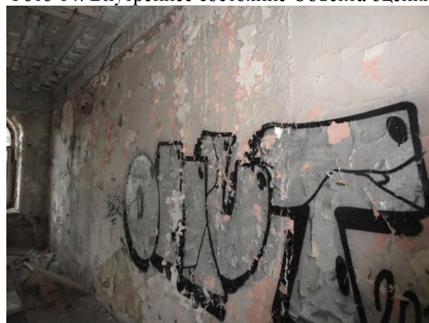
Фото 16. Внутреннее состояние Объекта оценки
