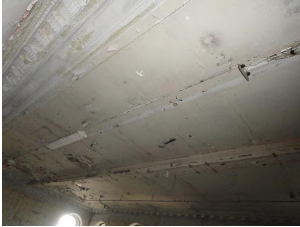
Фото 19. Внутреннее состояние Объекта оценки
