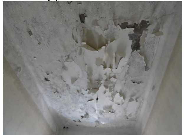
Фото 22. Внутреннее состояние Объекта оценки
