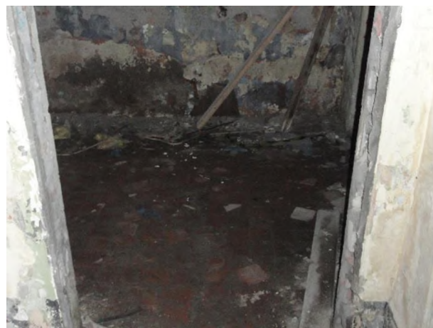
Фото 14. Внутреннее состояние Объекта оценки
