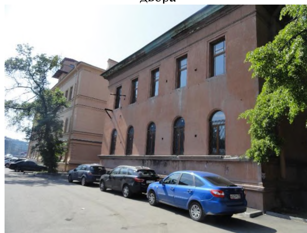
Фото 4. Общий вид оцениваемого здания со двора
