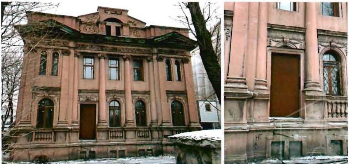
41, 42. Северо-западный фасад со стороны Песочной наб.
