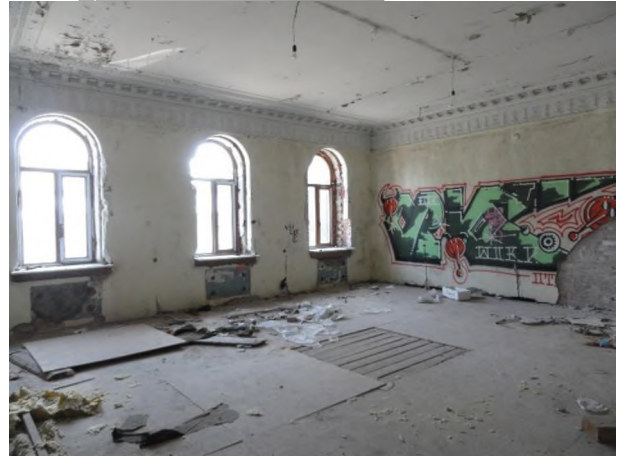
Фото 20. Внутреннее состояние Объекта оценки
