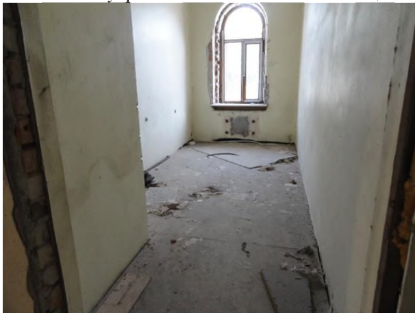
Фото 21. Внутреннее состояние Объекта оценки
