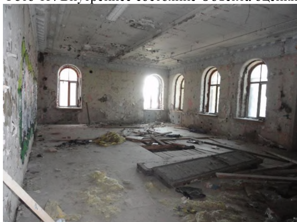
Фото 15. Внутреннее состояние Объекта оценки
