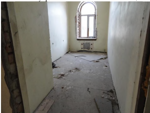
Фото 21. Внутреннее состояние Объекта оценки
