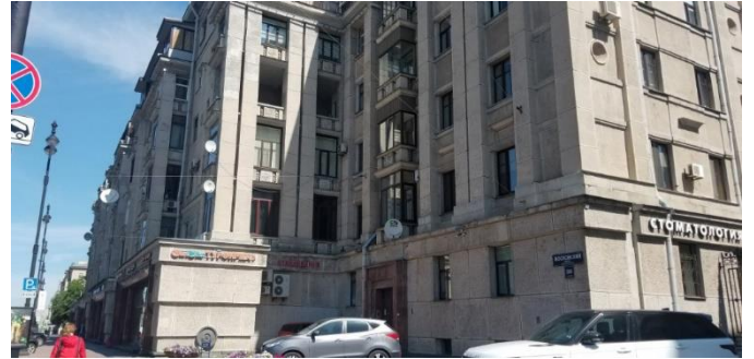
Фото 8 Здание размещения объекта оценки
