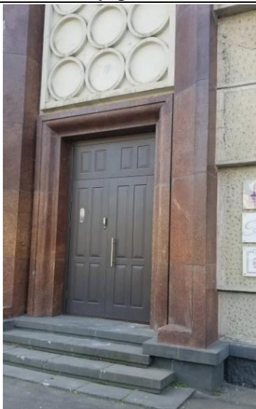
Фото 9 Общий вход в объект оценки с ул. Гастелло
