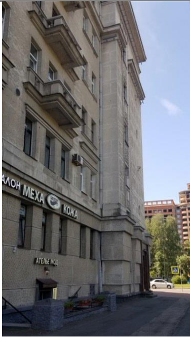
Фото 7 Здание размещения объекта оценки
