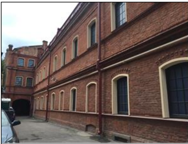
Фото 5. Ближайшее окружение и вид придомовой территории
