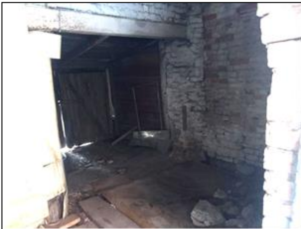
Фото 27. Общий вид оцениваемого помещения
