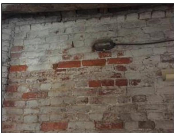
Фото 21. Общий вид оцениваемого помещения
