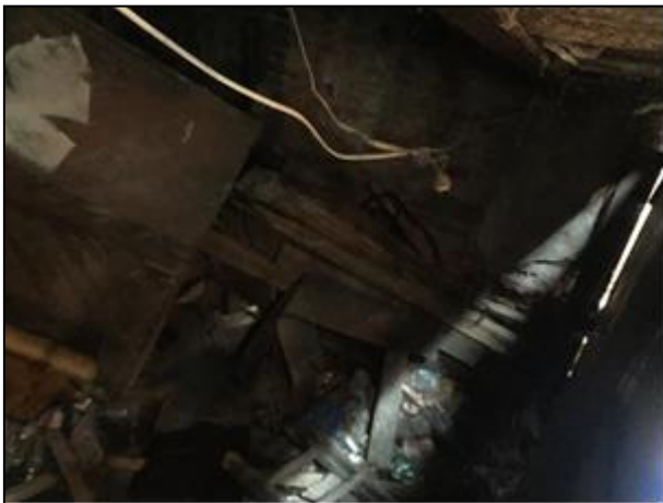
Фото 35. Общий вид оцениваемого помещения
