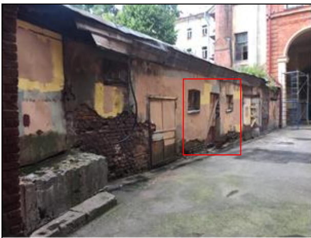
Фото 11. Отдельный вход со двора дома 82 по наб. р. Мойки (дверь) и 2 оконных проема, оборудованные и заложённые кирпичом
