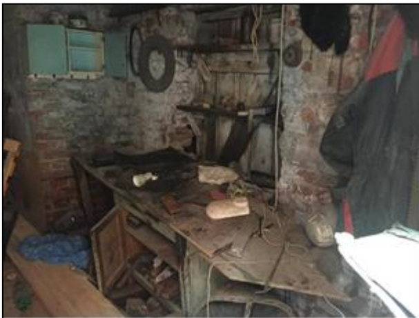
Фото 29. Общий вид оцениваемого помещения
