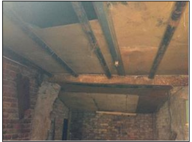
Фото 32. Общий вид оцениваемого помещения
