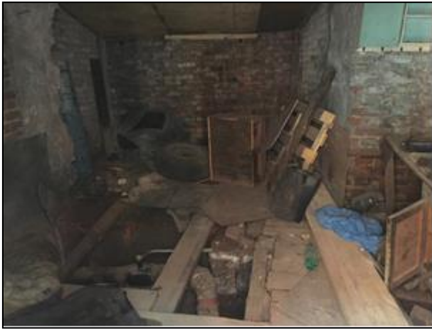
Фото 31. Общий вид оцениваемого помещения
