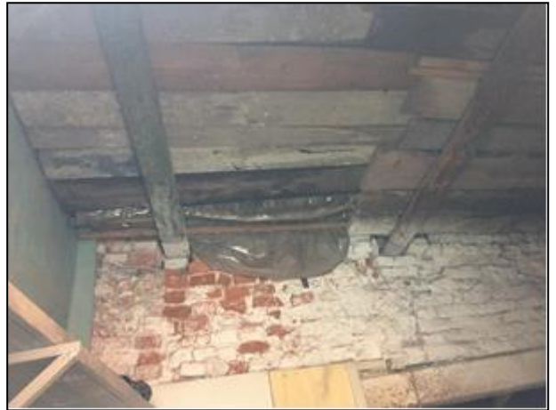
Фото 26. Общий вид оцениваемого помещения
