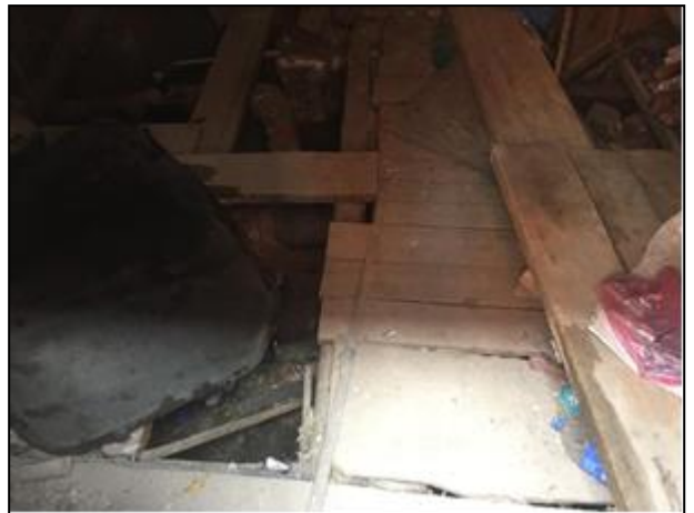
Фото 34. Общий вид оцениваемого помещения
