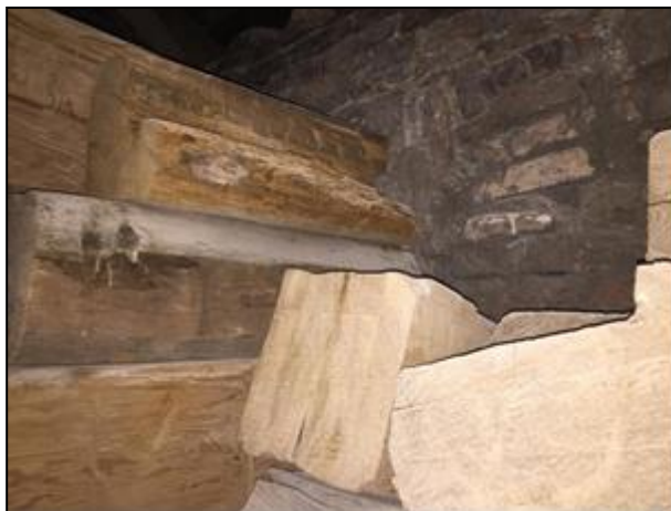
Фото 38. Общий вид оцениваемого помещения (дверной проем, заложенный бревнами)
