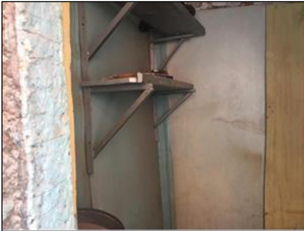
Фото 25. Общий вид оцениваемого помещения
