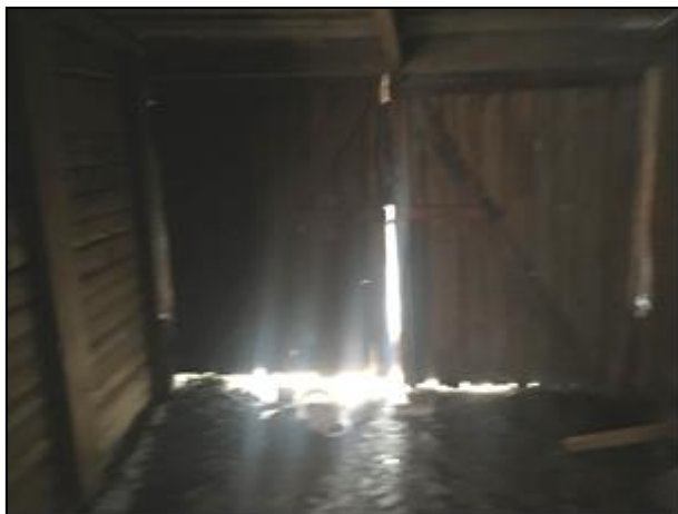
Фото 19. Общий вид оцениваемого помещения
