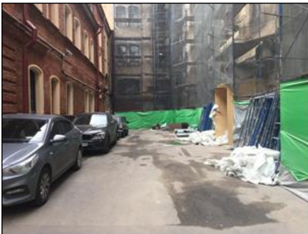
Фото 7. Ближайшее окружение и вид придомовой территории
