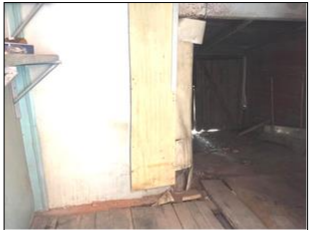
Фото 28. Общий вид оцениваемого помещения
