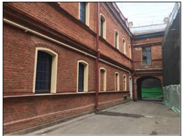
Фото 6. Ближайшее окружение и вид придомовой территории
