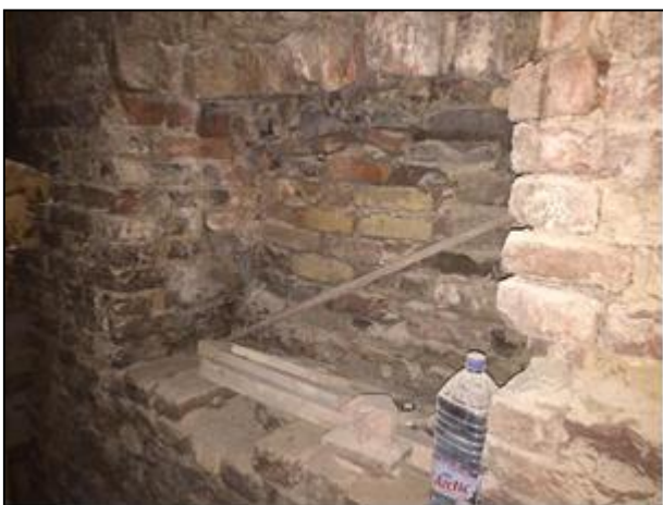
Фото 39. Общий вид оцениваемого помещения (оконный проем, заложенный кирпичом)
