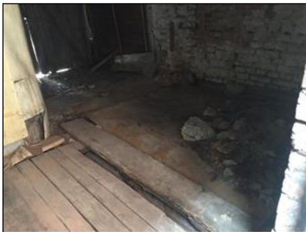
Фото 23. Общий вид оцениваемого помещения
