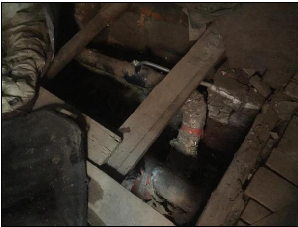
Фото 33. Общий вид оцениваемого помещения
