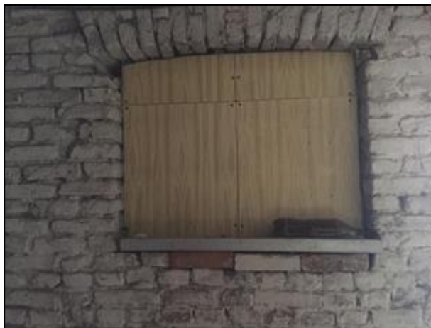
Фото 20. Общий вид оцениваемого помещения
