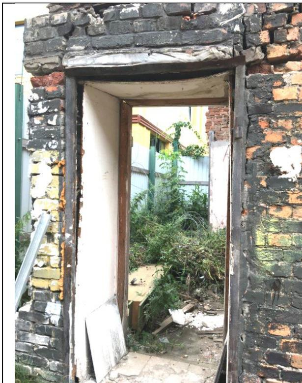
Фото 1. Вход в ч. п. №1 (разрушено: отсутствуют наружная и задняя стенки, кровля утрачена)
