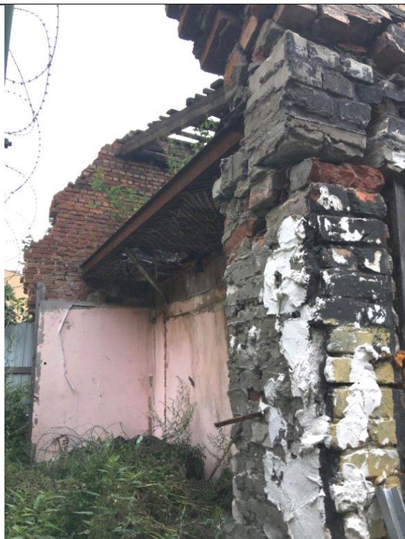
Фото 2. Ч. п. №1 (разрушено: отсутствуют наружная и задняя стенки, кровля утрачена)
