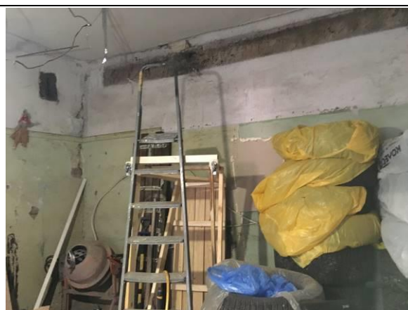
Фото 4. Внутреннее состояние. Единое пространство
