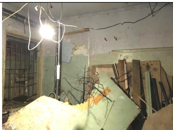
Фото 3. Внутреннее состояние. Единое пространство
