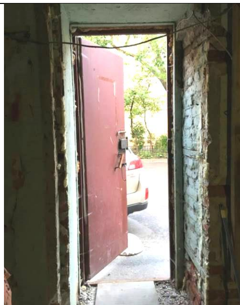
Фото 2. Входная дверь. Вид изнутри
