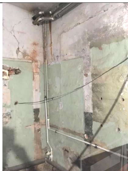
Фото 6. Замена системы отопления
