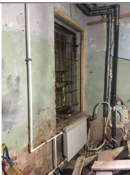
Фото 5. Замена системы отопления
