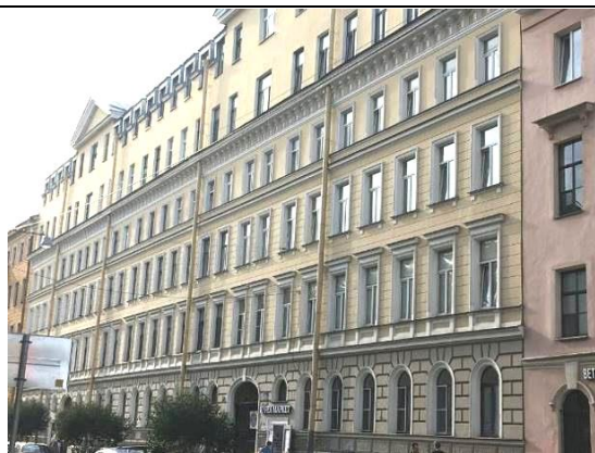
Фото 3. Вид на фасад здания размещения Объекта оценки
