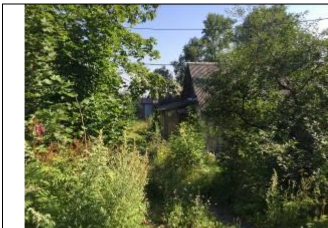
Фото 1. Вид на здание размещения Объекта оценки с Морской улицы.
