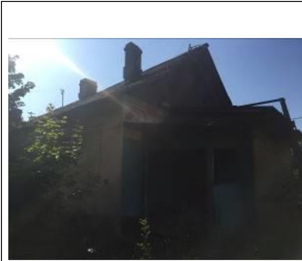
Фото 5. Вид на здание размещения Объекта оценки.
