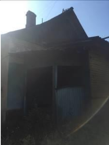
Фото 7. Состояние Объекта оценки.
