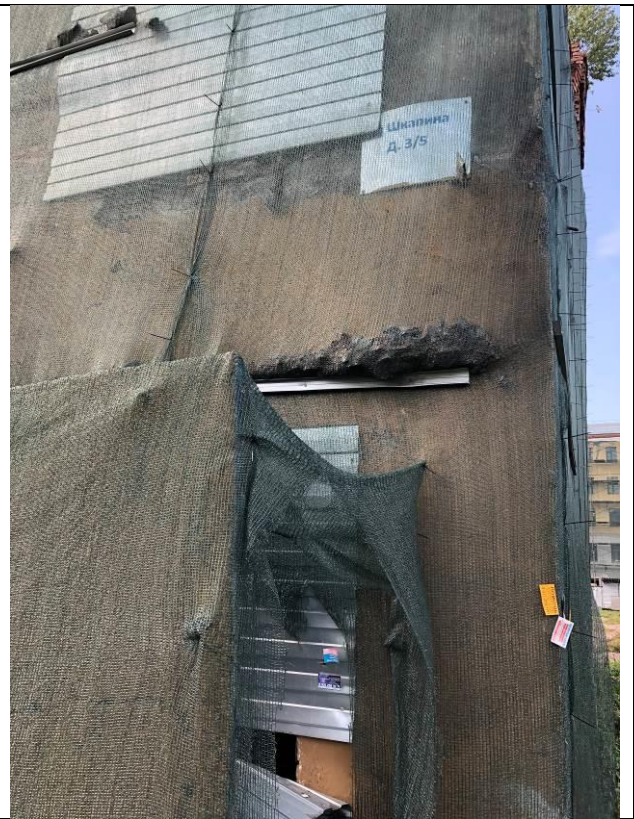
Фото 8. Вход в объект оценки.
