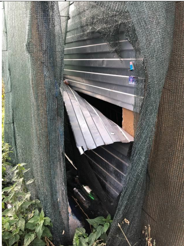
Фото 9. Вход в объект оценки.
