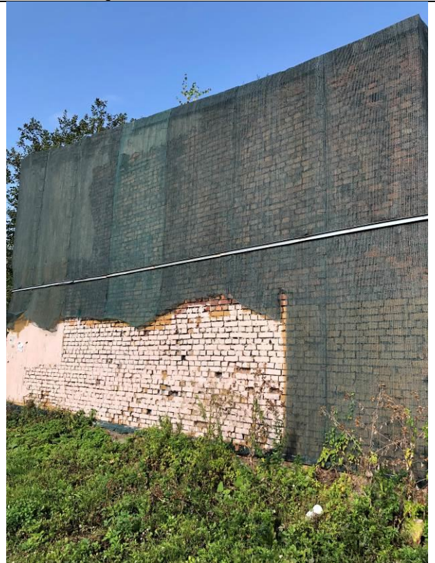
Фото 14. Общий вид здания размещения объекта оценки.
