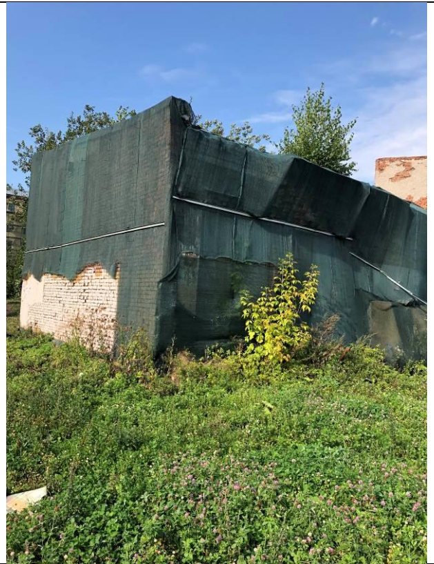
Фото 12. Состояние пристройки к зданию размещения объекта оценки
