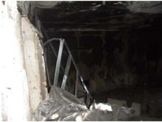
Фото 15. Внутреннее состояние помещения (ч.п. 1)
