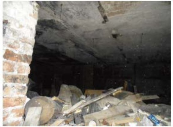
Фото 16. Внутреннее состояние помещения (ч.п. 1)
