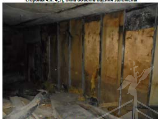
Фото 14. Внутреннее состояние помещения (ч.п. 1)
