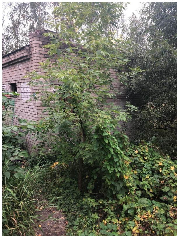
Фото 2. Общий вид Объекта оценки
