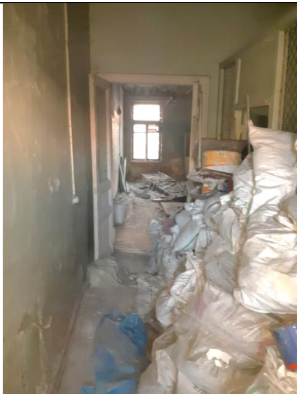
Фото 1. Состояние внутренней отделки помещений Объекта оценки
