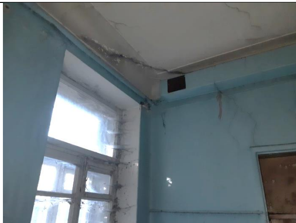
Фото 4. Состояние внутренней отделки помещений Объекта оценки
