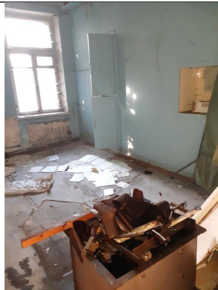
Фото 2. Состояние внутренней отделки помещений Объекта оценки
