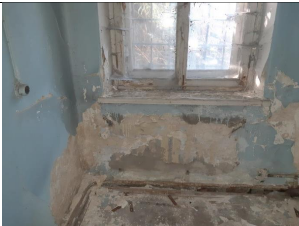
Фото 3. Состояние внутренней отделки помещений Объекта оценки
