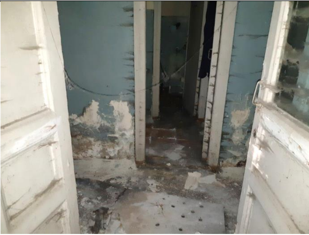
Фото 7. Состояние внутренней отделки помещений Объекта оценки
