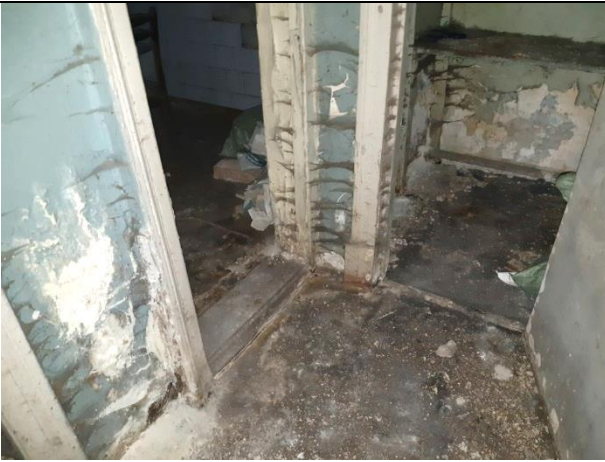
Фото 9. Состояние внутренней отделки помещений Объекта оценки
