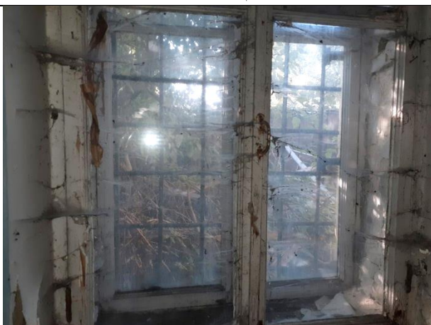
Фото 5. Состояние внутренней отделки помещений Объекта оценки
