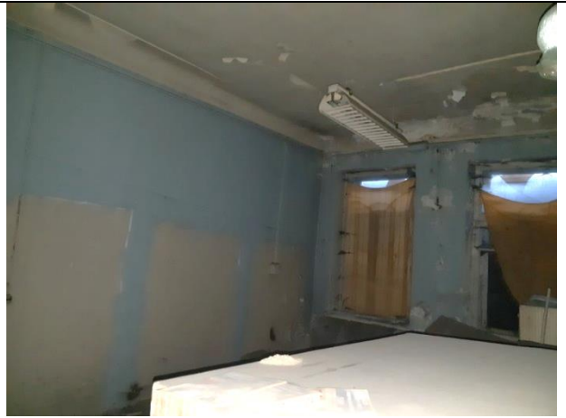
Фото 10. Состояние внутренней отделки помещений Объекта оценки
