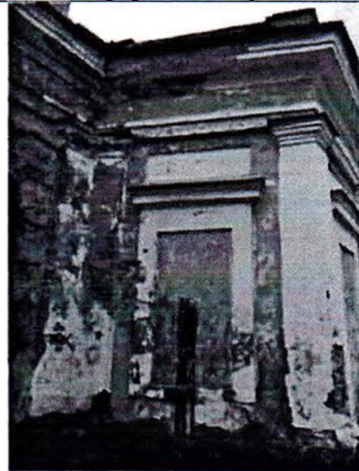
6. Фрагмент северо-восточного фасада
