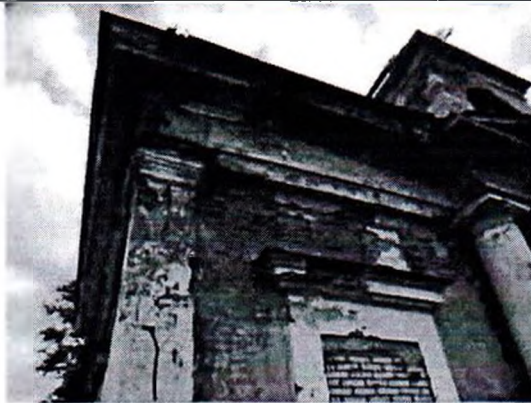
7. Фрагмент юго-западного фасада
