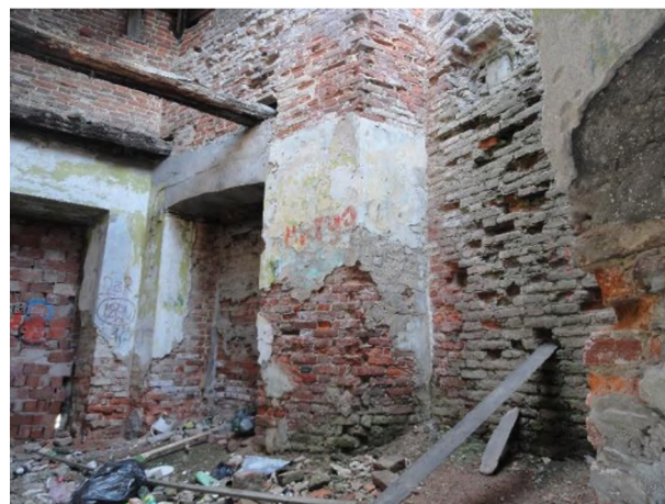
Фото 16. Внутреннее состояние Объекта оценки
