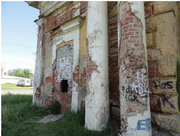
Фото 7. Состояние основных конструктивных элементов, заложенный вход
