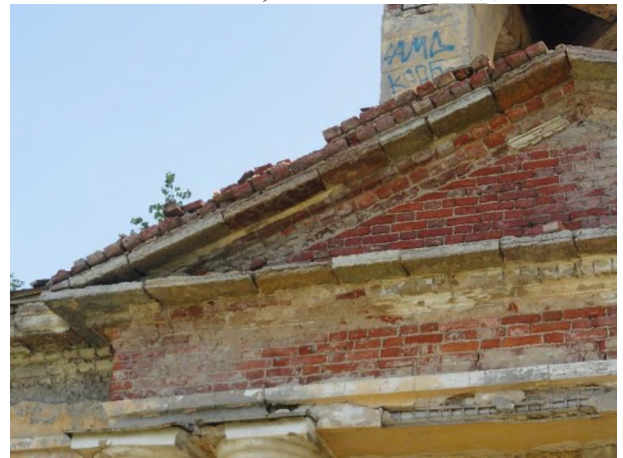
Фото 10. Состояние основных конструктивных элементов
