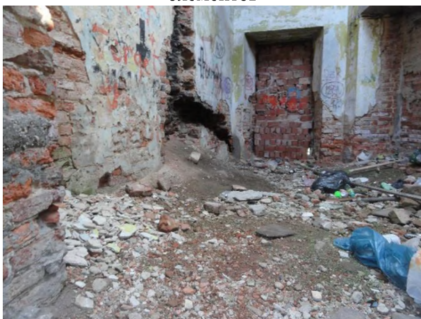
Фото 15. Внутреннее состояние Объекта оценки
