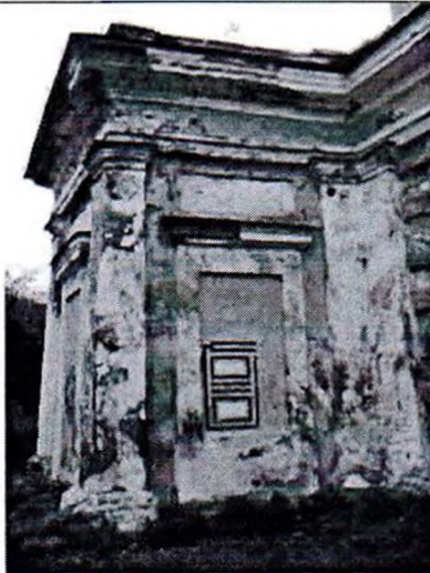
5. Фрагмент северо-восточного фасада
