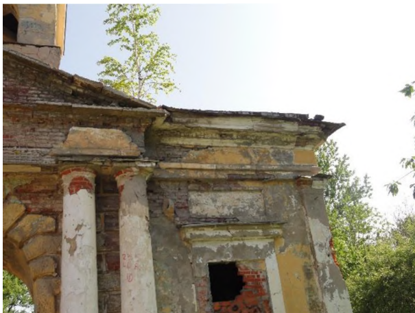
Фото 11. Состояние основных конструктивных элементов
