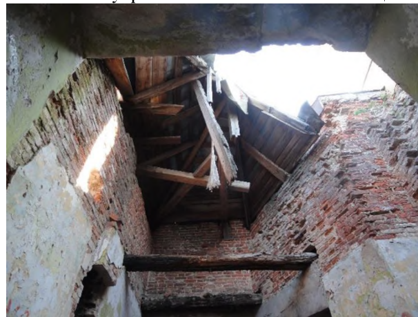
Фото 18. Внутреннее состояние Объекта оценки
