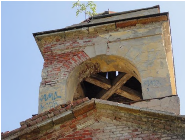
Фото 9. Состояние основных конструктивных элементов
