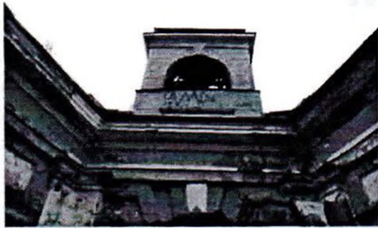
3. Фрагмент северо-восточного фасада
