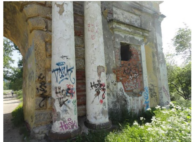
Фото 8. Состояние основных конструктивных элементов, заложенный вход
