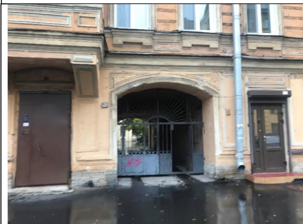
Фото 5. Арка, через которую осуществляется проход к Объекту оценки (с Тверской улицы).
