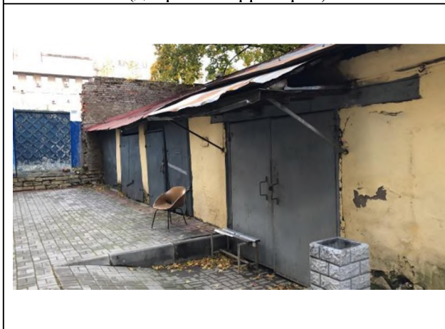
Фото 9. Здание размещения Объекта оценки.
