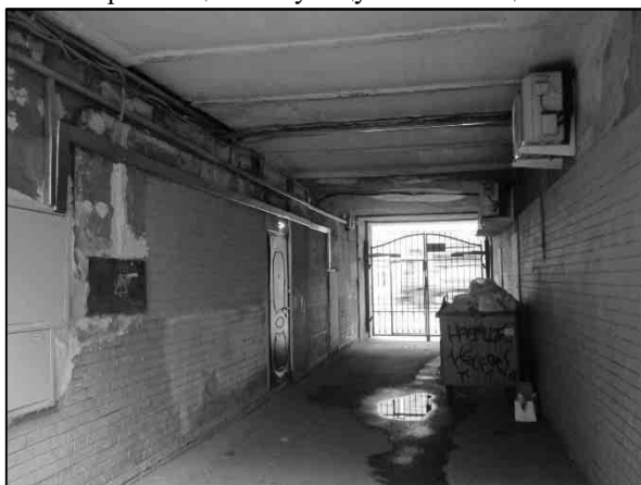
Фото 9. Вид арки с отдельным входом со двора в Объект оценки
