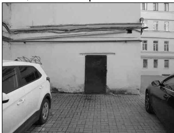
Фото 8. Доступ в здание (вход в соседние помещения)
