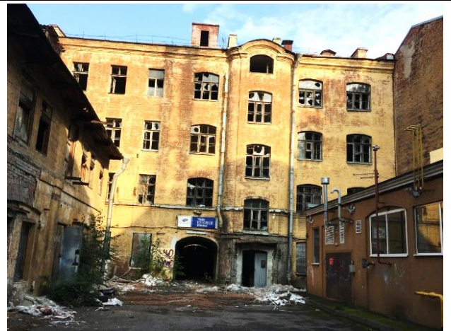
Фото 8. Фасад здания лит. Б, 2-й двор
