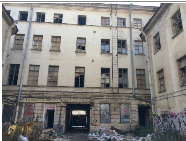
Фото 4. Вид на фасад здания лит. А д. 26 по наб. р. Мойки, 1-й двор
