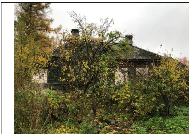
Фото 1. Вид на здание размещения Объекта оценки, с ул. Некрасова
