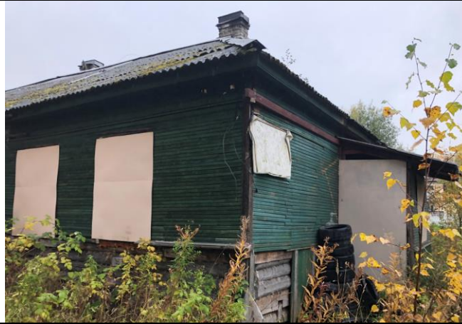
Фото 3. Вид на здание размещения Объекта оценки.
