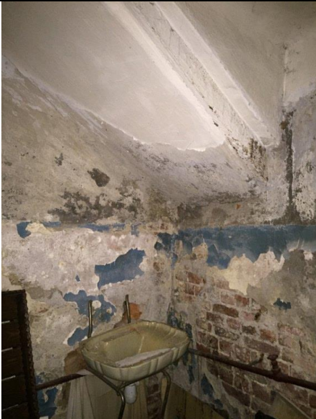
Фото 21. Состояние ч.п. 1 Объекта оценки.
