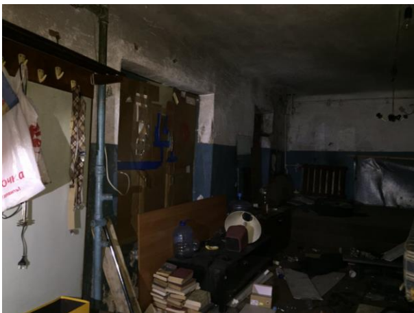
Фото 23. Состояние ч.п. 1 Объекта оценки.
