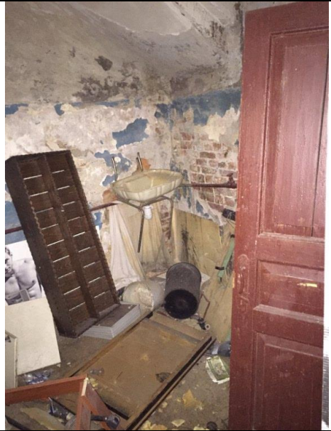
Фото 20. Состояние ч.п. 1 Объекта оценки.
