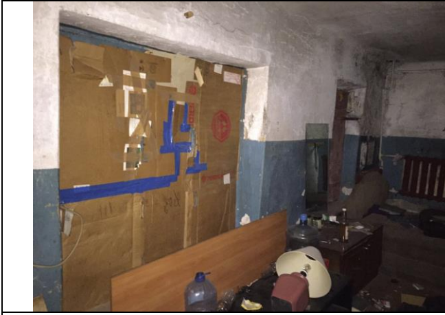
Фото 25. Состояние ч.п. 1 Объекта оценки.
