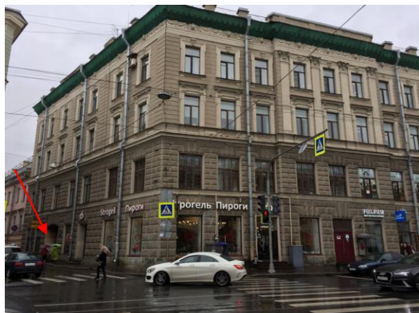
Фото 1. Вид на здание расположения Объекта оценки (арка с воротами для прохода/въезда во двор).
