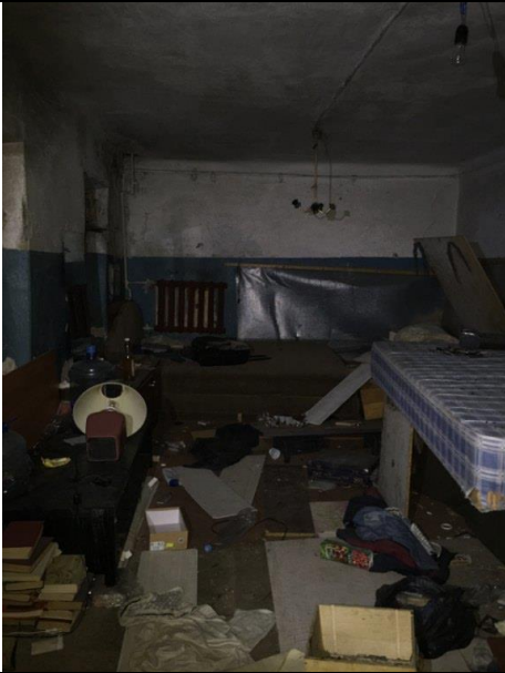
Фото 19. Состояние ч.п. 1 Объекта оценки.
