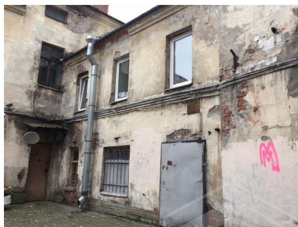
Фото 12. Вид на часть здания расположения Объекта оценки со двора, вход и окна Объекта
