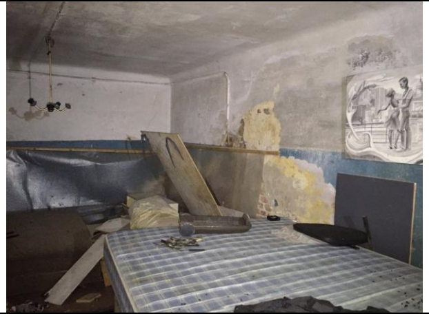
Фото 26. Состояние ч.п. 1 Объекта оценки.
