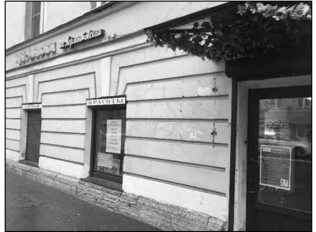
Фото 6. Объекты локального окружения (коммерческие помещения) цокольного этажа родительского объекта оцениваемого помещения
