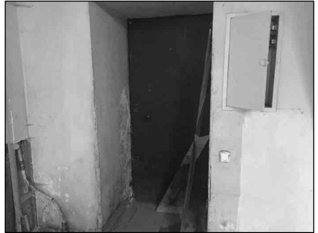
Фото 18. Общий вход со двора (из арки) – закрыт металлической дверью (вид со стороны оцениваемого помещения, из ч.п. 2)
