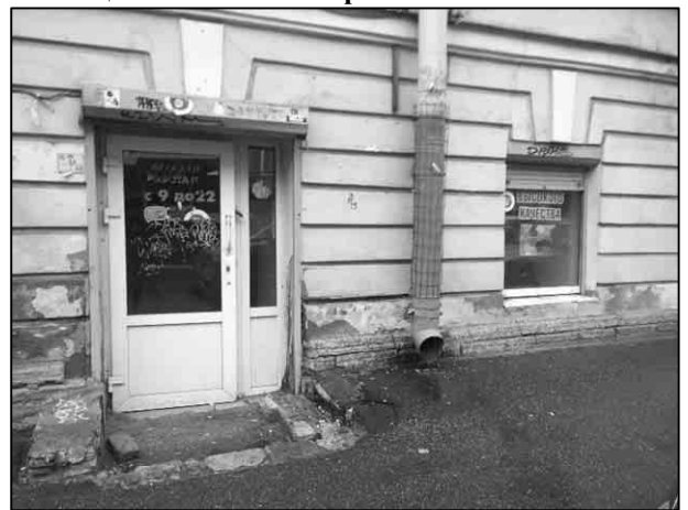
Фото 14. Отдельный вход с улицы и окно Объекта оценки (Лермонтовского пр.)
