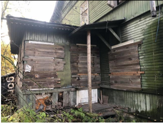
Фото 3. Вид на здание размещения Объекта оценки.
