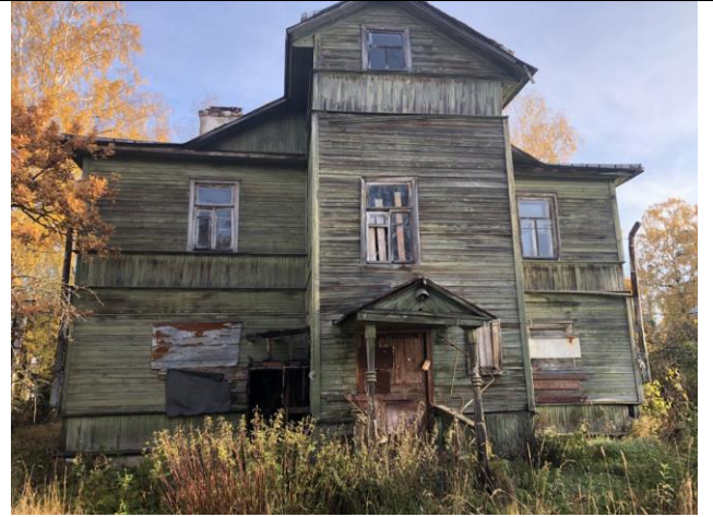
Фото 2. Вид на здание размещения Объекта оценки.
