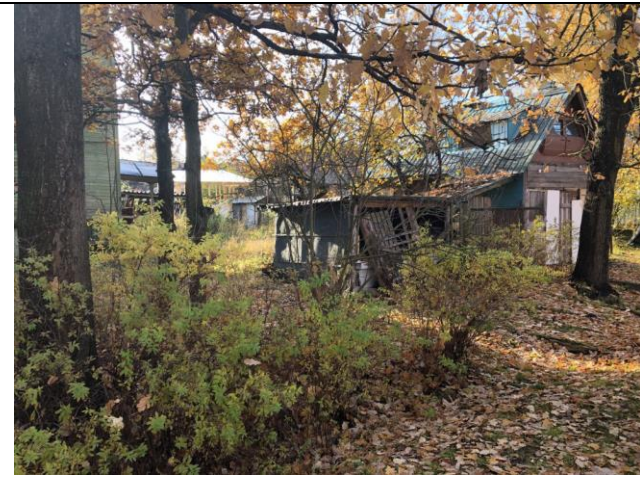
Фото 7. Вид на здание размещения Объекта оценки.
