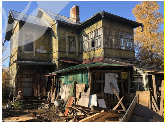
Фото 2. Вид на здание размещения Объекта оценки.
