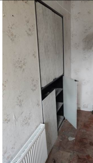
Фото 10 Общий вид и состояние помещений
