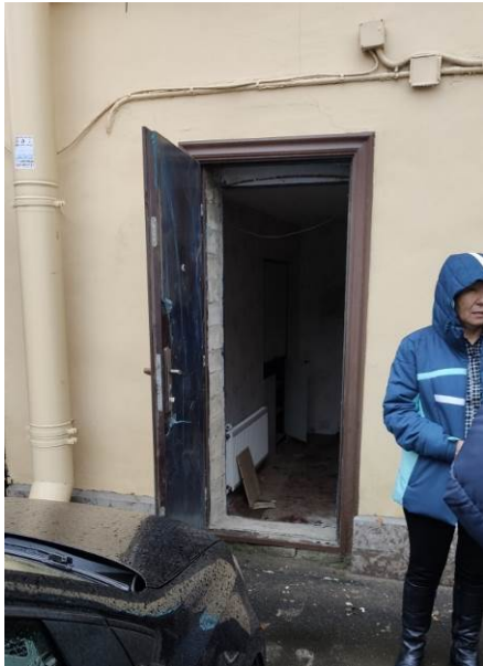
Фото 7 Вход в помещение
