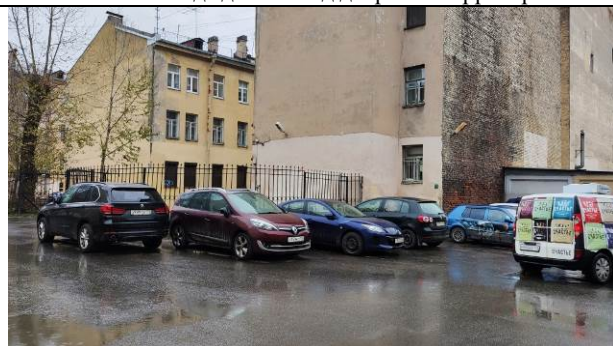
Фото 3 Фасад здания, внутридворовая территория
