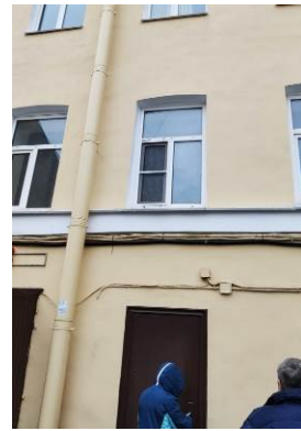
Фото 6 Фасад здания. Вход в помещение
