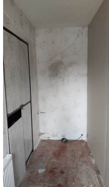
Фото 8 Общий вид и состояние помещений
