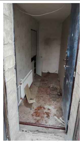
Фото 11 Общий вид и состояние помещений
