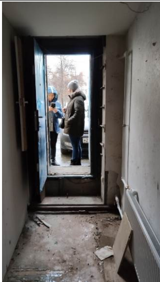
Фото 9 Общий вид и состояние помещений
