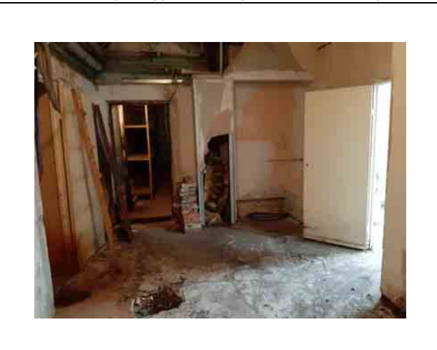
Фото 10 Общий вид и состояние помещения
