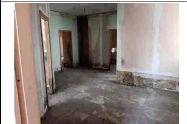
Фото 13 Общий вид и состояние помещения
