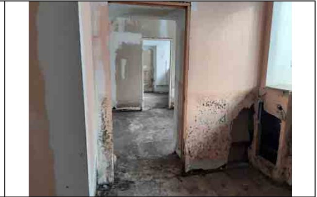
Фото 16 Общий вид и состояние помещения
