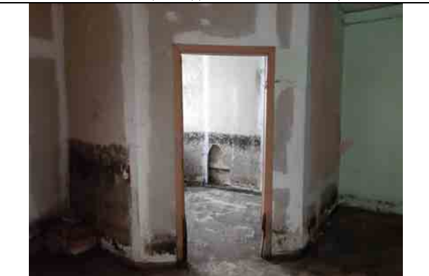
Фото 12 Общий вид и состояние помещения
