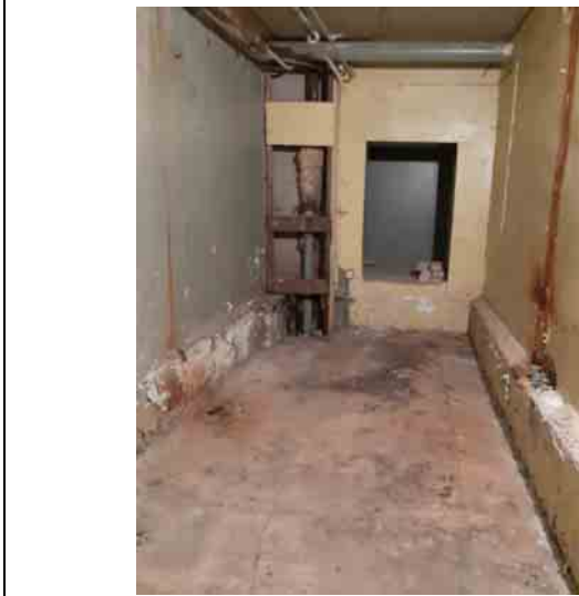
Фото 17 Общий вид и состояние помещения
