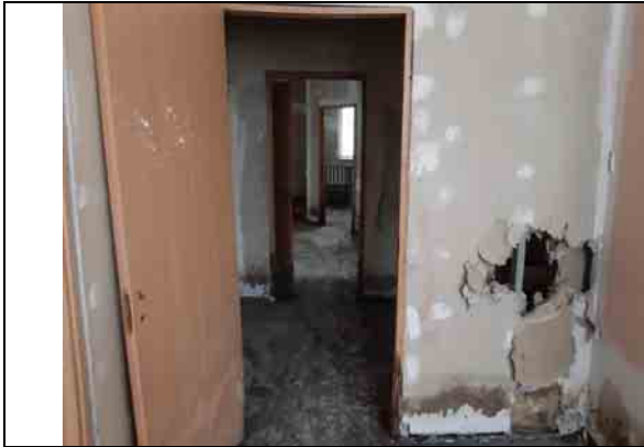
Фото 15 Общий вид и состояние помещения
