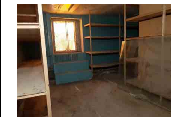
Фото 11 Общий вид и состояние помещения
