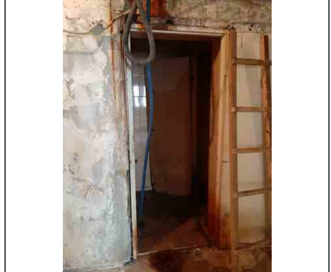
Фото 18 Общий вид и состояние помещения
