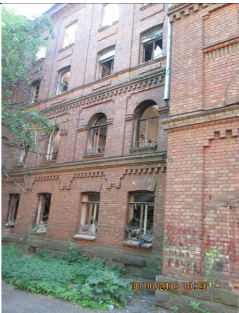
Фото 3. Состояние помещений Объекта оценки
