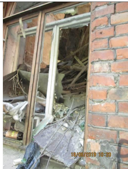
Фото 4. Состояние помещений Объекта оценки
