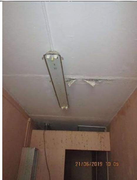
Фото 18. Общий вид и типичное состояние потолка в объекте оценки.
