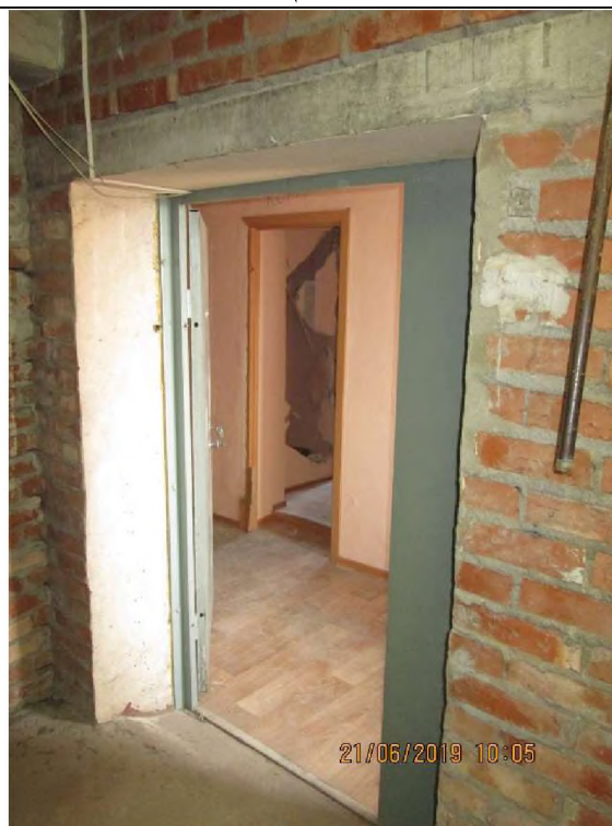
Фото 16. Общий вид и типичное состояние объекта оценки.
