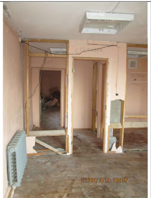
Фото 26. Общий вид и типичное состояние объекта оценки.
