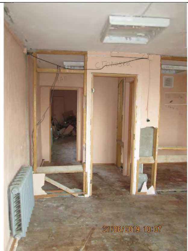
Фото 26. Общий вид и типичное состояние объекта оценки.
