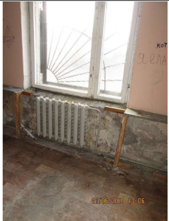
Фото 20. Общий вид и типичное состояние объекта оценки.
