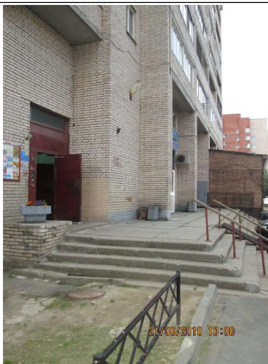
Фото 8. Общий вход в объект оценки со двора
