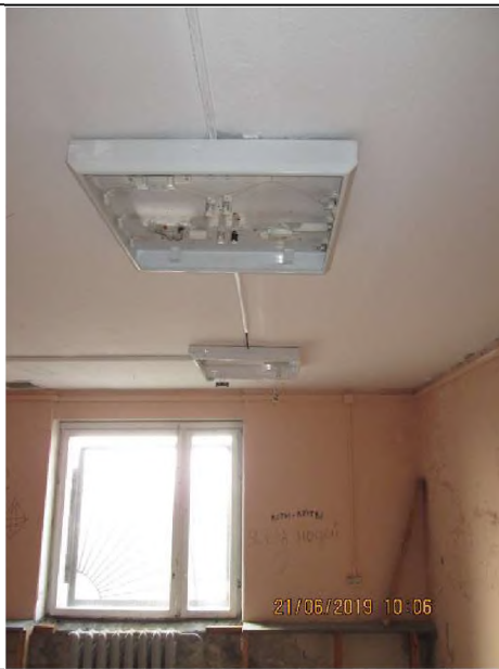
Фото 21. Общий вид и типичное состояние объекта оценки.
