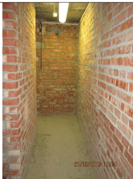
Фото 14. Общий вид и типичное состояние объекта оценки.
