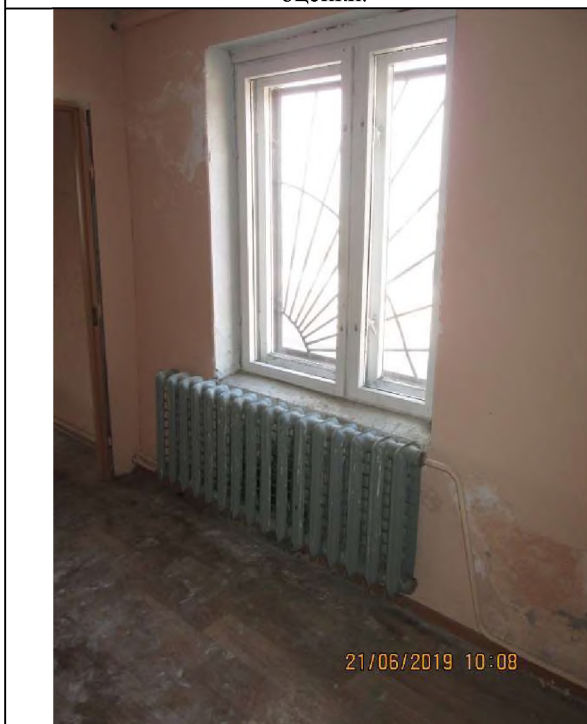
Фото 31. Общий вид и типичное состояние объекта оценки.
