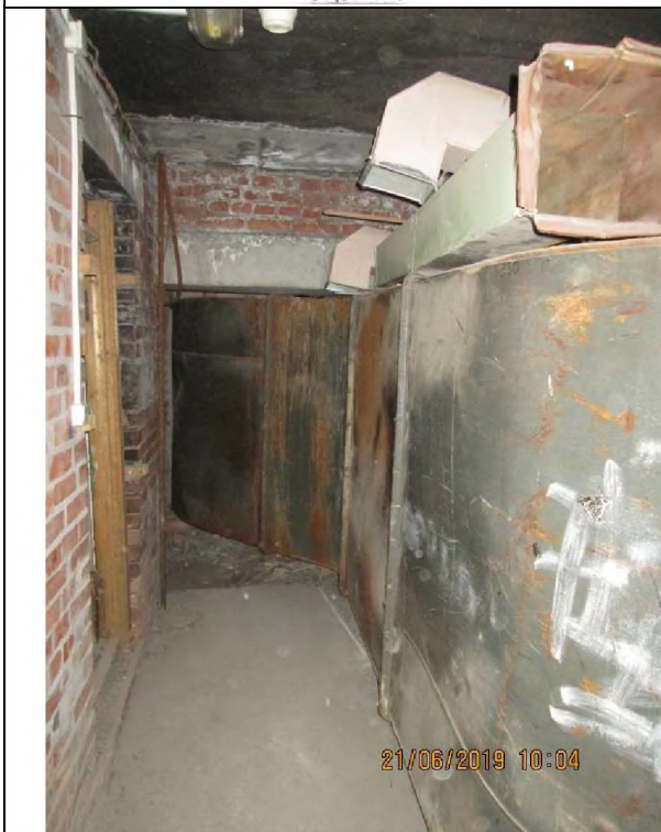
Фото 15. Общий вид и типичное состояние объекта оценки.
