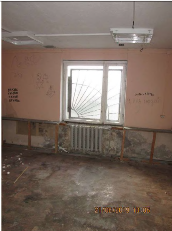
Фото 19. Общий вид и типичное состояние объекта оценки.
