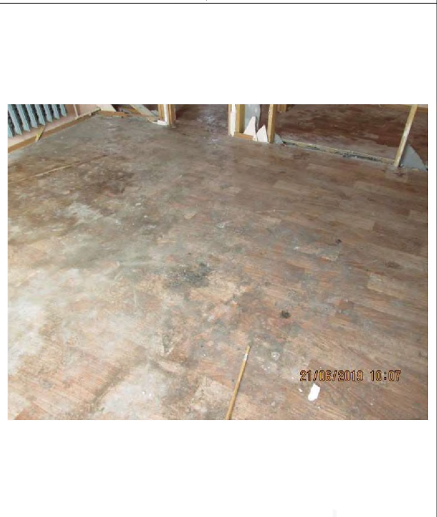
Фото 28. Общий вид и типичное состояние пола в объекте оценки.
