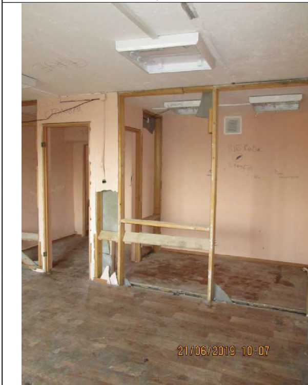
Фото 27. Общий вид и типичное состояние объекта оценки.
