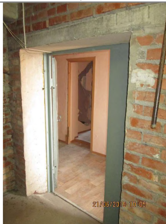
Фото 16. Общий вид и типичное состояние объекта оценки.
