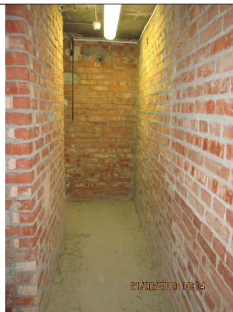
Фото 14. Общий вид и типичное состояние объекта оценки.
