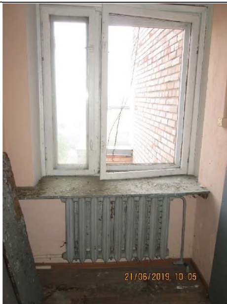
Фото 17. Общий вид и типичное состояние объекта оценки.
