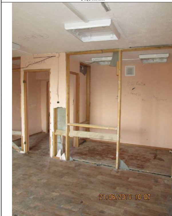
Фото 27. Общий вид и типичное состояние объекта оценки.
