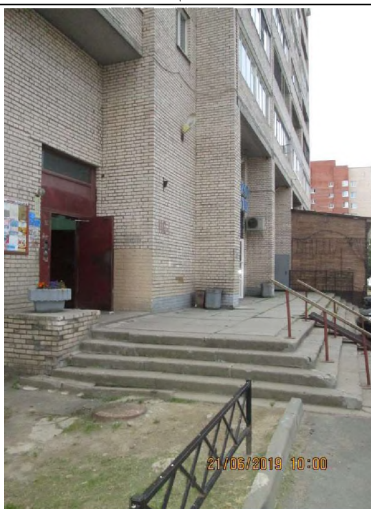
Фото 8. Общий вход в объект оценки со двора
