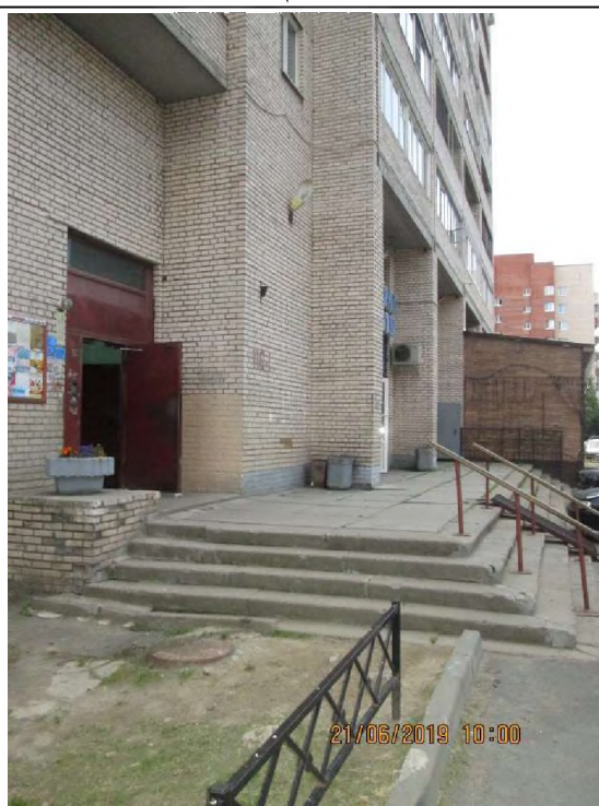
Фото 8. Общий вход в объект оценки со двора
