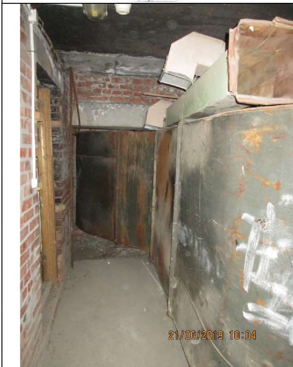
Фото 15. Общий вид и типичное состояние объекта оценки.
