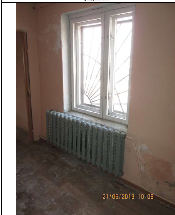
Фото 31. Общий вид и типичное состояние объекта оценки.
