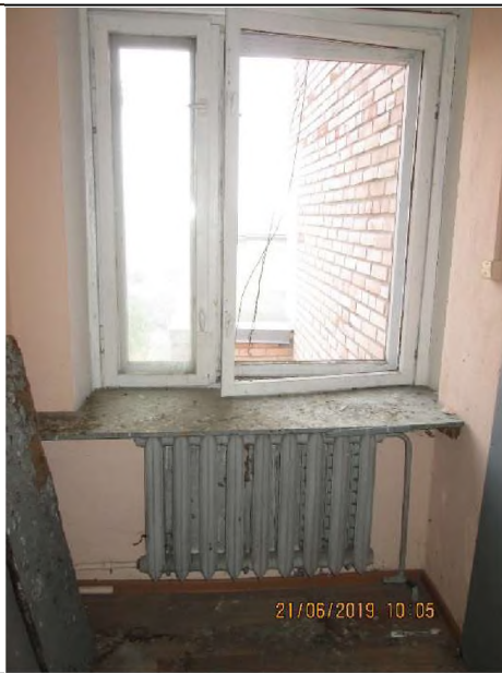
Фото 17. Общий вид и типичное состояние объекта оценки.
