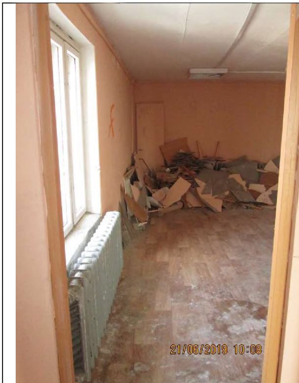
Фото 29. Общий вид и типичное состояние объекта оценки.
