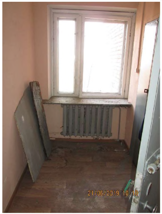
Фото 38. Общий вид и типичное состояние объекта оценки.
