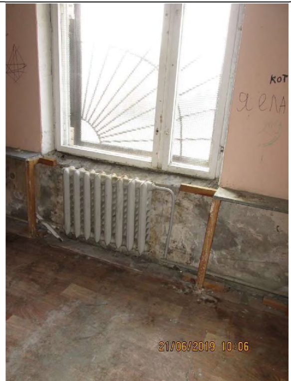
Фото 20. Общий вид и типичное состояние объекта оценки.
