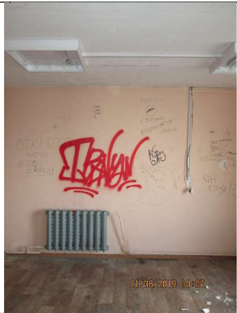
Фото 22. Общий вид и типичное состояние объекта оценки.
