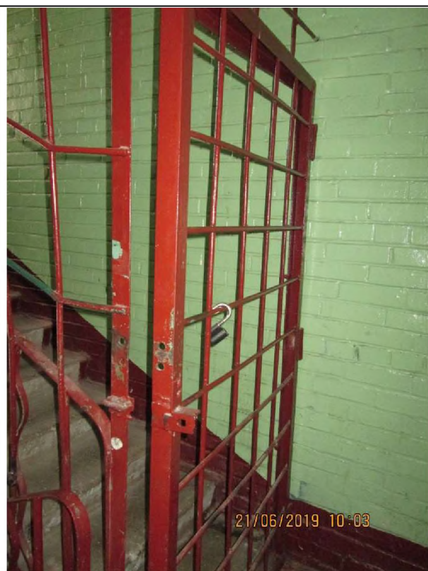
Фото 10. Проход к объекту оценки с лестничной площадки.
