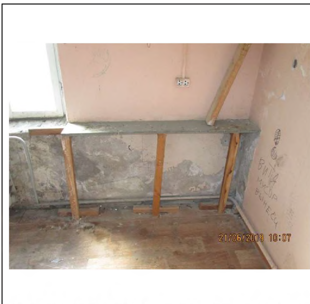
Фото 13. Общий вид и типичное состояние объекта оценки.
