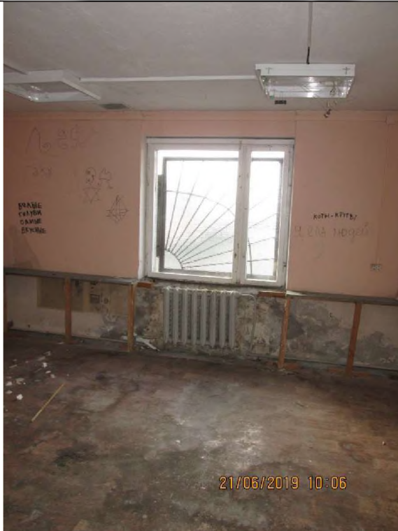
Фото 19. Общий вид и типичное состояние объекта оценки.
