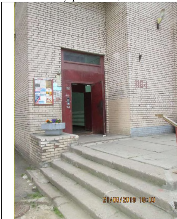
Фото 7. Общий вход в объект оценки со двора
