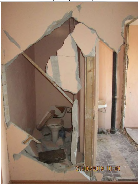
Фото 35. Общий вид и типичное состояние объекта оценки (санузел).
