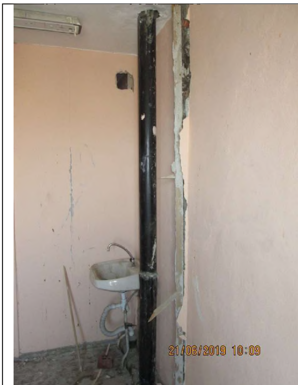
Фото 33. Общий вид и типичное состояние объекта оценки (санузел)
