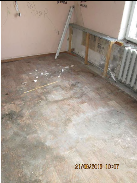
Фото 23. Общий вид и типичное состояние пола в объекте оценки.
