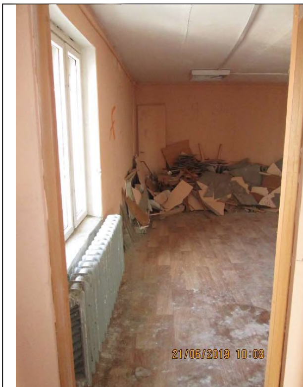
Фото 29. Общий вид и типичное состояние объекта оценки.
