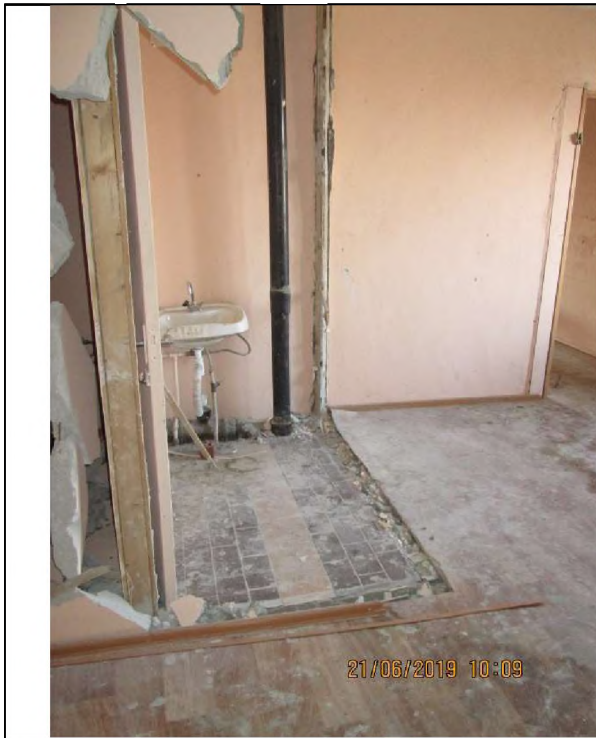
Фото 37. Общий вид и типичное состояние объекта оценки.
