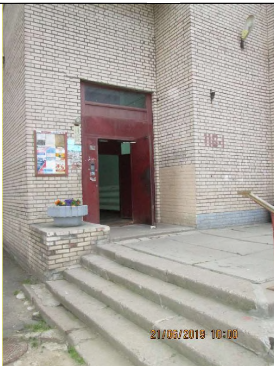
Фото 7. Общий вход в объект оценки со двора
