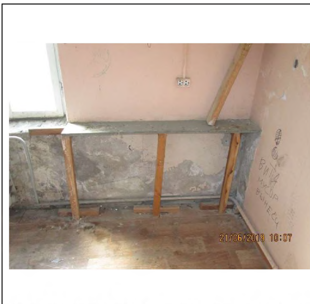
Фото 13. Общий вид и типичное состояние объекта оценки.
