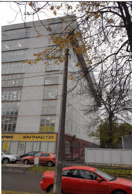
Фото 3. Вид на здание размещение объекта оценки.
