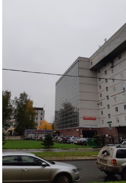
Фото 2. Вид на здание размещение объекта оценки.
