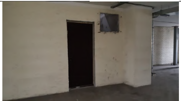
Фото 24. Вид на Объект оценки. Западной выход.
