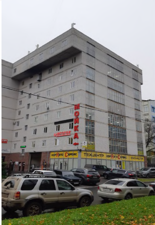
Фото 1. Вид на здание размещение объекта оценки.
