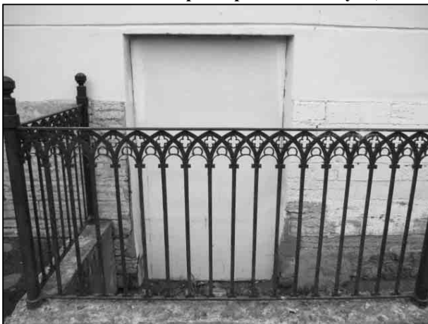
Фото 7. Отдельный вход с улицы (закрыт)
