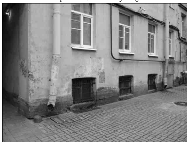
Фото 12. Типичное состояние оконных проемов, с ориентацией – во двор
