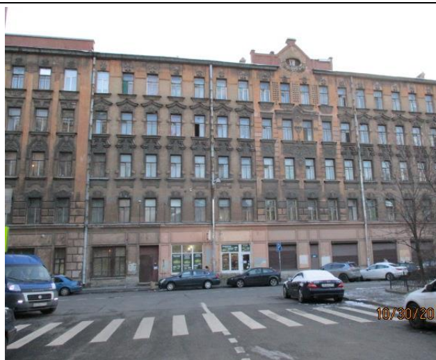
Фото 1. Вид здания, в котором расположен объект оценки
