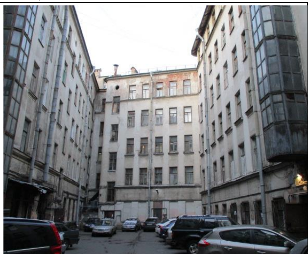
Фото 7. Вид здания, в котором расположен объект оценки
