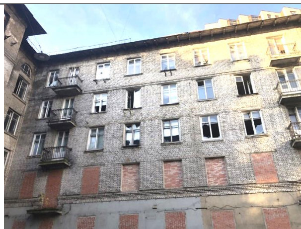
Фото 5. Вид на фасад здания расположения Объекта оценки со двора. Консервация объекта: кирпичная кладка оконных и дверных проемов
