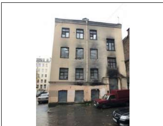
Фото 1. Вид на здание размещения Объекта оценки.
