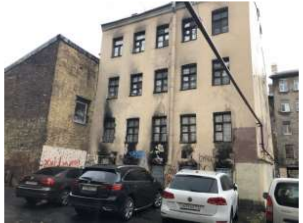
Фото 4. Вид на здание размещения Объекта оценки.
