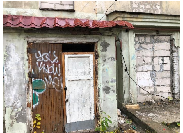
Фото 10. Вид взода в здание
