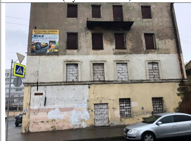
Фото 3. Вид на здание размещения Объекта оценки с Кемеровской улицы
