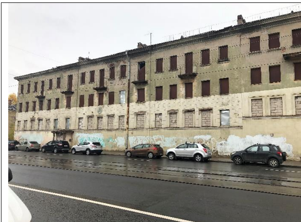
Фото 1. Вид на фасадную часть здания размещения Объекта оценки (с ул. Калинина)
