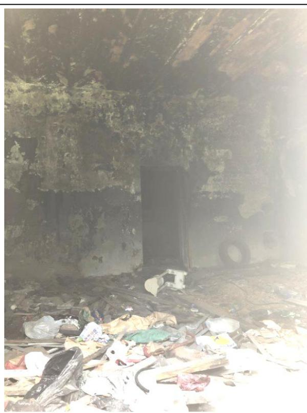
Фото 6. Внутреннее состояние помещений Объекта оценки: строительный мусор в результате разрушения полов, сырость стен и перекрытий, отсутствие дверных проемов
