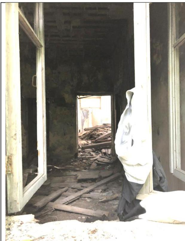
Фото 5. Внутреннее состояние помещений Объекта оценки: строительный мусор в результате разрушения (утраты) проемов, полов, внутренней отделки
