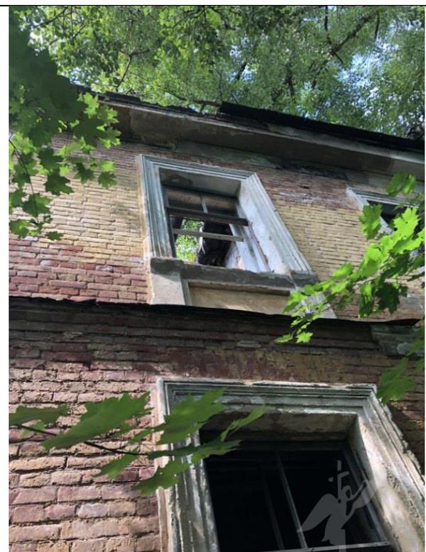
Фото 8. Состояние оконных проемов (утрата) и отсутствие остекления, пробоины в кровле
