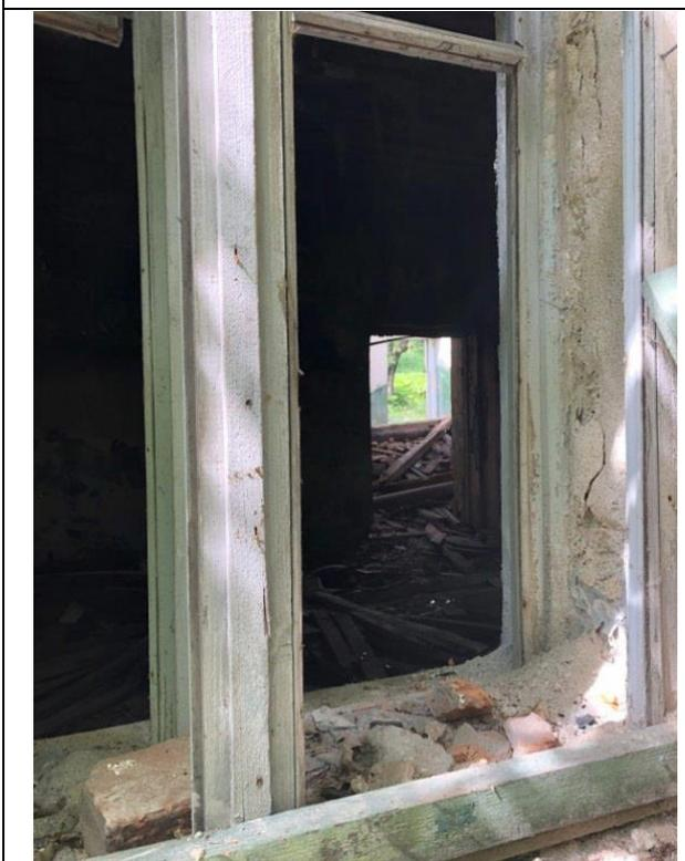
Фото 7. Состояние оконных проемов, отсутствие остекления
