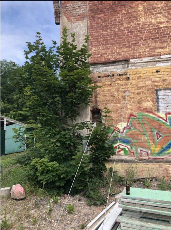
Фото 4. Выбоина и трещина в стене 1-го этажа здания, фасадом ориентированного на улицу Восстановления
