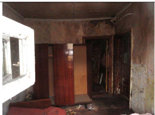
Фото 10. Внутреннее состояние оцениваемого здания
