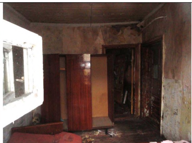
Фото 10. Внутреннее состояние оцениваемого здания
