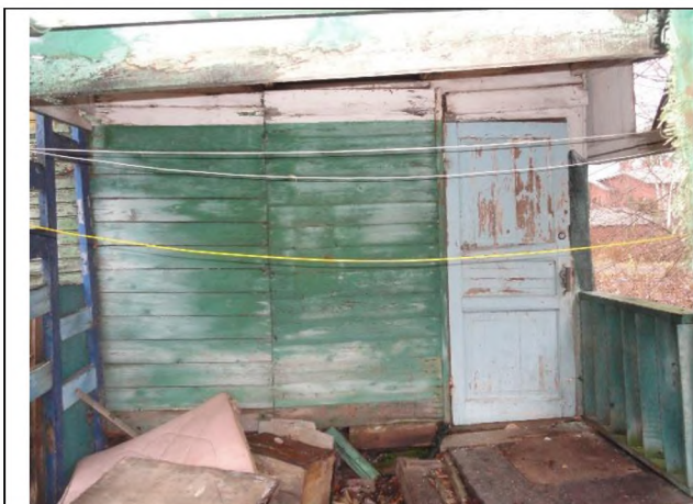
Фото 9. Состояние оцениваемого здания
