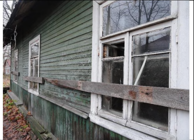
Фото 8. Состояние оцениваемого здания
