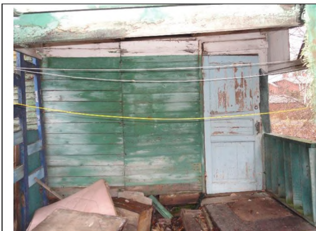
Фото 9. Состояние оцениваемого здания
