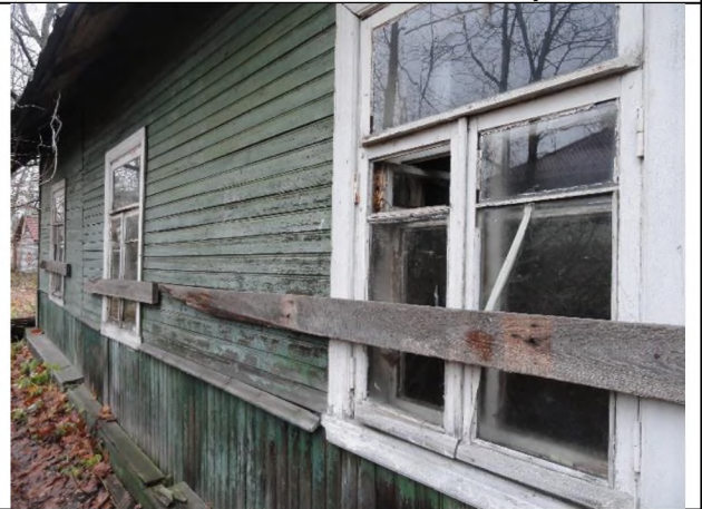
Фото 8. Состояние оцениваемого здания
