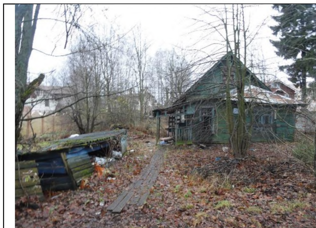
Фото 1. Вид на оцениваемое здание с 1-го Торфяного переуллка
