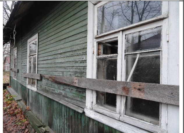
Фото 8. Состояние оцениваемого здания
