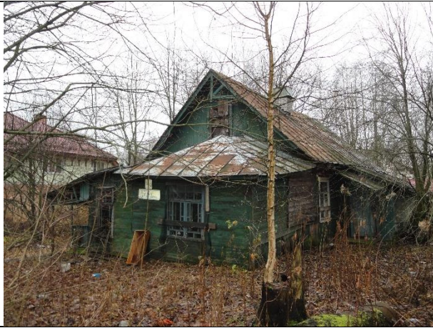
Фото 3. Вид на оцениваемое здание со стороны 1-го Торфяного переулка
