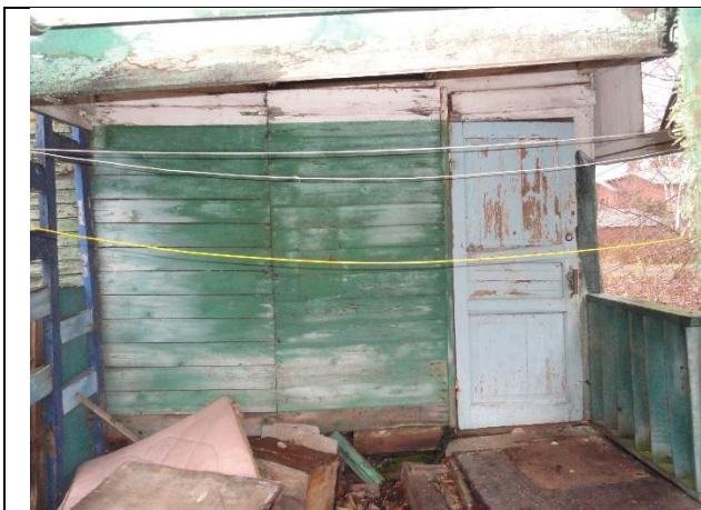
Фото 9. Состояние оцениваемого здания
